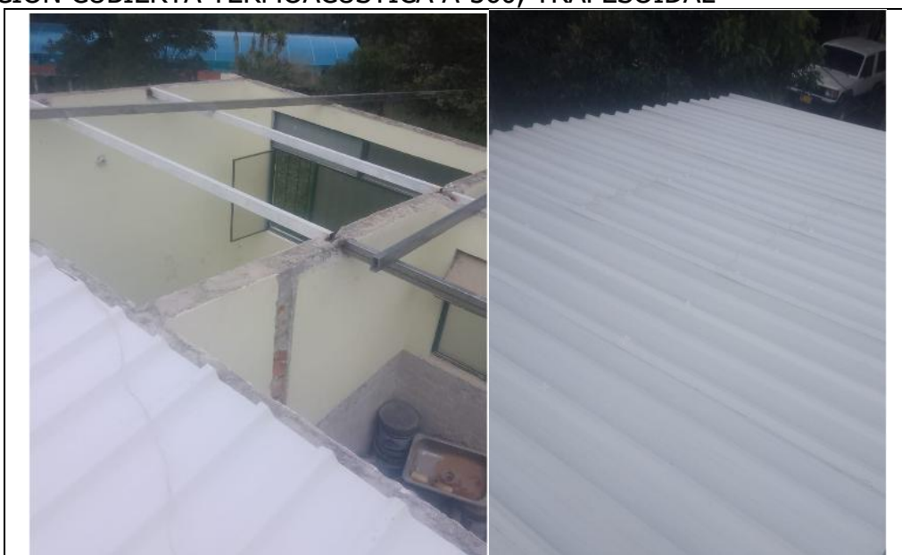
Ilustración 2 – INSTALACIÓN DE CUBIERTA
