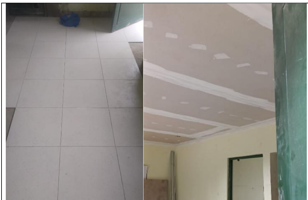
Ilustración 1 – INSTALACION CERAMICA Y CIELO FALSO
