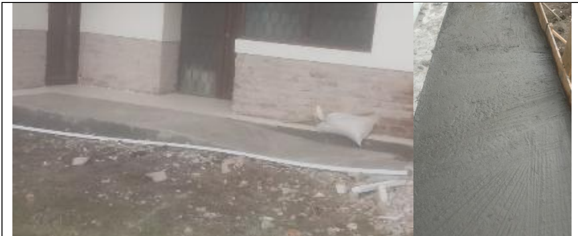
• Ilustración 5 – INSTALACIÓN DE CUBIERTA
