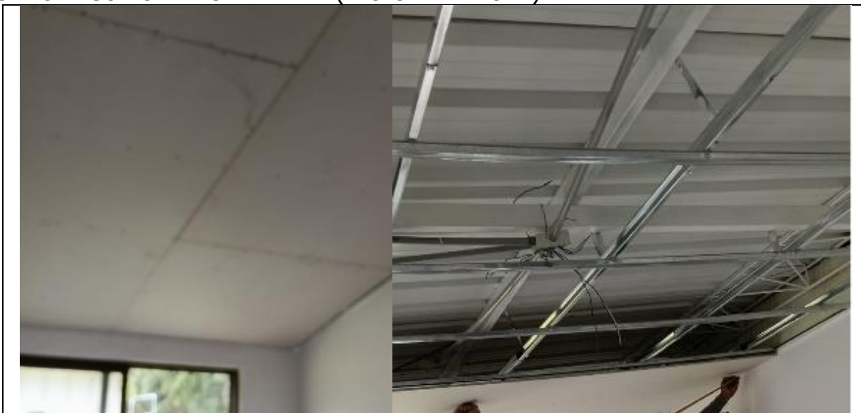
• Ilustración 3 – INSTALACIÓN CIELO FALSO
