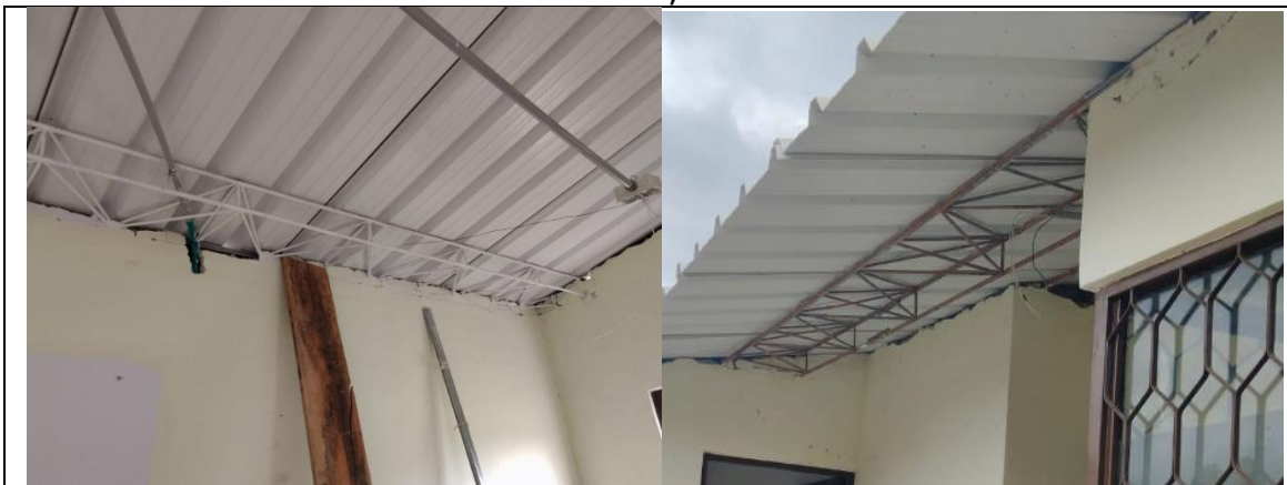
• Ilustración 4 – INSTALACIÓN DE CUBIERTA
