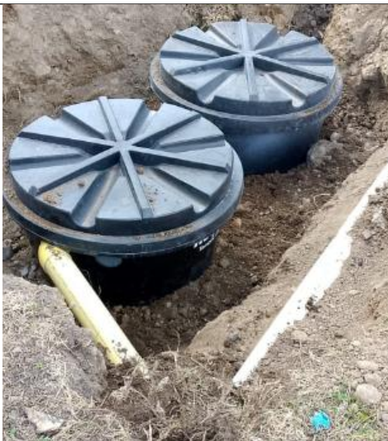
Ilustración 2 – VISTA SISTEMA SEPTICO
