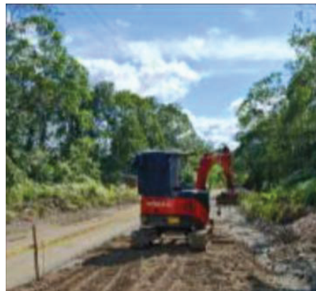
FOTO 02: Excavación de material común e instalación de Subbase
