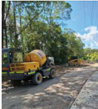
FOTO 01: Preparación del Suelo
