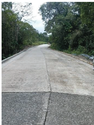
FOTO 08: Final de la construcción del pavimento
