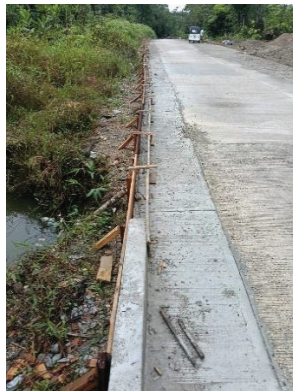
FOTO 05: Bordillo de concreto
