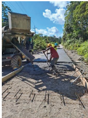
FOTO 02: Fundida de Pavimento en Concreto Clase D
