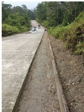
FOTO 06: Formaleteria y Preparación de terreno de Cuneta Margen Derecho
