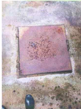
TAPAS DEL TANQUE DEL GIGANTE DAÑADAS
