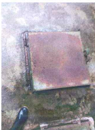
TAPAS DEL TANQUE DEL GIGANTE DAÑADAS
