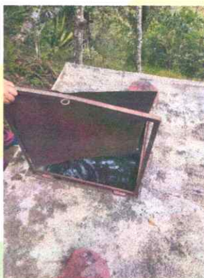
TAPAS DEL TANQUE DEL GIGANTE DAÑADAS
