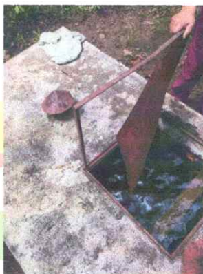
TAPAS DEL TANQUE DEL GIGANTE DAÑADAS
