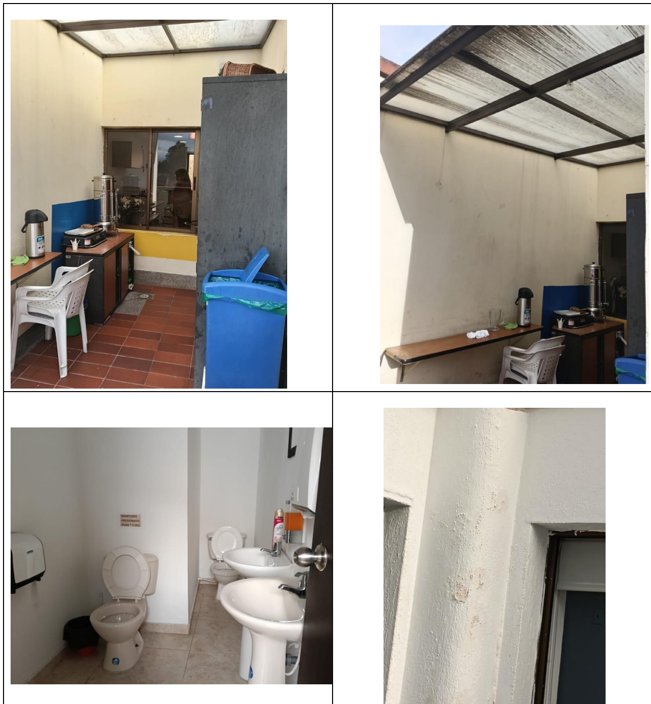
Ilustración 5. Estado actual piso 4 y terraza
