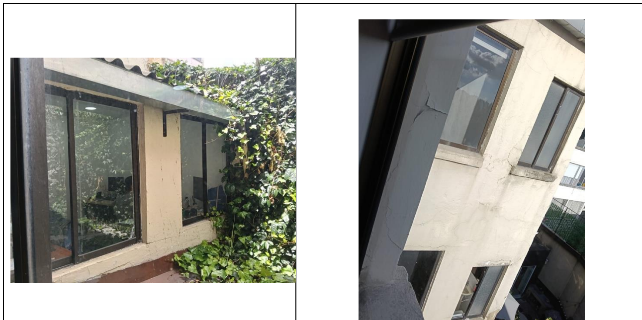
Ilustración 6. Estado Actual fachada exterior e interior
