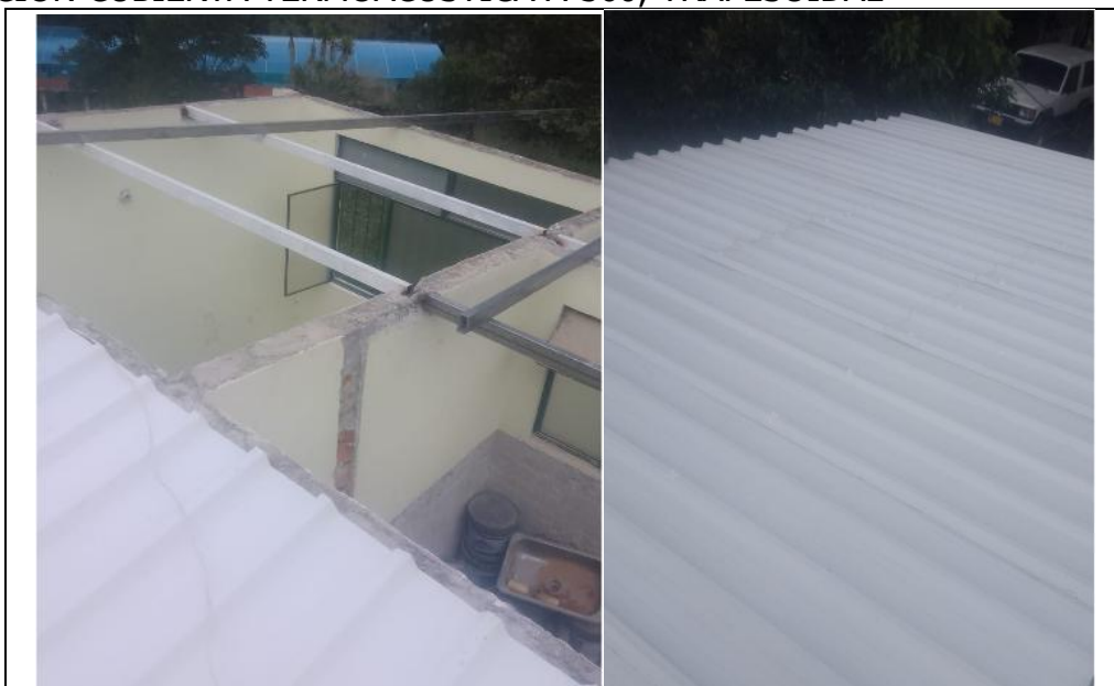
Ilustración 2 – INSTALACIÓN DE CUBIERTA
