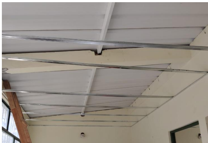
Ilustración 4 – INSTALACIÓN DE ESTRUCTURA METALICA PARA CIELO FALSO
