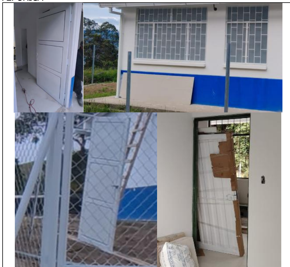
Ilustración 1 – VISTA PUERTAS NUEVAS Y DE MANTENIMIENTO, VENTANAS MANETNIMIENTO Y VIDRIOS.
