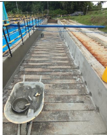
Fotografía 16 Resane e impermeabilización floculadores
