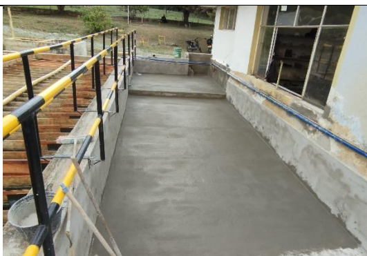
Fotografía 15. Resane e impermeabilización floculadores
