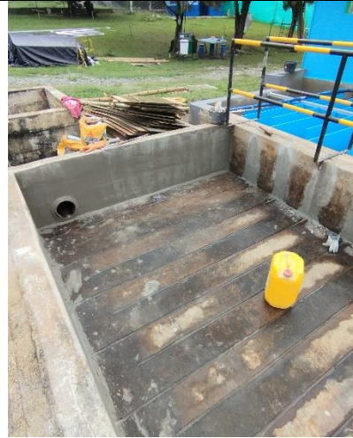
Fotografía 14. Resane e impermeabilización floculadores
