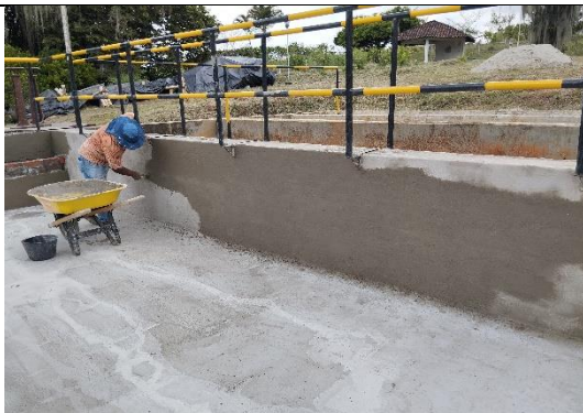
Fotografía 13. Resane e impermeabilización floculadores
