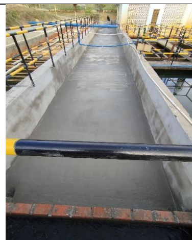
Fotografía 18. Resane e impermeabilización floculadores
