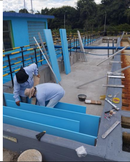
Fotografía 36. Instalación de placas en fibra de vidrio floculador 2
