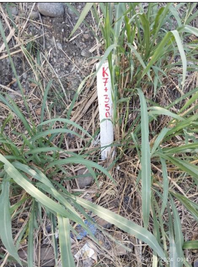
Fotografía 39. Abscisado de la vía para instalación de tubería
