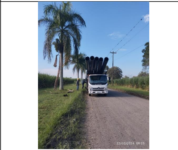
Fotografía 44. Trasiego de tubería sitio de pega
