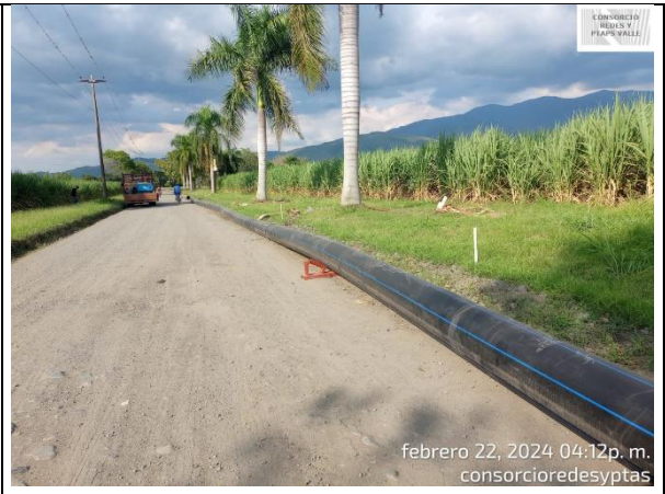
Fotografía 48. Tramos de Tubería PEAD 14" pegada
