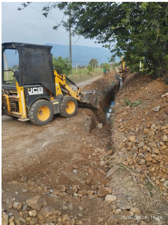
Ilustración 17 Aprovechamiento de Material de Excavación
