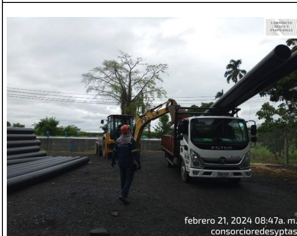
Fotografía 43. Trasiego de tubería sitio de acopio
