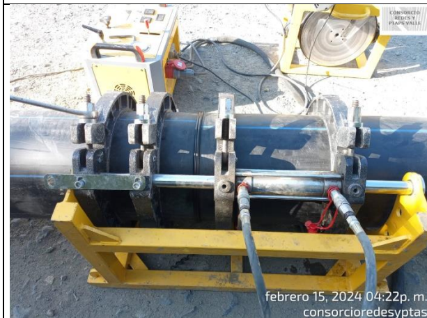
Fotografía 453. Pega tubería PEAD 14" por termofusión (1)
