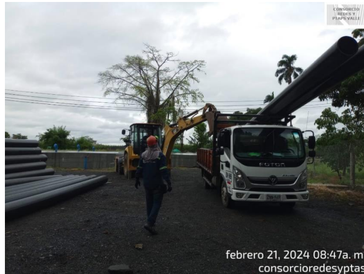
Ilustración 19 Acopio de Tubería
