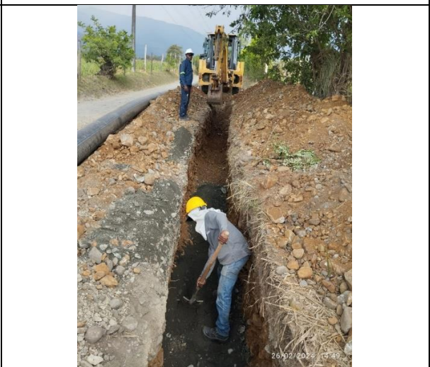
Fotografía 52. Instalación del colchón para la tubería
