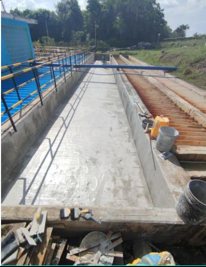
Fotografía 35. Impermeabilización floculador 2
