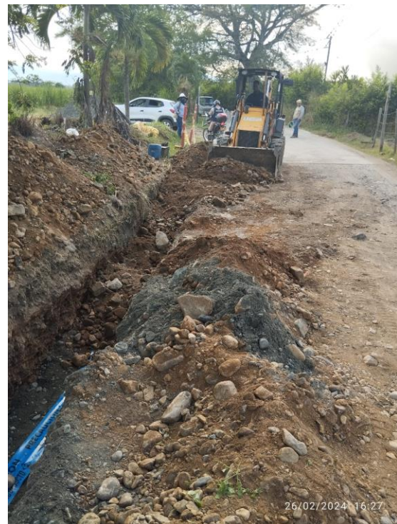
Ilustración 17 Aprovechamiento de Material de Excavación
