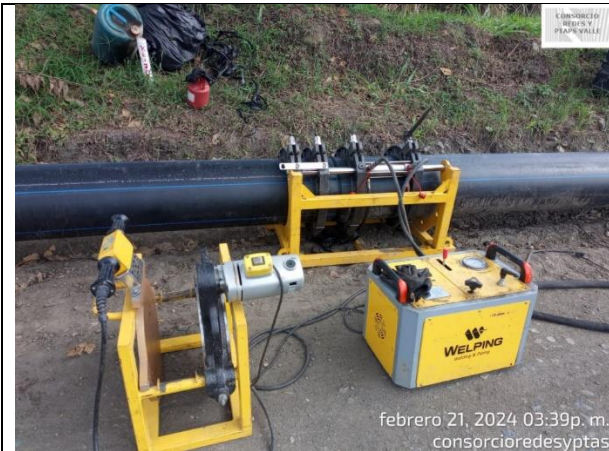
Fotografía 47. Pega tubería PEAD 14" por termofusión (2)
