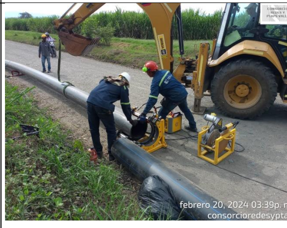
Fotografía 46. Alineación para pega de tubería PEAD
