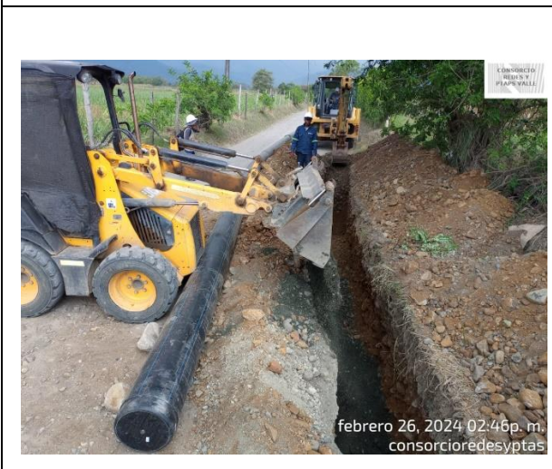
Fotografía 51. Vaciado del material para colchón de la tubería
