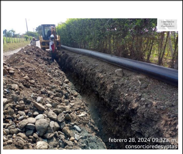
Fotografía 50. Excavación a máquina (2)
