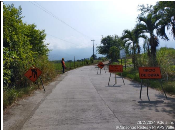
Fotografía 42. Señalización en la vía
