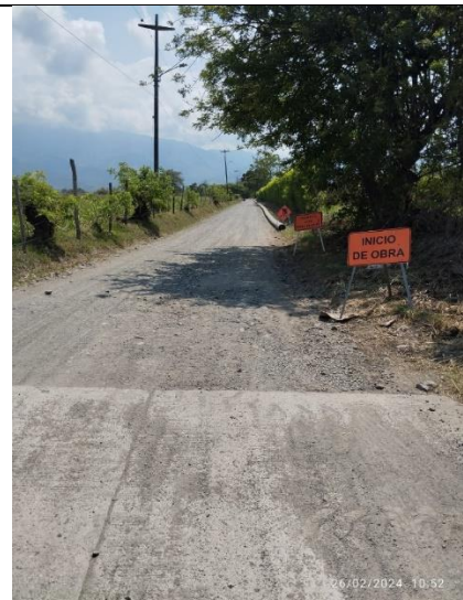
Fotografía 40. Señalización en el sitio de inicio de excavaciones.
