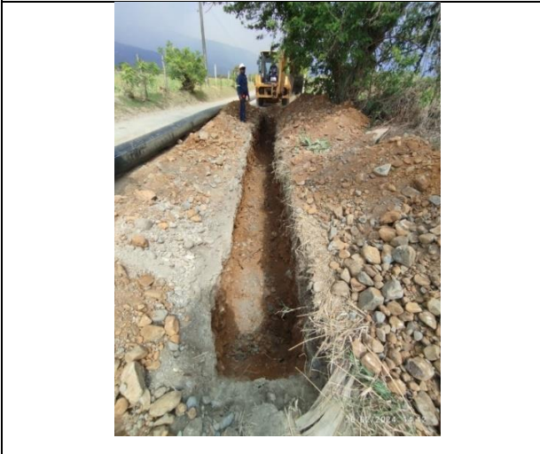
Fotografía 49. Excavación a máquina (1)
