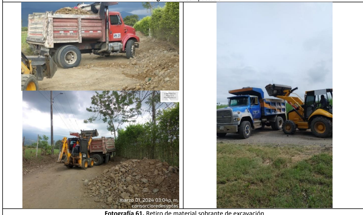
Fotografía 61. Retiro de material sobrante de excavación
