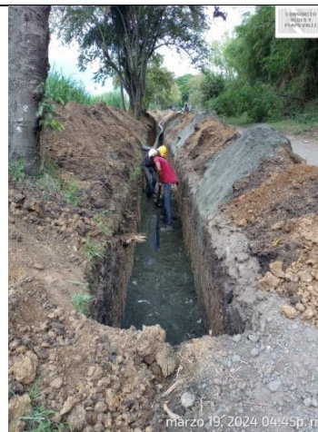
Fotografía 56. Relleno con material seleccionado 15 cm por encima de la clave de la tubería
