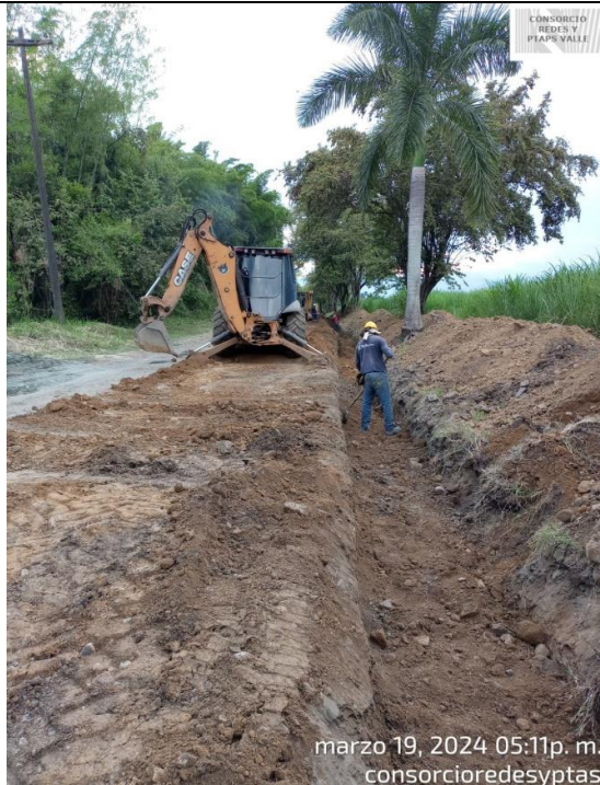
Fotografía 59. Relleno con material de sitio
