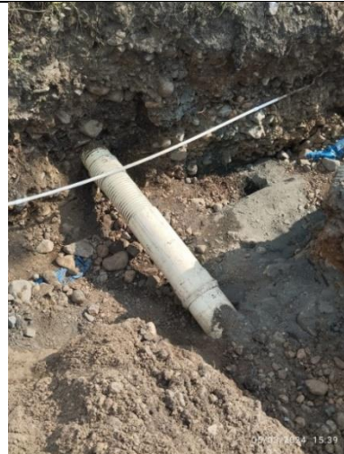
Fotografía 67. Reparación tubería de riego 10\" PVC del ingenio Pichichi
