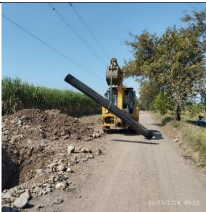
Fotografía 50. Trasiego de tubería
