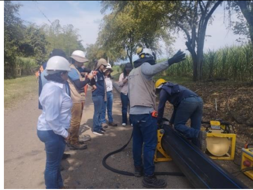
Fotografía 48. Recorrido de obra con Entidad contratante, interventoría, administración local de Guacarí, contratista y operador de las plantas.
