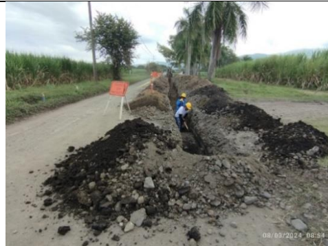
Fotografía 65. Apiques para encontrar las tuberías del ingenio Pichichi y ACUAVALLE
