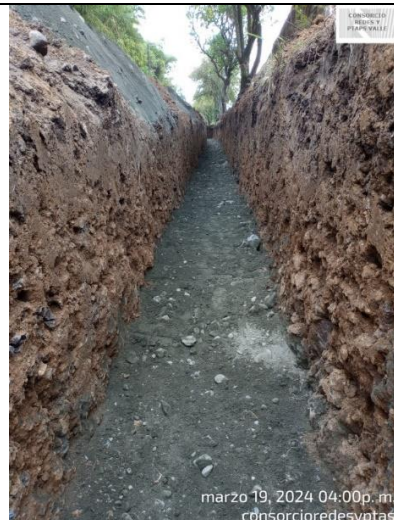
Fotografía 54. Instalación de colchón de material seleccionado
