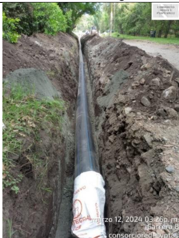
Fotografía 55. Instalación de tubería PEAD de 14"
