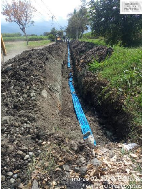
Fotografía 57. Instalación de cinta testigo
