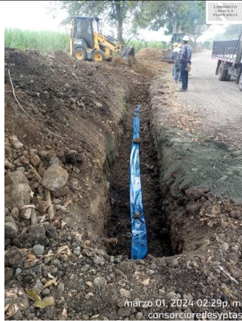
Fotografía 58. Relleno con material de sitio
