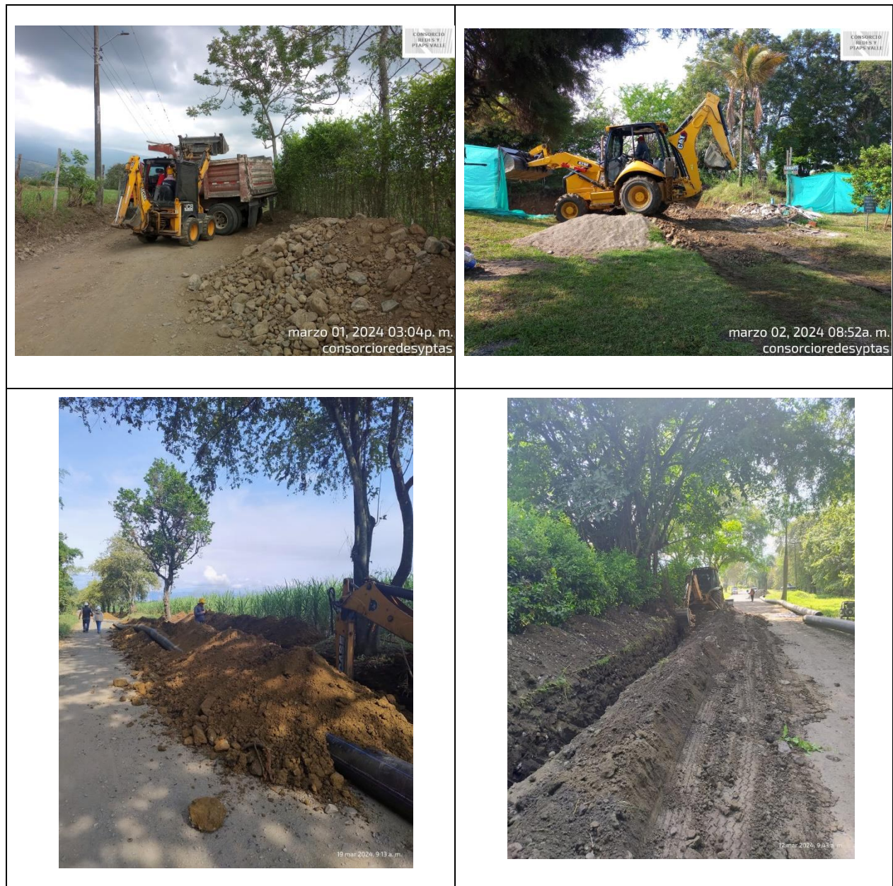
Ilustración 17 Manejo de Material de Excavación
