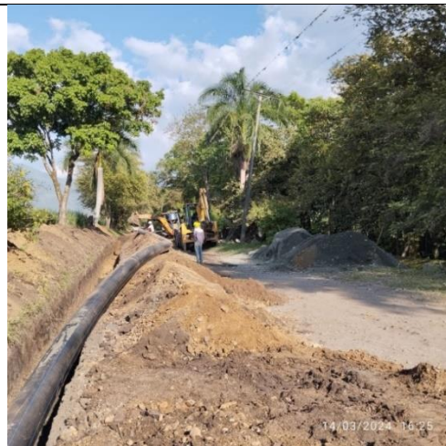
Fotografía 55. Instalación de tubería PEAD de 14"
