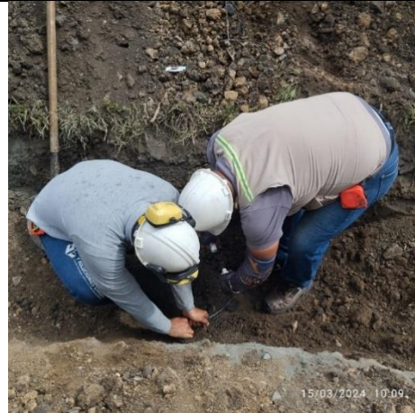
Fotografía 70. Reparación de acometida PEAD de 16 mm
