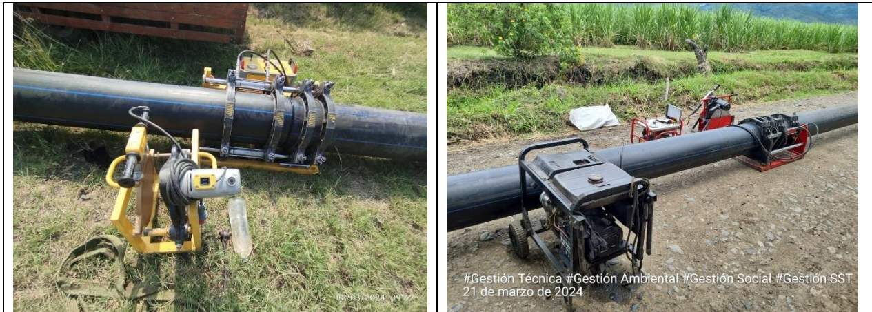
Fotografía 52. Pega de tubería PEAD de 14" por termofusión
