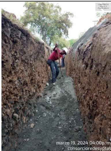
Fotografía 54. Instalación de colchón de material seleccionado
