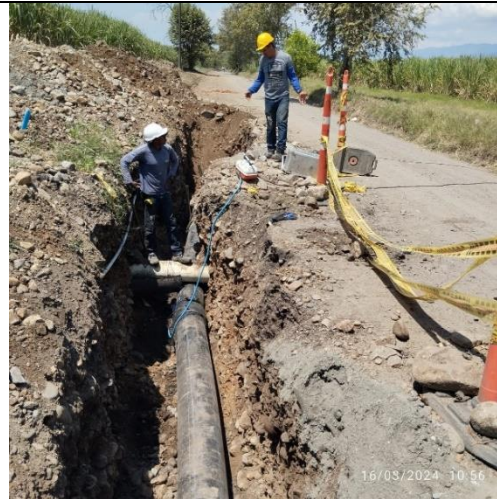
Fotografía 63. Instalación de uniones de electrofusión
