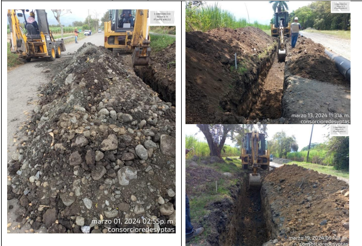
Fotografía 53. Excavación a maquina
