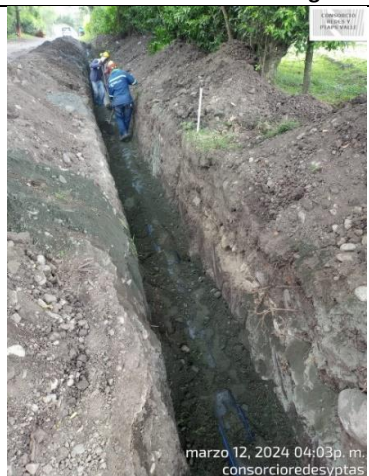
Fotografía 56. Relleno con material seleccionado 15 cm por encima de la clave de la tubería
