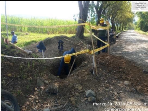
Fotografía 64. Apiques para encontrar las tuberías del acueducto del ingenio Pichichi
