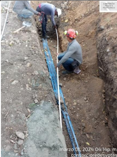
Fotografía 66. Reparación tubería \frac{3}{4} \" PVC acueducto El Placer
