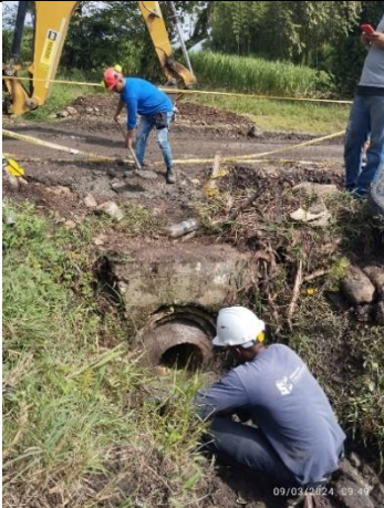
Fotografía 69. Reparación tubería de concreto del ingenio Pichichi
