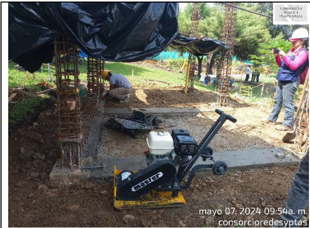
Fotografía 9. Se realiza lleno y compactación de material de préstamo (Roca Muerta) para construcción de Vigas de cimentación y Losa de la Caseta Eléctrica.
