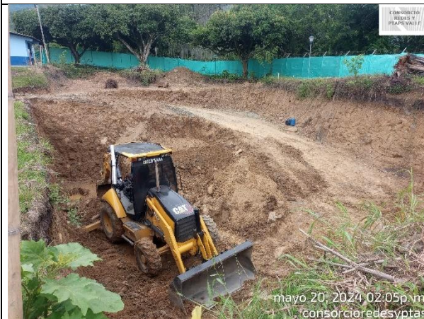
Fotografía 43. Continúan con la excavación para la construcción del tanque de almacenamiento de agua en la PTAP Ginebra.
