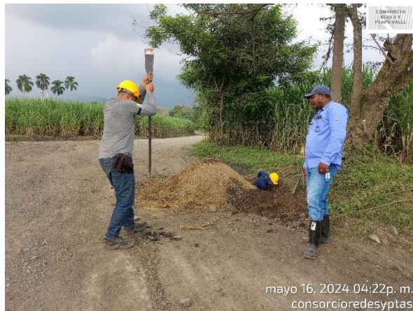
Fotografía 31. Apiques para identificación de tubería de acueducto de 3" y Tubería Madre de Ingenio Pichicho (20").
