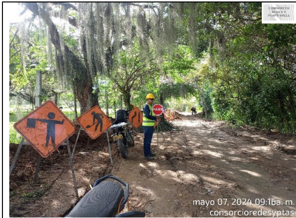
Fotografía 5. Instalación de señales sobre el tramo intervenido.
