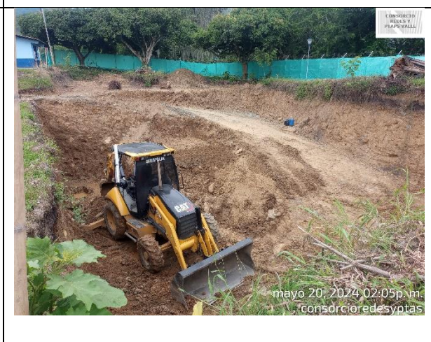
Fotografía 48. Continúan con la excavación para la construcción del tanque de almacenamiento de agua en la PTAP Ginebra.
