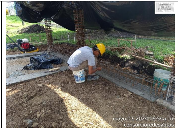
Fotografía 10. Instalación de refuerzo de las Vigas de cimentación de la caseta eléctrica (PTAP Ginebra).
