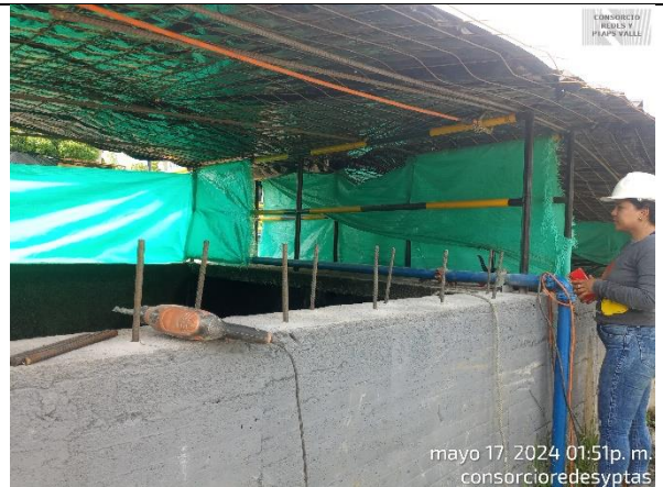
Fotografía 34. Perforación de muros e instalación de refuerzo para anclajes de realce de muro del sedimentador No. 3.
