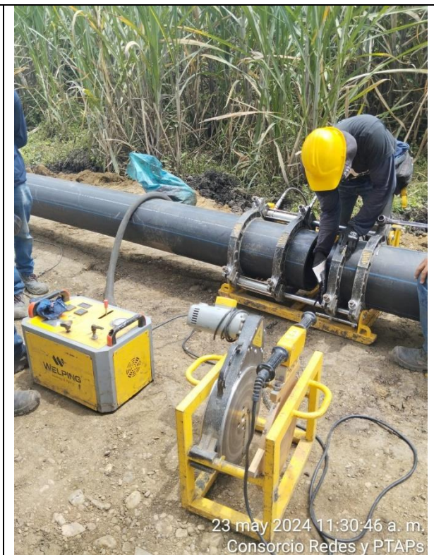
Fotografía 46. Supervisión a los tiempos y proceso de la pega de la tubería de 14" PEAD la cual será instalada en el tramo 3.
