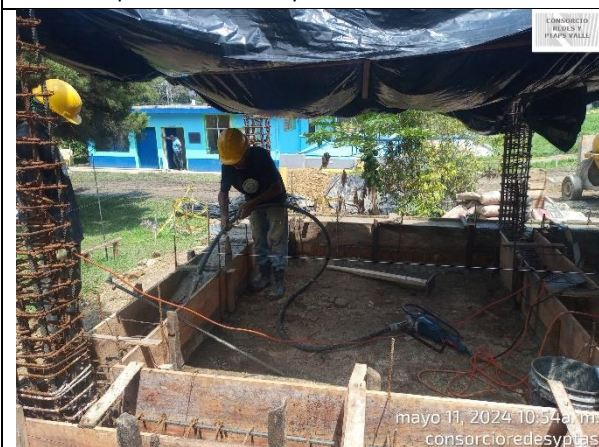
Fotografía 23. Se funden las vigas de cimentación de la caseta eléctrica de la PTAP Ginebra.
