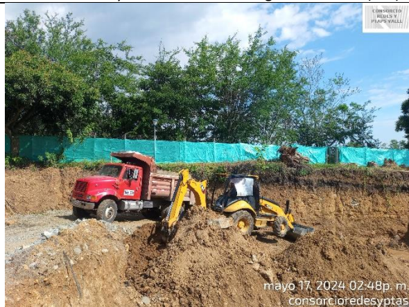
Fotografía 33. Retiro de Material Sobrante de excavación para la construcción del tanque de almacenamiento de agua de la planta Ginebra.
