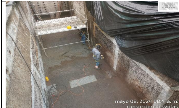
Fotografía 17. Continúan con la escarificación de muro para garantizar ortogonalidad en los muros.
