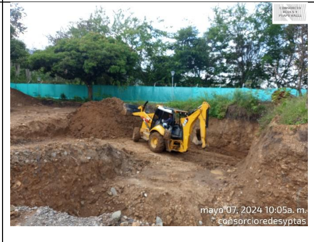
Fotografía 16. Continúan con la excavación para la construcción del tanque de almacenamiento de agua en la PTAP Ginebra.
