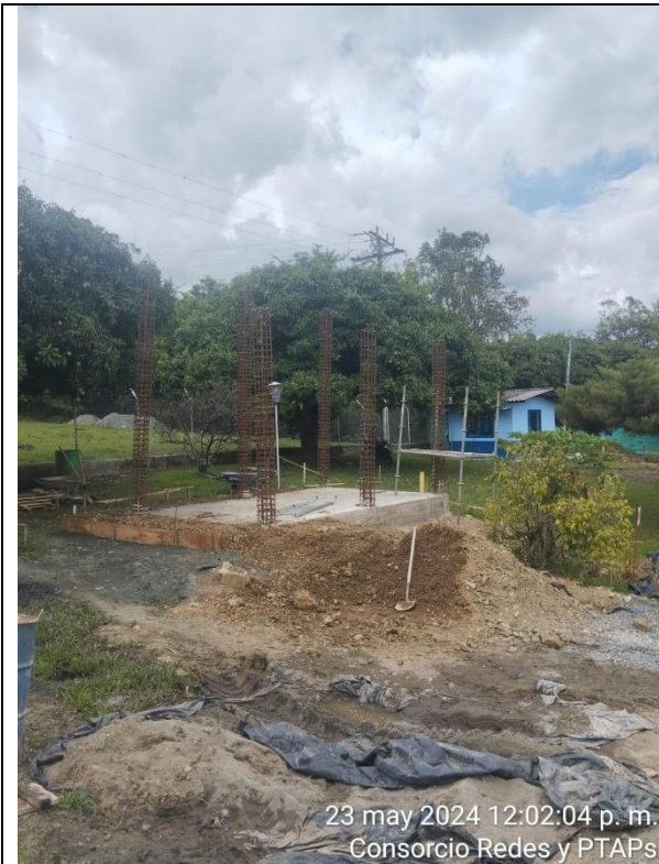
Fotografía 41. Se inicia con los rellenos perimetrales a la caseta eléctrica para conformación de andén.
