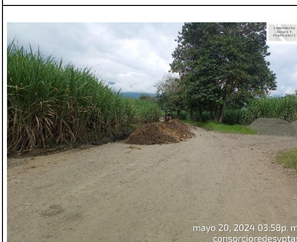
Fotografía 47. Suministro de balastro para colcho de tubería y acopio de material sobrante que será enviado al sitio de disposición final.
