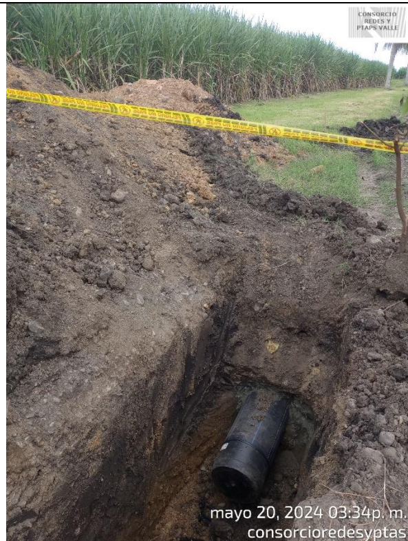
Fotografía 51. Instalación de Tapones para realización de pruebas hidrostáticas en la tubería instalada en el tramo 3.
