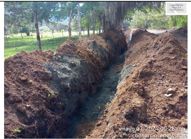
Fotografía 6. Se realiza el lleno por capas y se compacta de acuerdo a las especificaciones y sujeto al tamaño del material.
