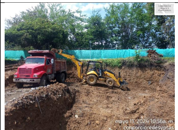
Fotografía 24. Continúan con la excavación para la construcción del tanque de almacenamiento de agua en la
