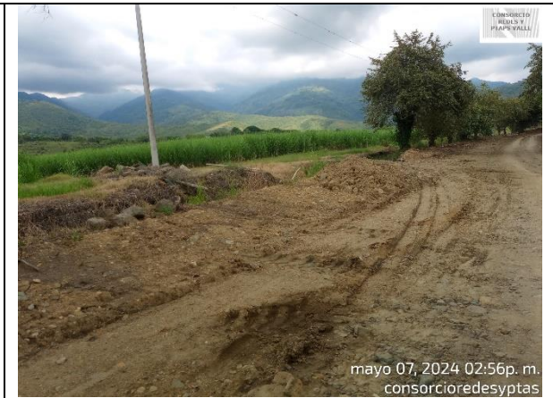
Fotografía 14. Se realiza la compactación de la rasante de la vía para garantizar que la vía no presente asentamientos por el flujo de vehículos en el tramo.
