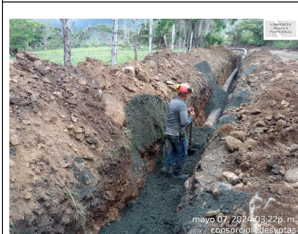
Fotografía 15. Continúan con la instalación de tubería de 14" sobre el tramo 3, se instala la cinta de prevención y se realiza el lleno como se concilio con la interventoría.
