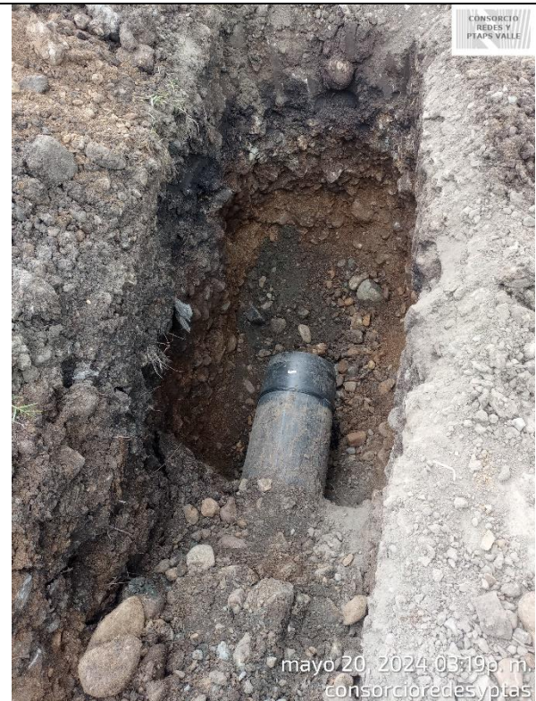
Fotografía 52. Instalación de Tapones para realización de pruebas hidrostáticas en la tubería instalada en el tramo 3.
