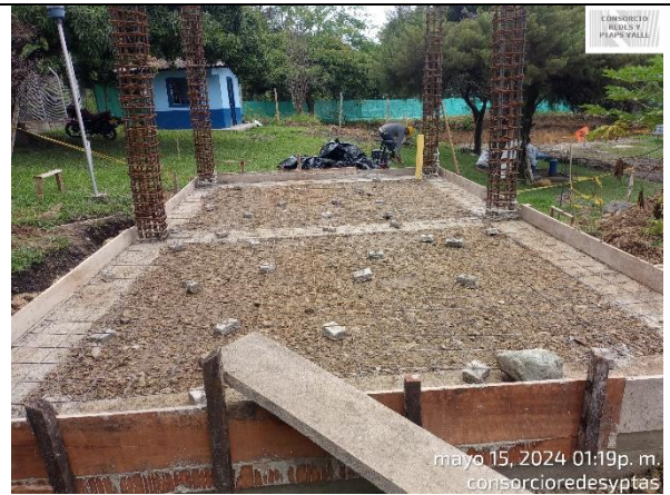
Fotografía 32. Instalación de Malla electrosoldada en la losa de la caseta eléctrica de la PTAP Ginebra.
