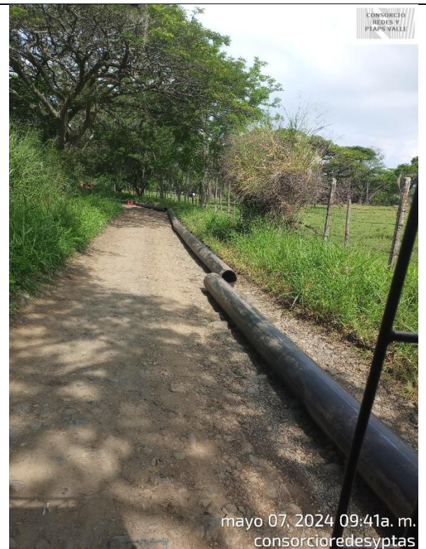
Fotografía 8. Trasiego de tubería en el tramo 3, sector de la Hacienda la Esmeralda.
