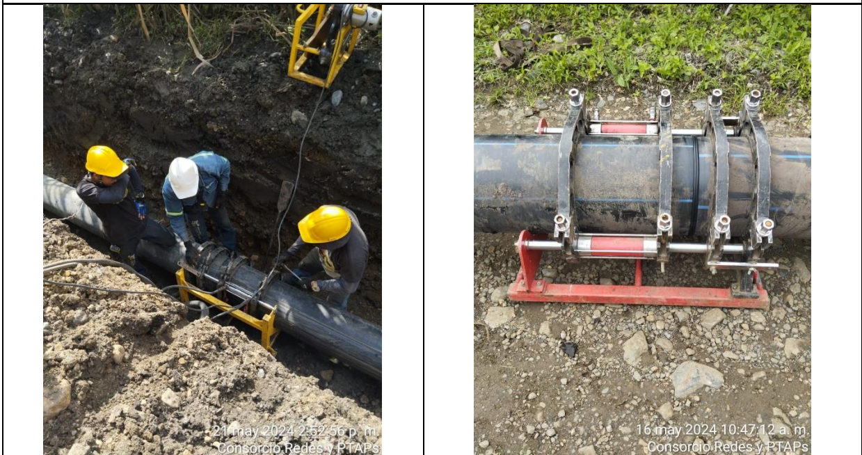
Fotografía 66. Pega de tubería PEAD de 14" por termofusión
