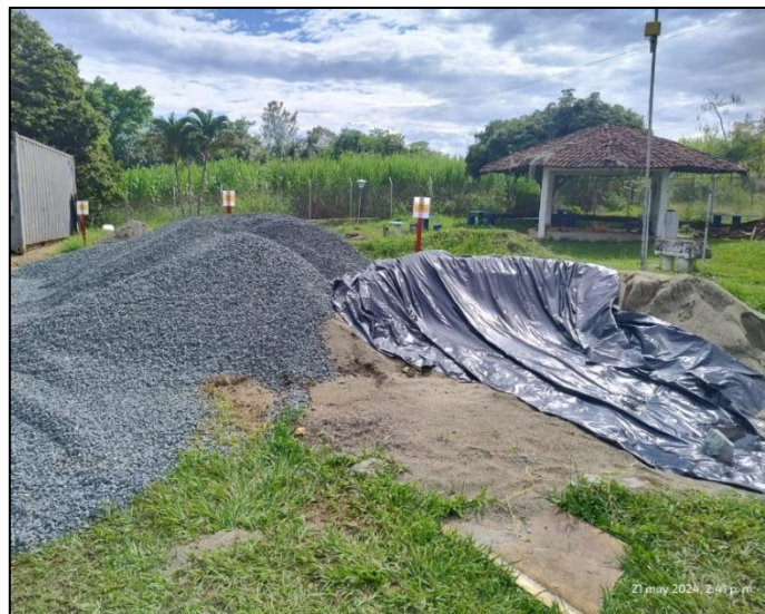
Ilustración 19 Acopio de Material Pétreo
