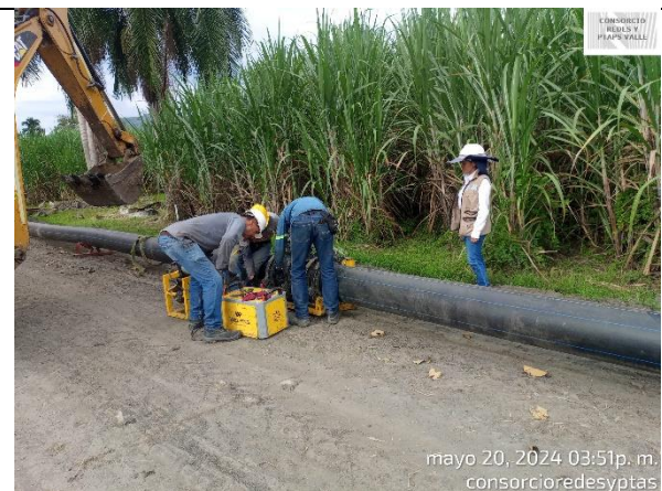
Fotografía 54. Supervisión a los tiempos y proceso de la pega de la tubería de 14" PEAD la cual será instalada en el tramo 3.
