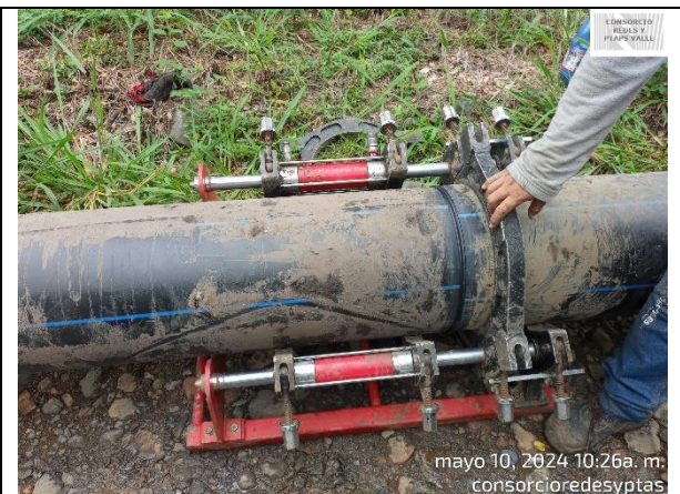
Fotografía 20. Supervisión a los tiempos y proceso de la pega de la tubería de 14" PEAD la cual será instalada en el tramo 3.
