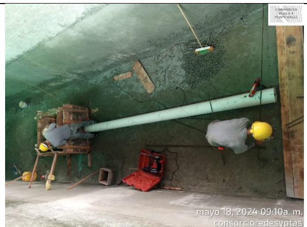
Fotografía 36. Instalación de tubería de 8" Presión en losa inferior del sedimentador No.3 .
