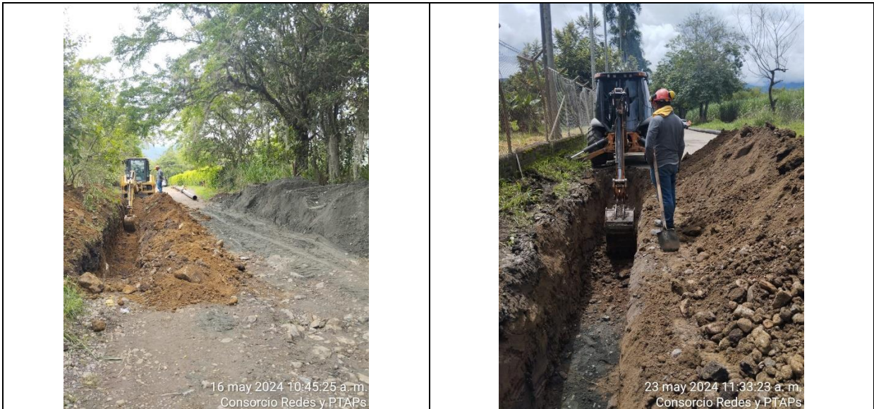
Fotografía 65. Excavación a maquina
