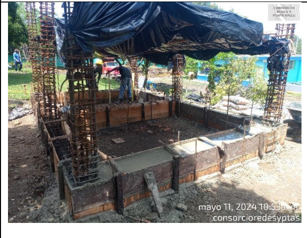
Fotografía 22. Se funden las vigas de cimentación de la caseta eléctrica de la PTAP Ginebra.
