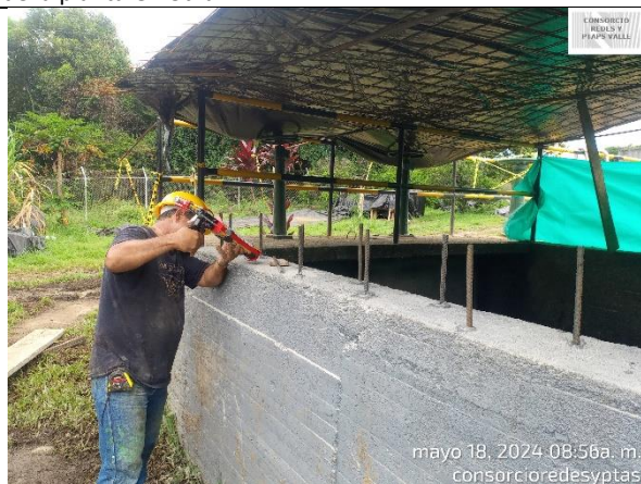
Fotografía 35. Aplicación de Sika Anchorfix para anclajes de realce de muro del sedimentador No.3.
