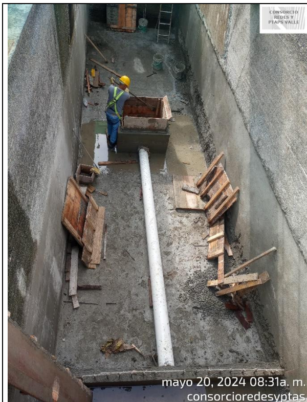
Fotografía 45. Se desencofra caja perdida de la losa de fondo del sedimentador No. 3.
