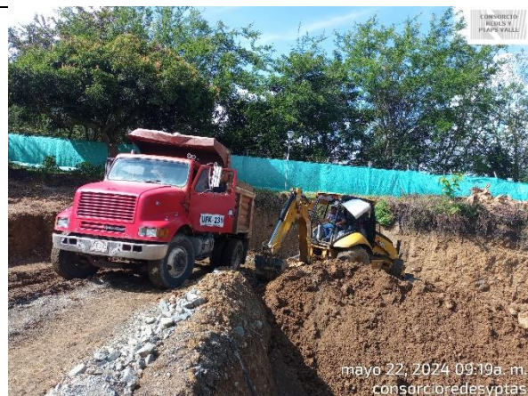
Fotografía 53. Retiro de Material Sobrante de excavación para la construcción del tanque de almacenamiento de agua de la planta Ginebra.
