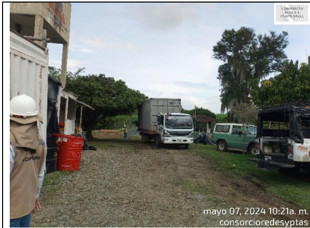
Fotografía 13. Llegada de Contenedor para trabajos de metalmecánica (Coningieniería).
