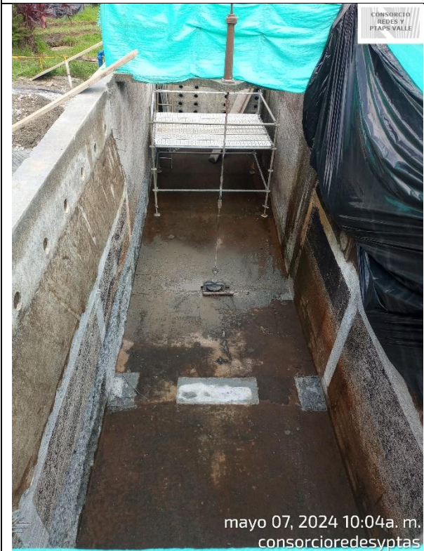
Fotografía 11. Inician con la escarificación del sedimentador No.3, antes se realiza hidrolavado a toda la estructura.
