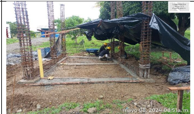
Fotografía 18. Instalación de acero de refuerzo en columnas de la caseta eléctrica de la planta de Ginebra.
