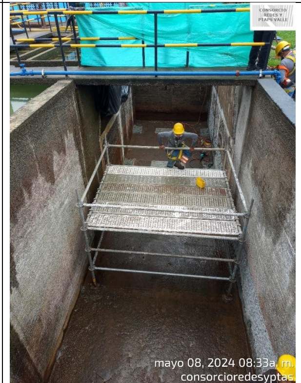
Fotografía 12. Se arma andamio certificado para cumplimiento de las normas de seguridad.
