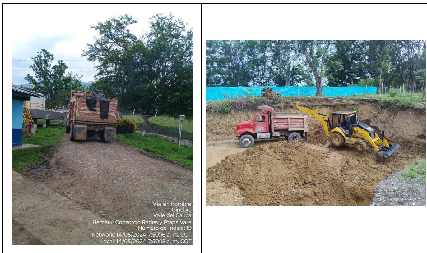
Ilustración 16 Manejo de Material de Excavación
