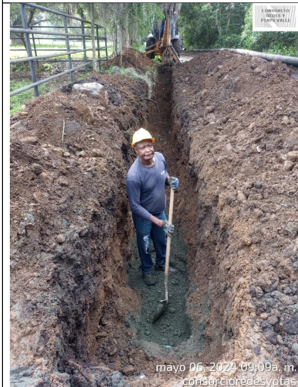
Fotografía 7. Continúan con la excavación en material Conglomerado para instalación de tubería de 14" PEAD en el tramo 3.
