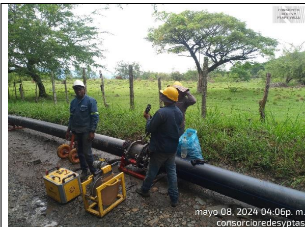
Fotografía 19. Supervisión a los tiempos y proceso de la pega de la tubería de 14" PEAD la cual será instalada en el tramo 3.
