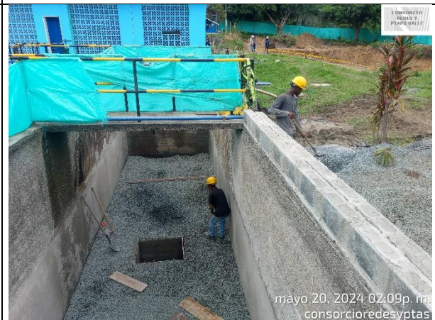
Fotografía 44. Lleno con material granular para realce de losa inferior del sedimentador No.3.
