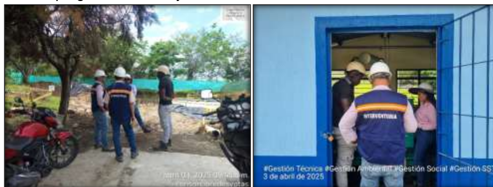
Ilustración 16. Comité de obra del componente eléctrico realizado el 3 de abril del 2025.j
