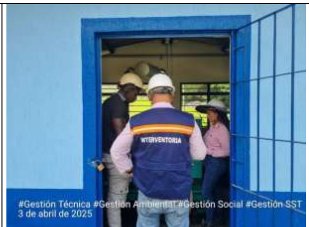
Fotografía 66. Comité y recorrido de componente eléctrico para evaluar los avances de obra y los compromisos
