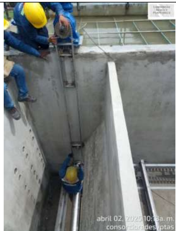
Fotografía 32. Instalación de cadena para Barrelos del sedimentador No.1.
