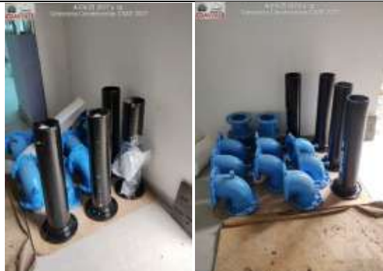
Fotografía 15. Suministro de pasamuros, Niples y Codos para respiraderos del tanque.
