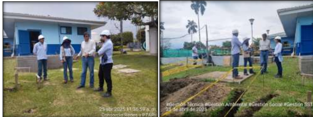
Ilustración 23. Recorrido con el funcionario de Acuavalle para definir y evaluar avances de obra en la PTAP Guacarí.
