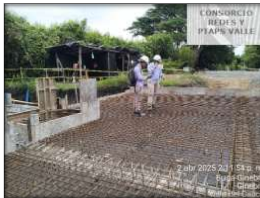
Ilustración 28. Reunión y recorrido con comisión de topografía, interventoría y equipo técnico del contratista en el tanque de la Albania.
