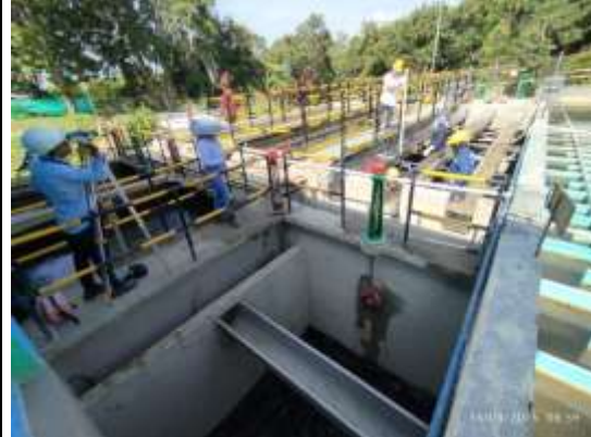
Fotografía 40. Revisión de materiales del falso fondo y presentación para instalación en el filtro No.1.
