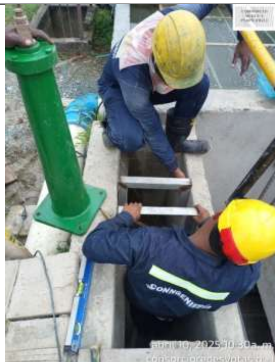
Fotografía 46. Instalación de válvulas de 8" para control de entrada de agua al sedimentador No. 1.
