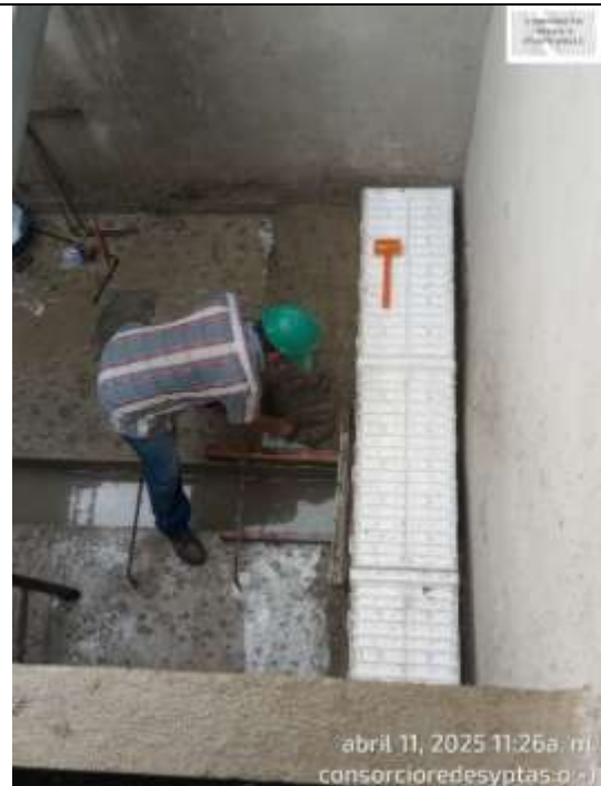
Fotografía 44. Instalación de falsos fondos en Filtro No. 1 PTAP Ginebra
