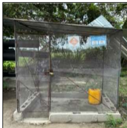
Foto 8. Almacenamiento de Combustible – PTAP Guacarí
