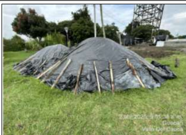
Foto 6. Cubrimiento de Materiales – PTAP Guacarí
