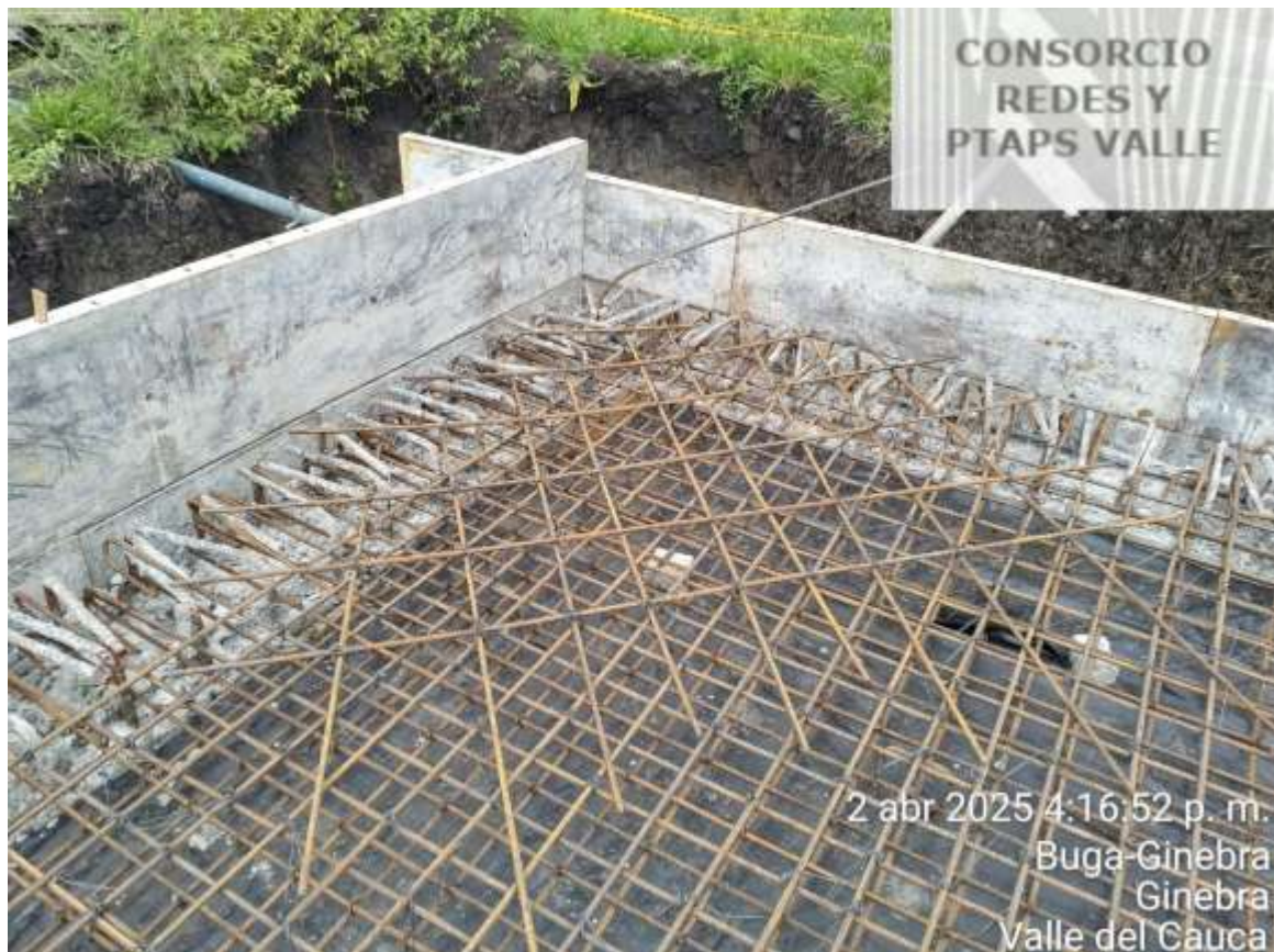
Ilustración 14. Instalación de acero de refuerzo en los vértices del tanque para minimizar las fisuras en la losa superior del tanque de la Albania generadas por la retracción por temperatura (Recomendación del Diseñador).
