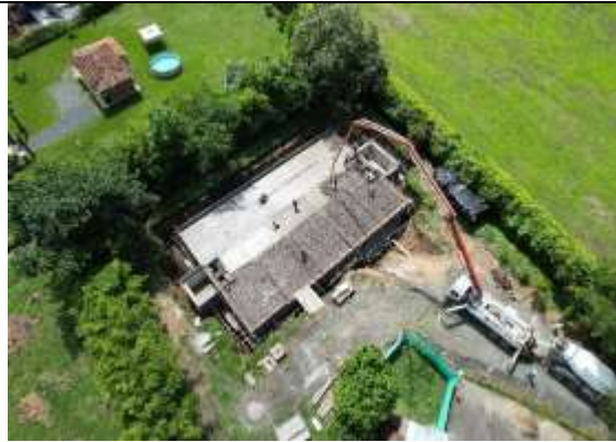
Fotografía 13. Fundición de la losa superior del tanque.
