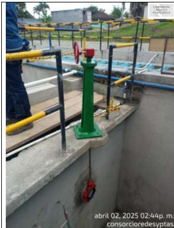
Fotografía 31. Instalación de válvula de 8" para evacuación de agua de lavado del filtro No. 1 PTAP Ginebra
