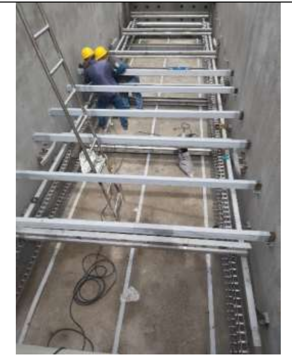
Fotografía 34. Instalación de soportes de los módulos tipo colmena sedimentador No. 1 PTAP Ginebra .
