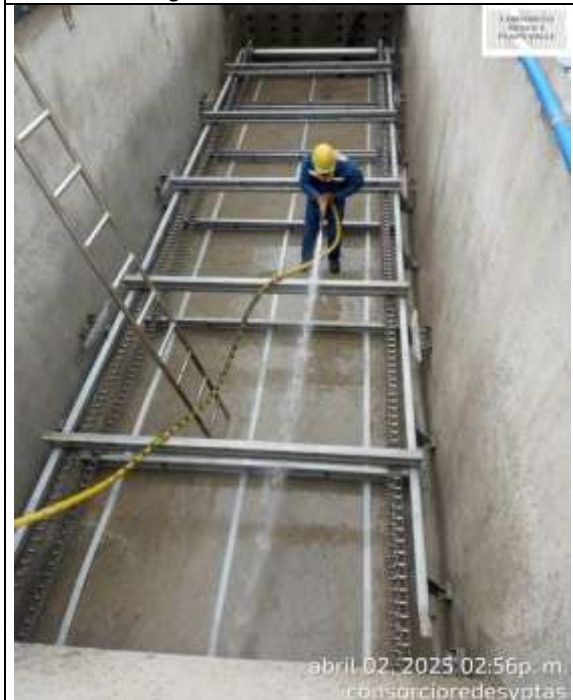
Fotografía 33. Se finaliza con el montaje del Barrelos del Sedimentador No.1 y se realiza jornada de orden y aseo.
