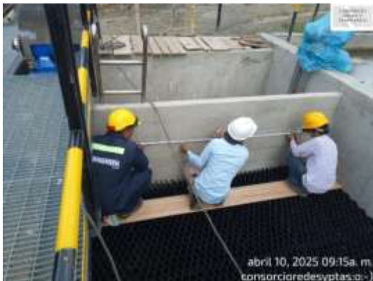
Fotografía 41. Marcación de niveles para instalación de canaletas del sedimentador No. 1 PTAP Ginebra
