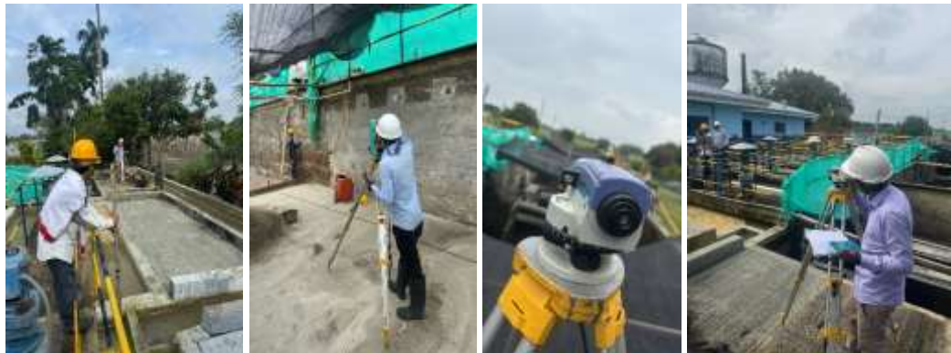
Ilustración 4. Seguimiento a las actividades ejecutadas en el frente de obra de la PTAP Guacarí.
