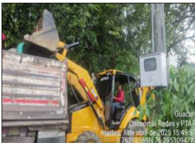
Foto 10. Retiro de Escombros – PTAP Guacarí
