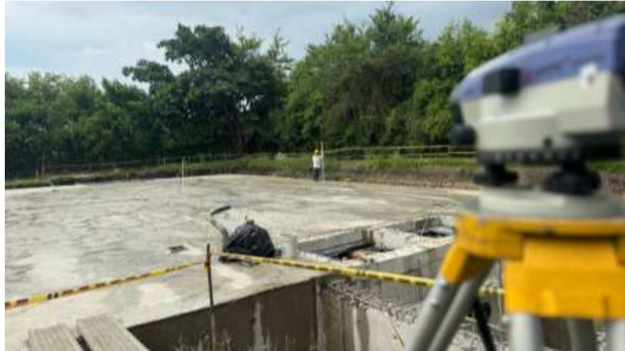
Ilustración 5. Chequeo de niveles de acabado de la losa y toma de cotas para seguimiento de asentamiento del tanque.
