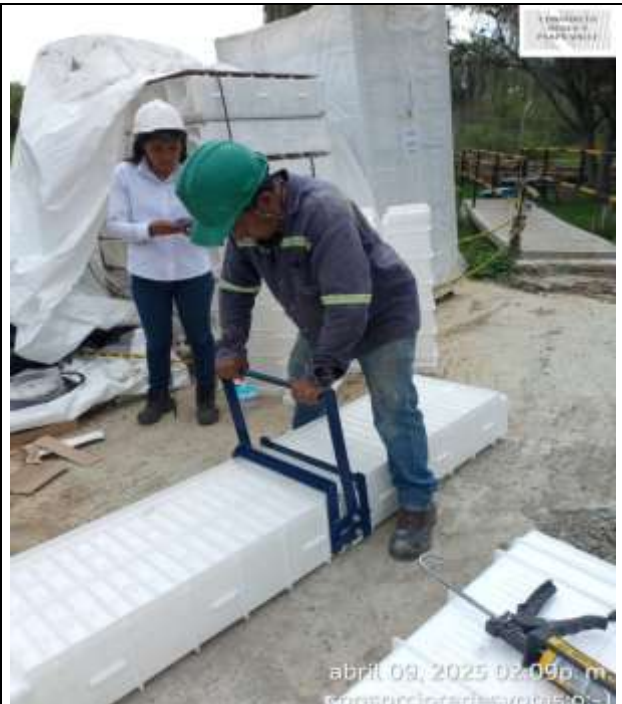
Fotografía 40. Revisión de materiales del falso fondo y presentación para instalación en el filtro No.1.
