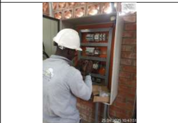
Fotografía 76. Acompañamiento en cambio de arrancador suave en la PTAP Ginebra – Valle del Cauca.
