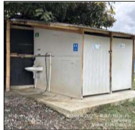
Foto 14. Baños de Obra – PTAP Ginebra
