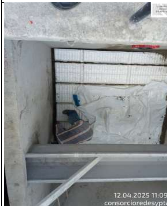
Fotografía 45. Finalizan con la instalación de falsos fondos en Filtro No. 1 PTAP Ginebra
