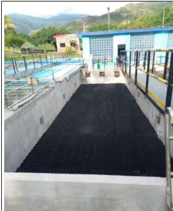
Fotografía 39. Finaliza la Instalación de módulos tipo colmena sedimentador No. 1 PTAP Ginebra
