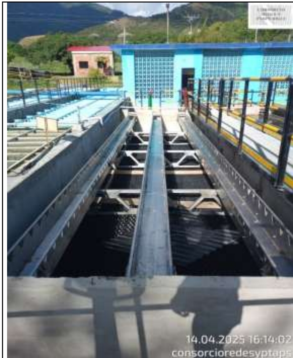
Fotografía 43. Instalación de canaletas del sedimentador No. 1 PTAP Ginebra
