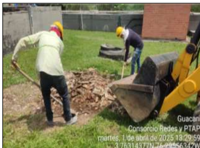
Foto 9. Retiro de Escombros – PTAP Guacarí
