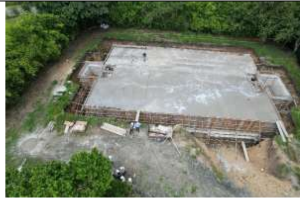
Fotografía 14. Finaliza la actividad de fundición de la losa superior del tanque, se aplica Antisol y se inicia con el proceso de inundación.
