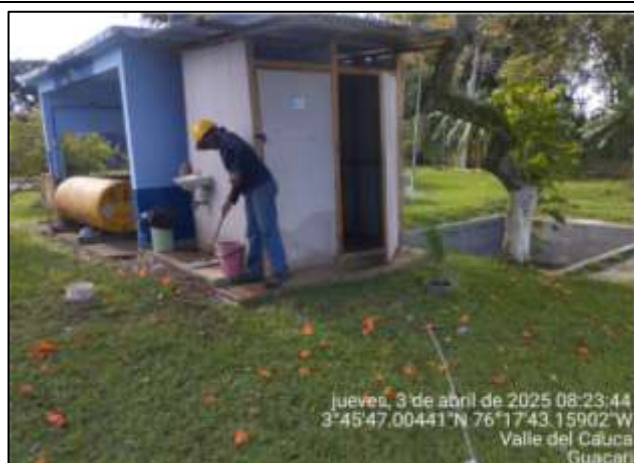
Foto 5. Limpieza Baños de Obra – PTAP Guacarí
