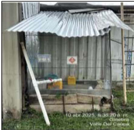
Foto 13. Almacenamiento de Combustible – PTAP Ginebra
