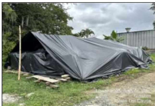
Foto 12. Almacenamiento de Materiales – PTAP Ginebra
