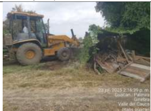
Fotografía 59. continúan con el retiro de material sobrante de excavación de caseta de sopladores y demoliciones en intervenciones la planta.
