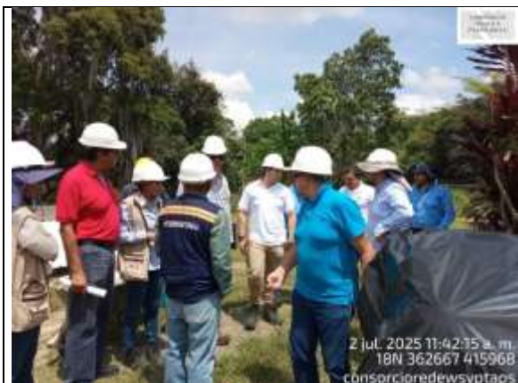
Fotografía 61. Se revisan los materiales y la logística para instalación del material en el filtro No.1.
