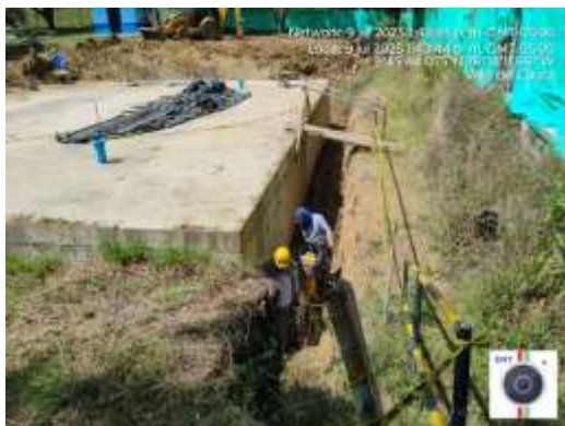
Ilustración 4 Acompañamiento y control de niveles de los llenos para poder llegar a la cota para instalación de tubería de alimentación del tanque.
