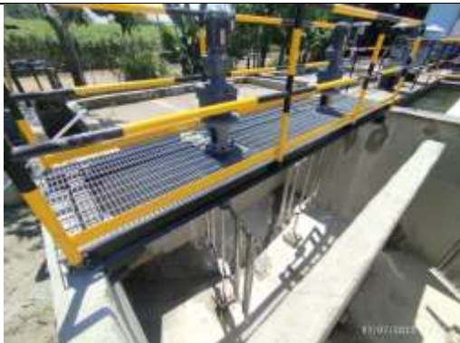
Fotografía 55. Instalación de moto-reductores en el floculador N°3 de la PTAP de Guacarí
