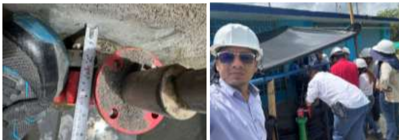
Ilustración 3 Chequeo de cotas y medidas para material de soporte en el Filtro No.1 de la PTAP Ginebra y acompañamiento en la puesta en operación del filtro No.1.
