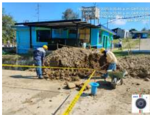
Ilustración 4 Acompañamiento y control de niveles de los llenos para poder llegar a la cota para instalación de tubería de alimentación del tanque.
