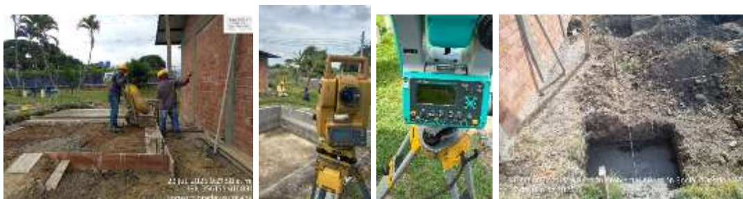
Ilustración 5. Acompañamiento de actividades en la construcción de la caseta de sopladores.
