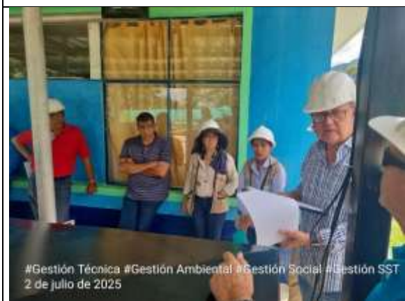
Fotografía 63. Se revisa el proceso de las pruebas para puesta en funcionamiento del filtro No.1.
