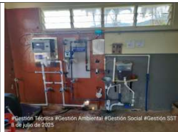
Fotografía 25. Se realiza la instalación de todo el Streaming Current.
