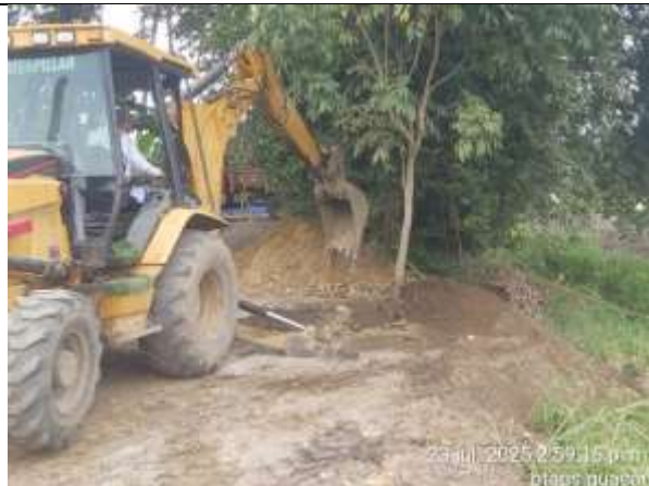
Fotografía 56. Retiro de material sobrante de excavación de caseta de sopladores y demoliciones en intervenciones la planta.
