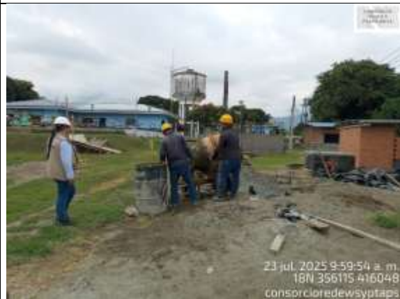
Fotografía 57. Supervisión a la actividad de mezclado del concreto para garantizar que la mezcla quede homogénea y con la dosificación solicitada.
