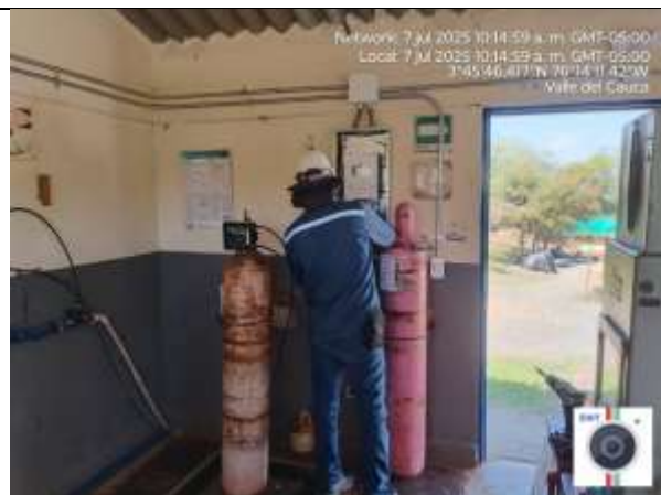
Fotografía 26. Conexiones del componente eléctrico del equipo del Streaming Current.
