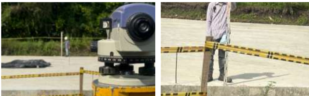
Ilustración 6 Chequeo de cotas para seguimiento de asentamiento del tanque
