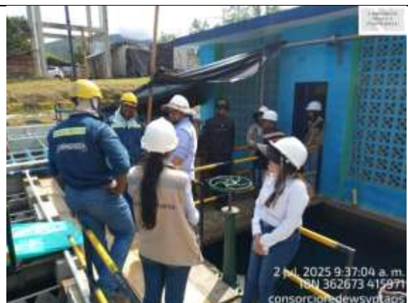
Fotografía 62. Se evalúa como se realizarán las pruebas Agua- Aire en el Filtro No.1.
