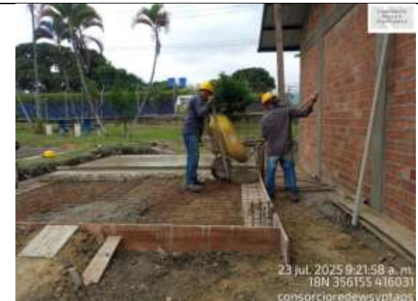
Fotografía 58. Fundición de la losa de la caseta de sopladores.
