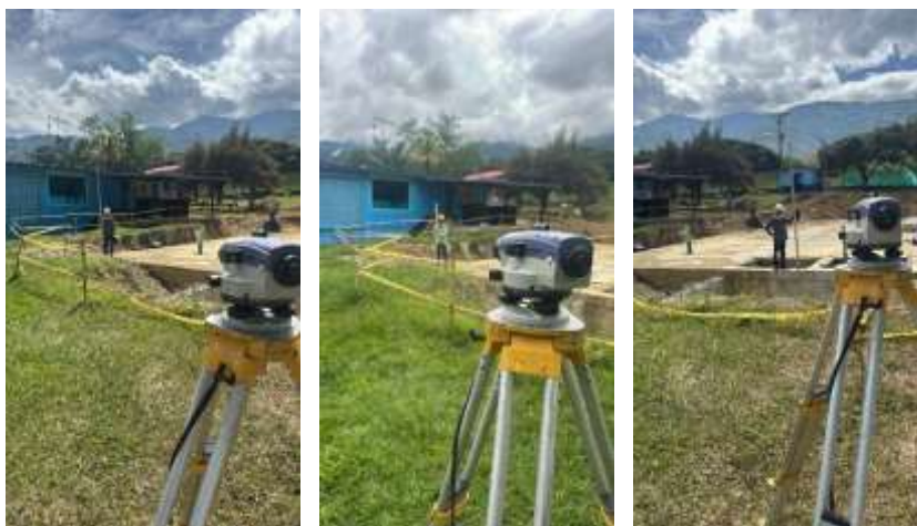
Ilustración 8 Chequeo de cotas para seguimiento de asentamiento del tanque de la Albania.
