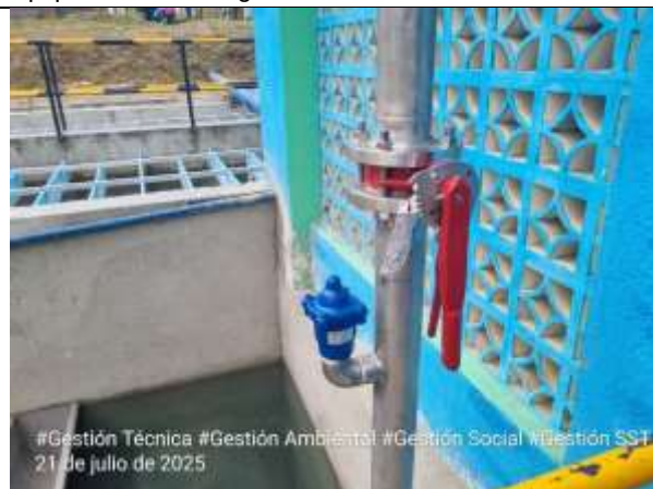
Fotografía 28. Instalación de Válvula mariposa y válvula ventosa para puesta en funcionamiento del Filtro No.1.
