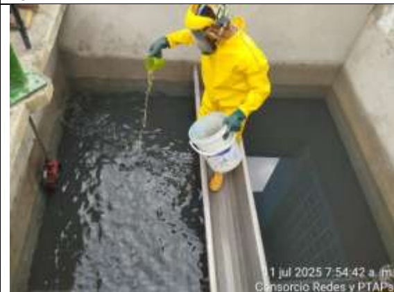
Fotografía 29. Aplicación de hipoclorito de sodio para desinfección del filtro N°1 PTAP Ginebra.
