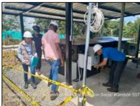
Ilustración 22 Acompañamiento y supervisión de la conexión provisional eléctrica de los equipos de sopladores.
