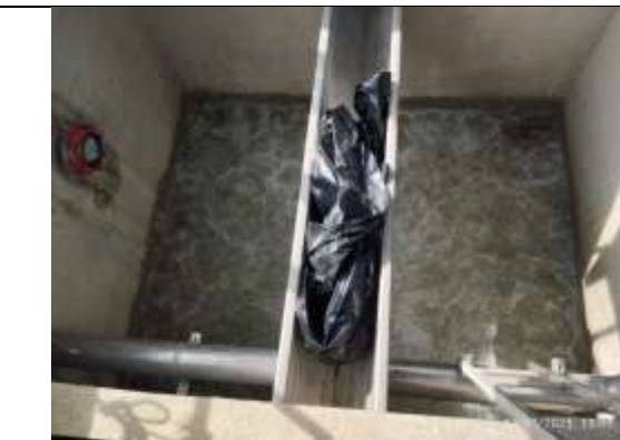
Fotografía 30. Prueba de aire en los falsos fondos.
