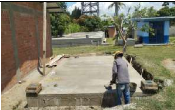
Fotografía 60. Finalizan con la construcción de la losa y pedestales de la caseta de sopladores.
