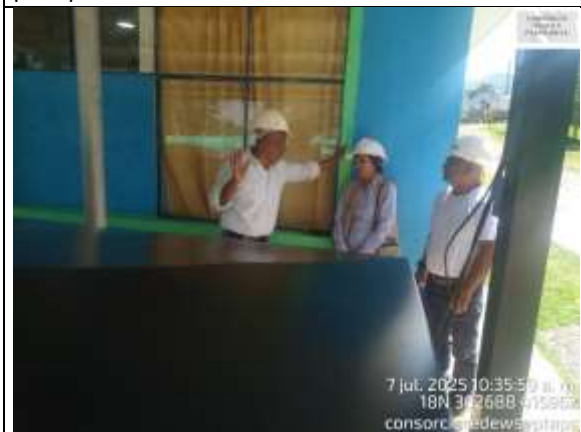
Fotografía 65. Se realiza visita de campo con la interventoría y supervisión en los frentes de obra.
