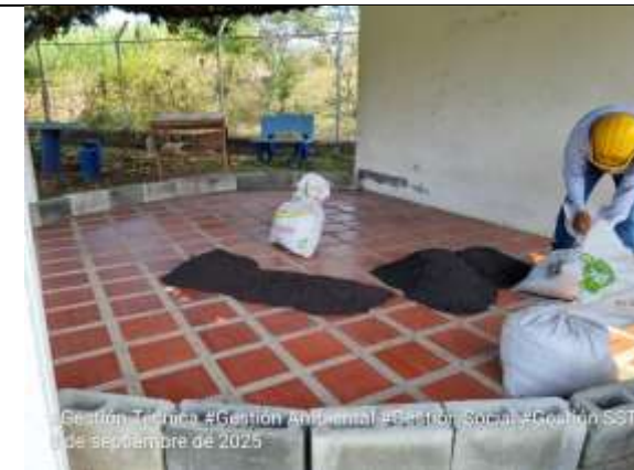
Fotografía 40. El material Filtralite retirado de filtro No.1 se extiende en una superficie sin sol directo y se inicia el proceso de secado.
