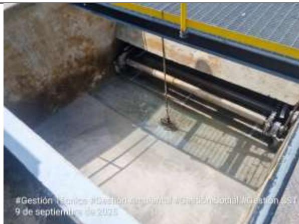
Fotografía 50. Construcción de hombros para pendiente en canaleta de acumulación de lodos del sedimentador no.1.
