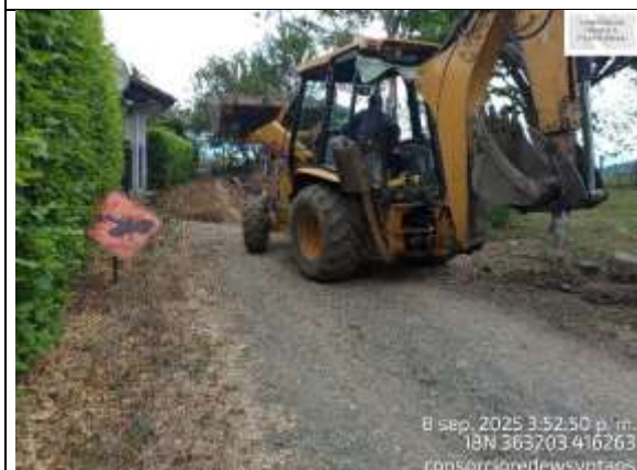
Fotografía 63. Transporte de material sobrante a puntode acopio para realizar la disposición final.
