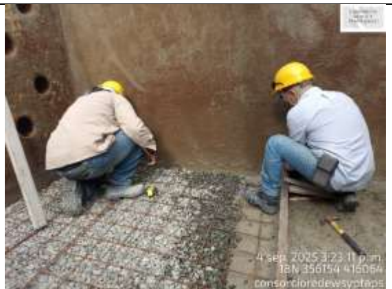
Fotografía 41. Instalación de material granular de relleno para construcción de realce para pendiente de la canal de acopio de lodos.
