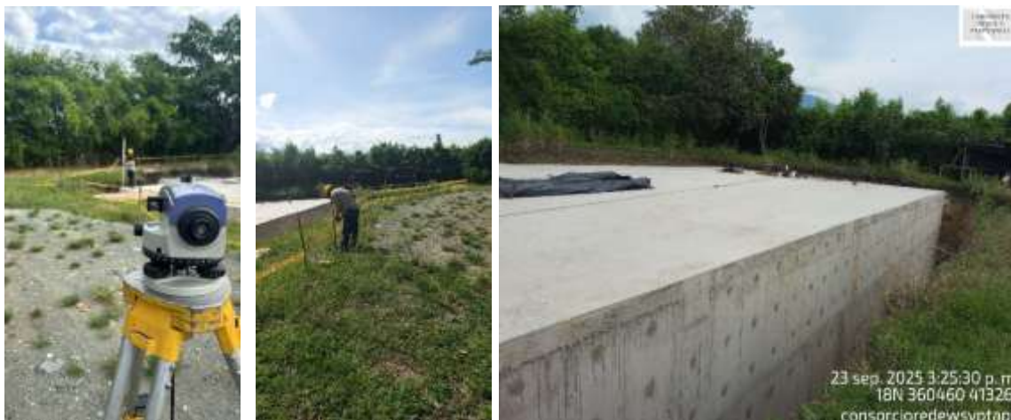
Ilustración 10 Chequeo de cotas para seguimiento de asentamiento del tanque de la Albania.
