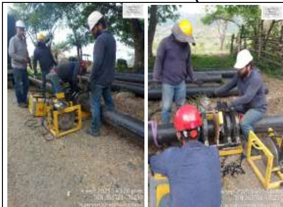
Fotografía 61. Realizan las pegas de termofusión en la tubería de 10" PEAD.
