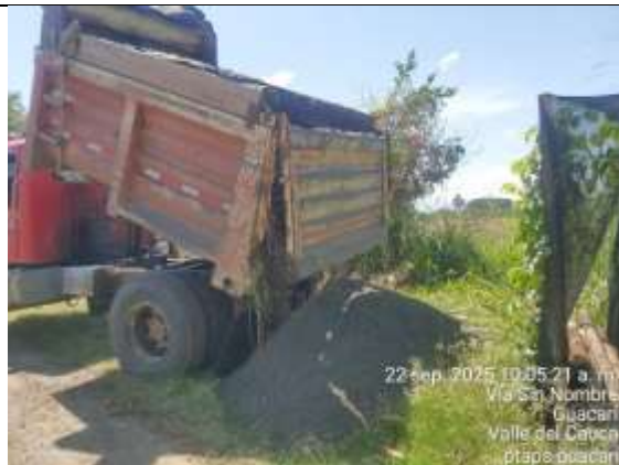
Fotografía 53. Suministro de materiales pétreos para optimización de las estructuras de la PTAP (Arena de repello).
