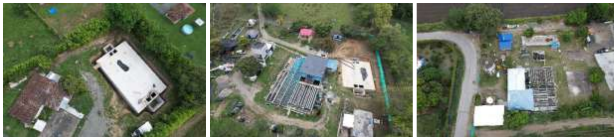
Ilustración 7. Toma de fotos aéreas en todos los frentes de obra que se realizan actividades de obra.
