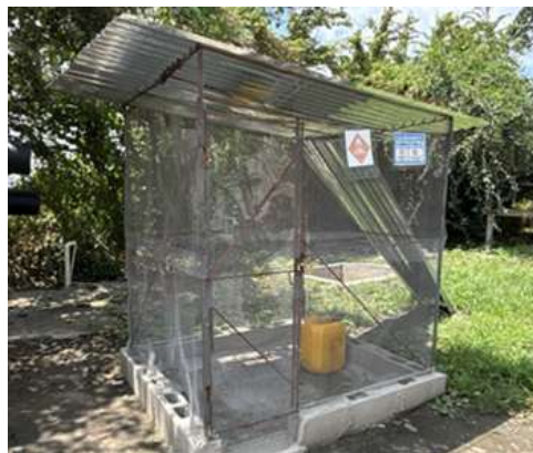
Foto 6. Almacenamiento de combustible – PTAP Guacarí
