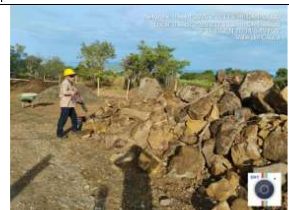
Fotografía 66. Se ha realizado demolición de la roca que ha salido de la excavación para poder instalar la tubería y transportar el material sobrante.
