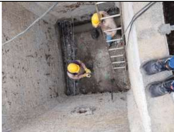
Fotografía 52. Continúan con la demolición de las estructuras internas de los tanques de filtros de la batería B – Demolición de falsos fondos.
