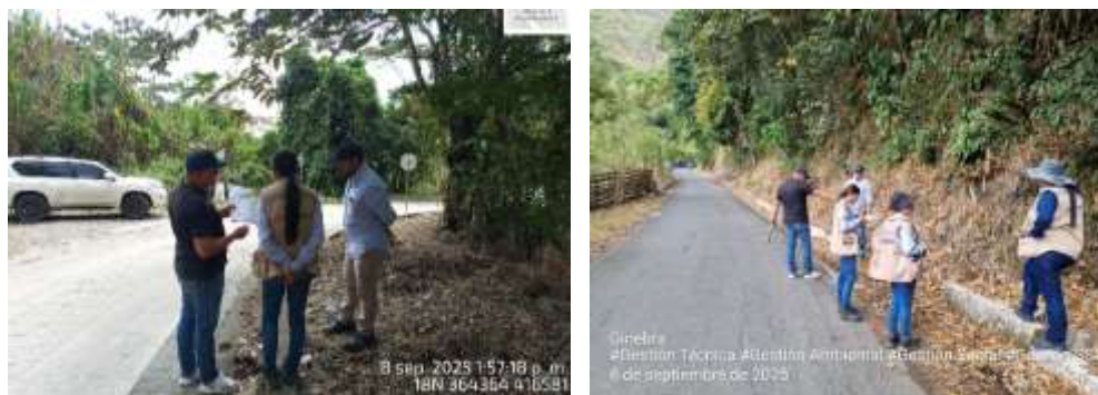
Ilustración 13 Recorrido para evaluar actividades en la instalación de tubería del tramo No.1.
