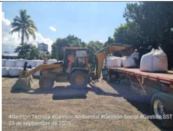
Fotografía 54. Se trasladan los Big-Bag para tamizaje de eliminación de finos (Filtralite)
