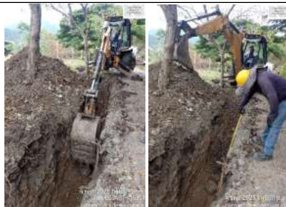
Fotografía 62. Excavación para instalación de tubería en el tramo 2 – Tubería de 10”.
