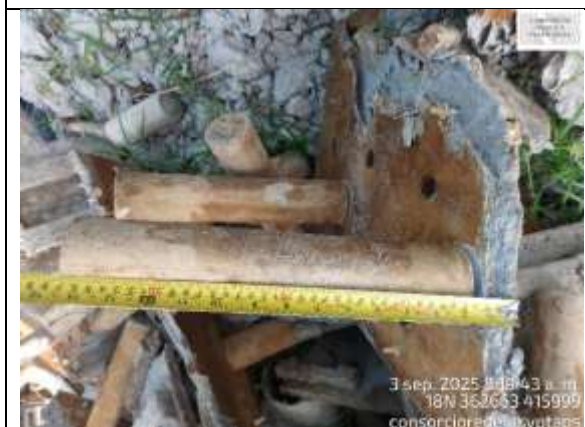
Fotografía 23. Se retira el escombro de los falsos fondos y se toman medidas para definir el espesor del realce de la losa de fondo del filtro No.2.
