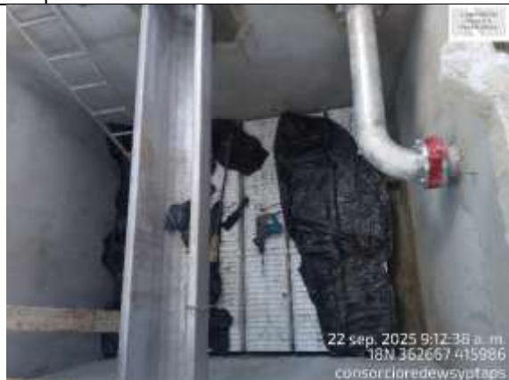
Fotografía 39. Finalizan con la instalación de los falsos fondos e inician con las actividades de instalación del múltiple.
