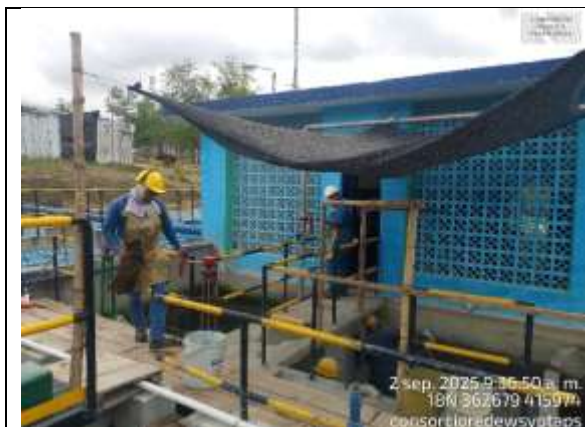
Fotografía 19. Realiza la instalación del desfogue en la línea principal de alimentación de aire.
