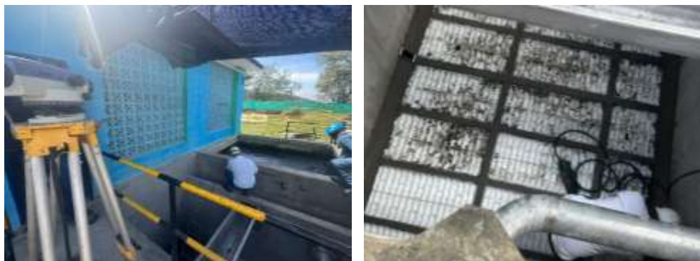
Ilustración 3 Chequeo de cotas y medidas para instalación de canaleta y tubería de alimentación del filtro No.2.
