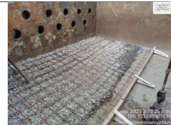
Fotografía 42. Instalación de malla electrosoldada para construcción de realce para pendiente de la canal de acopio de lodos.
