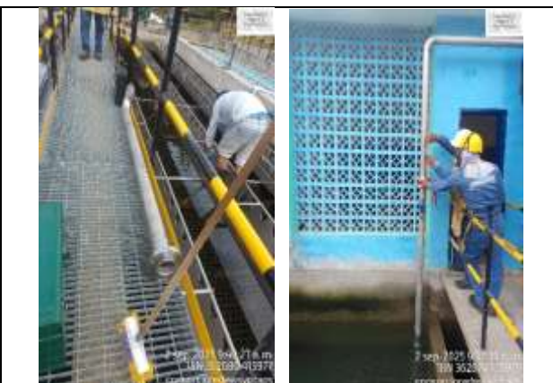
Fotografía 20. Se instala el desfogue donde lo solicito el proveedor y cumpliendo todas las recomendaciones.
