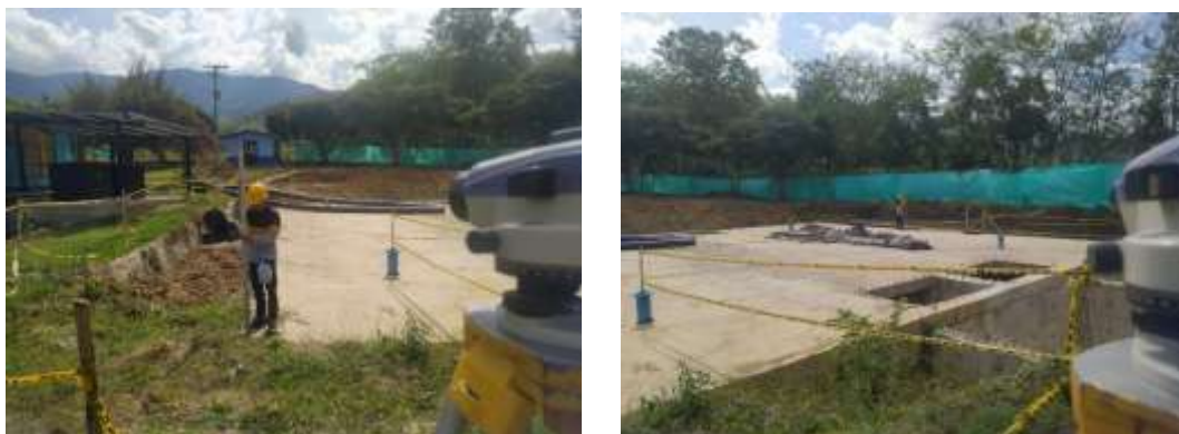
Ilustración 4 Seguimiento y control de niveles para evaluar asentamientos en todos los vértices del tanque.
