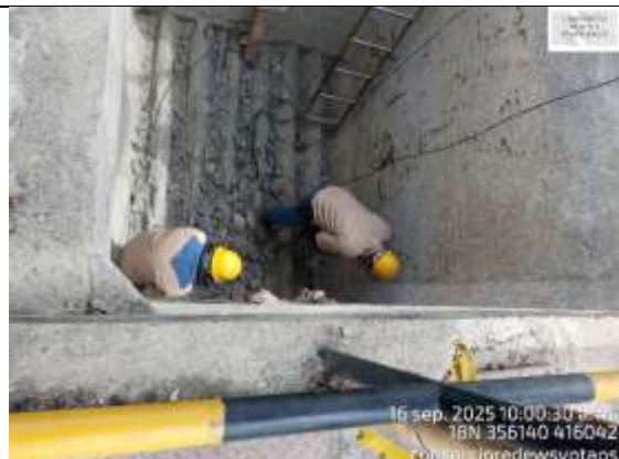
Fotografía 49. Escarificación de muros internos de los tanques de la batería B de los filtros de la planta.
