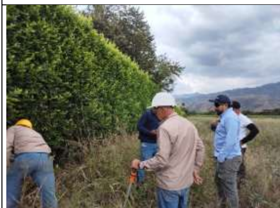
Fotografía 100. Recorrido con funcionario de Asoguabas para permitir la conexión para alimentación de agua cruda al tanque Albania.
