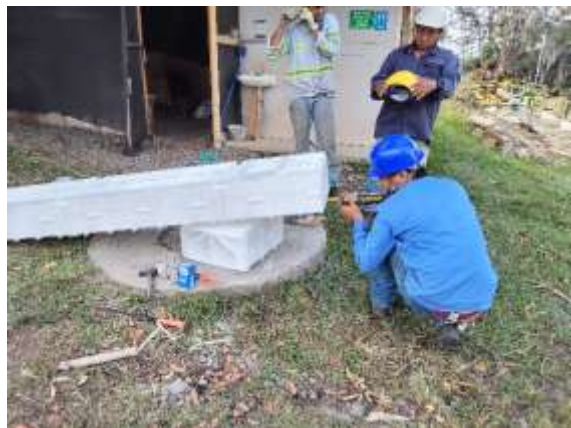
Fotografía 37. Se supervisa la labor de ensamble de los falsos fondos que serán instalados en el tanque del filtro No.2.
