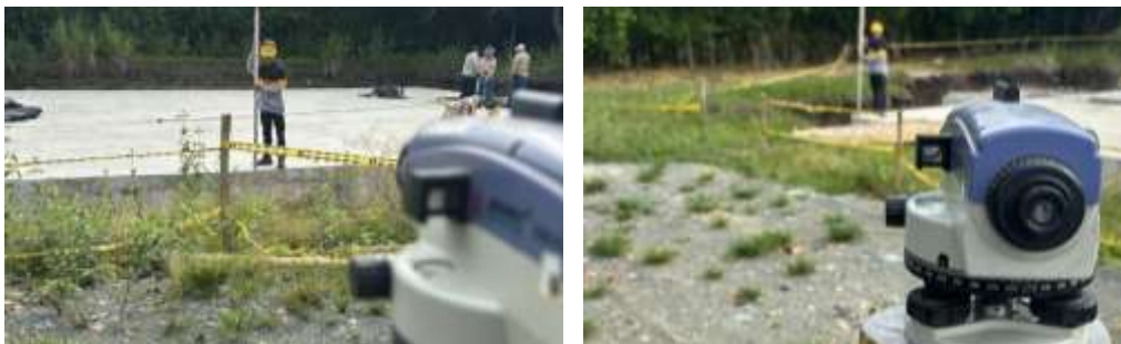
Ilustración 6 Chequeo de cotas para seguimiento de asentamiento del tanque
