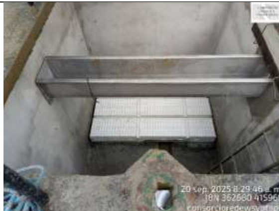
Fotografía 38. Inician con la instalación de los falsos fondos del tanque del filtro No.2.
