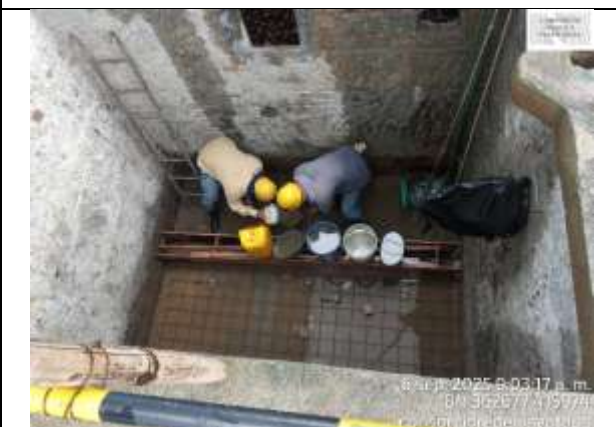
Fotografía 24. Se realiza la fundición de la losa de fondo del filtro No.2 – Instalación de formaleta del canal y malla electrosoldada.
