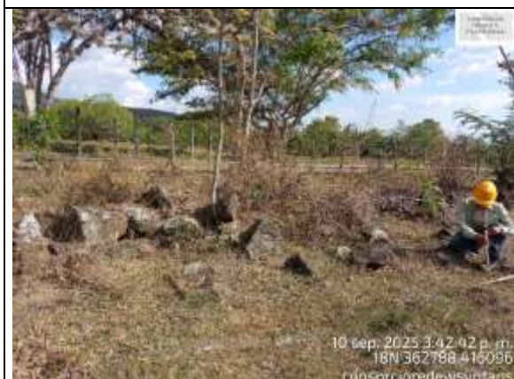
Fotografía 65. La topografía acompaña la actividad para garantizar que la tubería sea instalada sobre el alineamiento y profundidad de diseño.
