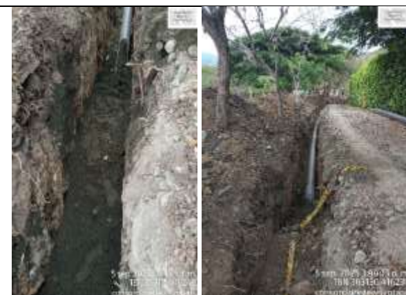
Fotografía 64. Realizan el relleno con material granular para protección de la tubería y luego se instala la cinta preventiva.
