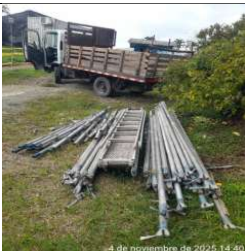
Fotografía 11. Suministros de andamios para actividades impermeabilización del tanque.
