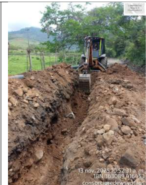
Fotografía 57. Excavación en material conglomerado en Sector la Magdalena.
