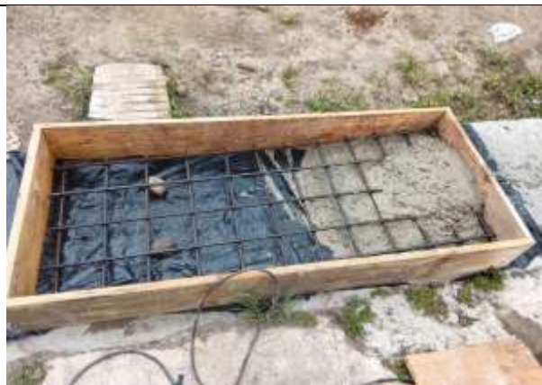
Fotografía 82. Construcción de tapa para caja ciega en pase de la Yee del ingenio Pichichi.
