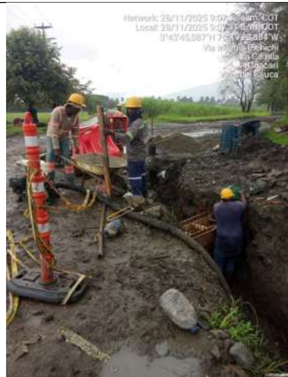
Fotografía 76. Construcción del pase en la Yee del callejo del ingenio Pichichi.
