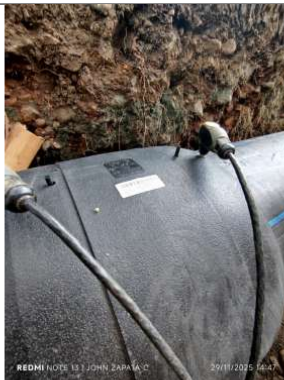
Fotografía 71. Se chequea el correcto proceso de la pega de electro en el pase la uvalina.
