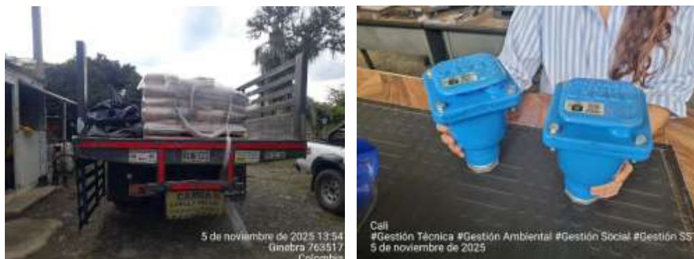
Ilustración 6. Ingreso de materiales a la PTAP Ginebra – Cemento y válvulas ventosas para optimización de plantas.
