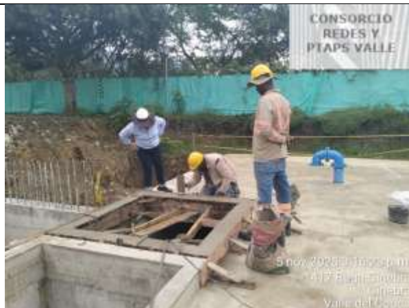
Fotografía 8. Finalizan con la construcción de los bordillos de acceso al tanque.
