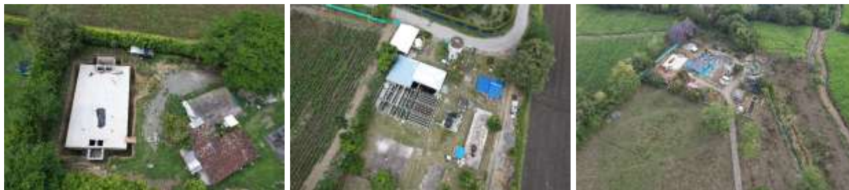
Ilustración 5. Toma de fotos aéreas en todos los frentes de obra que se realizan actividades de obra.
