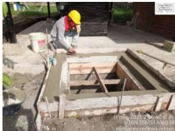
Fotografía 37. Fundición de los marcos de las cajas eléctricas.
