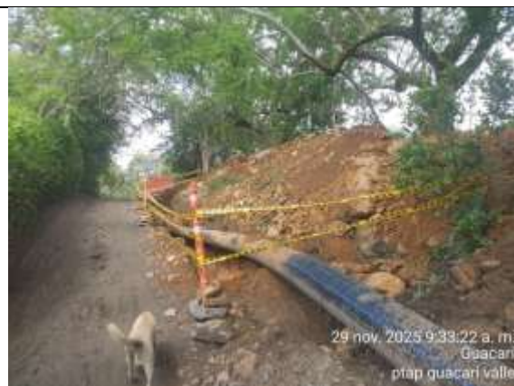
Fotografía 78. Señalización de tramos de tubería que serán instalados durante la jornada.
