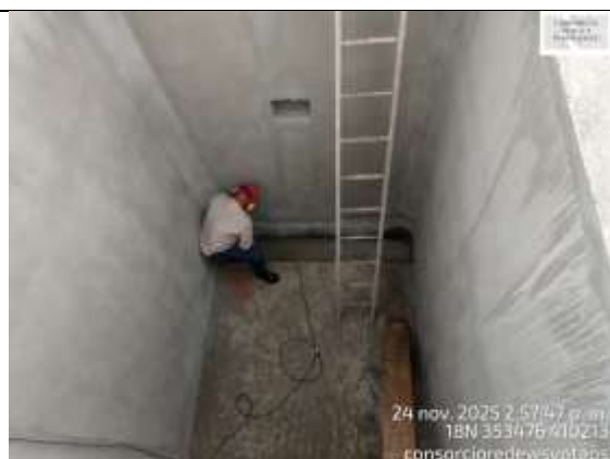
Fotografía 41. Demolición de pestaña para instalación de ángulo de soporte de falsos fondos.
