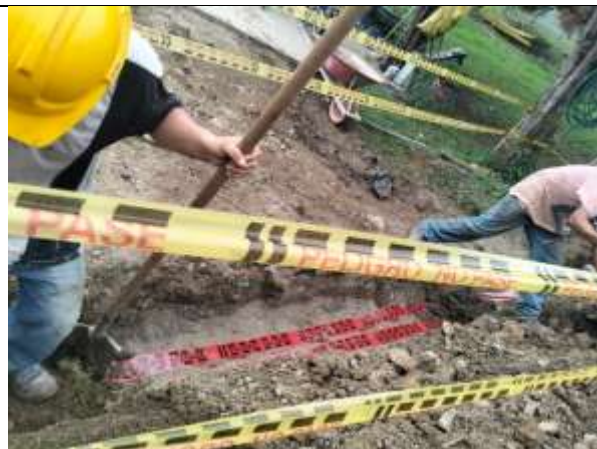
Fotografía 38. Luego de la instalación de los ductos se realiza el relleno e instala cinta preventiva.
