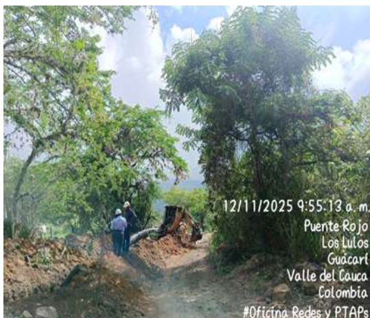
Foto 9. Excavación para instalación de tubería- Sector balneario La Esmeralda
