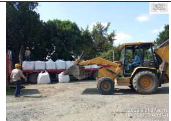
Fotografía 34. Descargue y acopio de materiales ' Filtralite.
