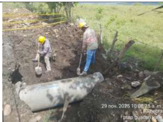
Fotografía 70. Conexión de electro fusión en pases dirigidos – Sector la Uvalina.
