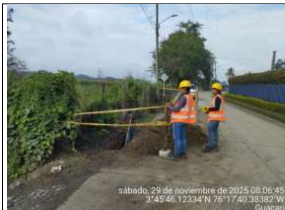
Fotografía 77. Señalización de las excavaciones para instalación de tubería de 14" PEAD.
