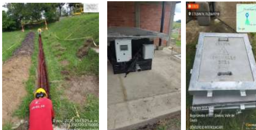
Ilustración 3. Acompañamiento de actividades en la construcción de la caseta de sopladores y caseta eléctrica, alimentación de tubería de aire y instalación de ductos eléctricos.
