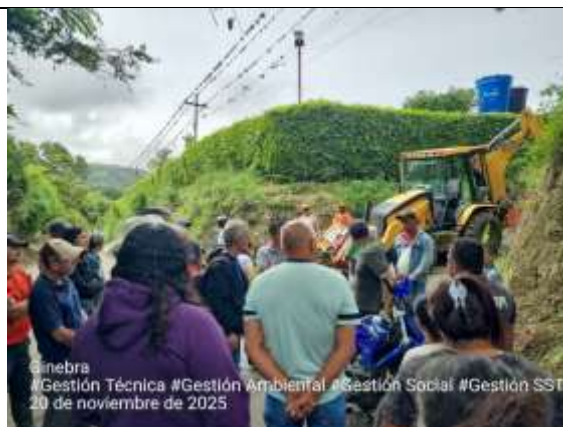
Fotografía 54. La comunidad manifiesta que no dejarán realizar la demolición y reposición del pavimento por falta de acompañamiento de la administración local.
