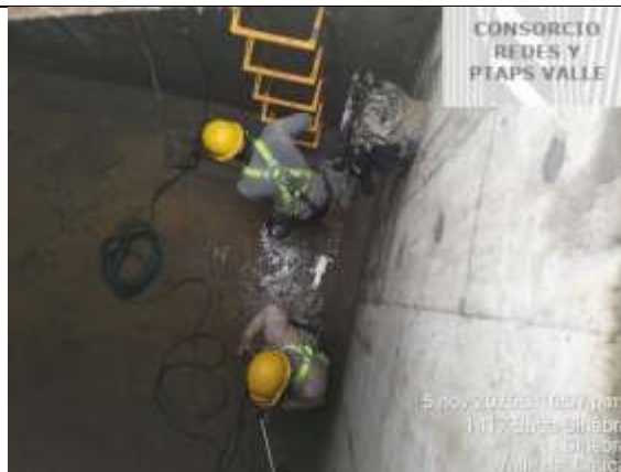
Fotografía 10. Limpieza del tanque para iniciar con la preparación de superficies.
