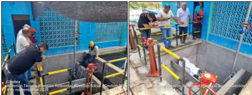
Ilustración 12. Reunión y prueba de funcionamiento de falsos fondos en Filtro No.2 de la PTAP Ginebra.
