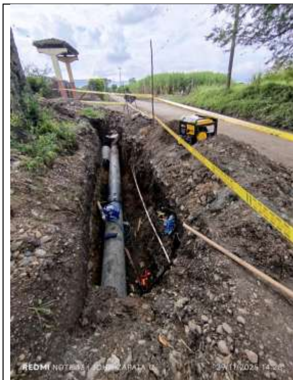
Fotografía 70. Conexión de electro fusión en pases dirigidos – Sector la Uvalina.
