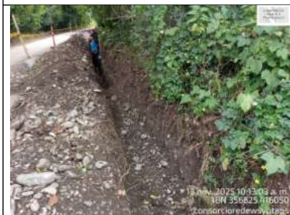
Fotografía 58. Excavación manual en tramo de llegada a la PTAP Guacaré.
