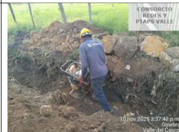
Fotografía 59. Compactación de material de relleno en tramo la Magdalena.
