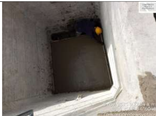
Fotografía 32. Fundición de la losa para realce del piso de la batería de los filtros.
