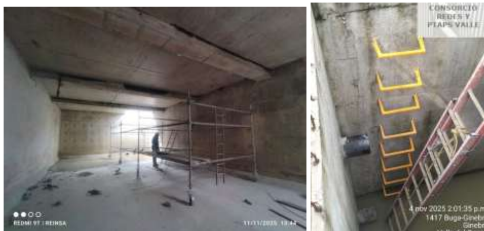
Ilustración 10. Instalación de peldaños en cámaras y compartimientos, e inicio de la preparación de superficies para impermeabilización.
