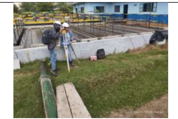
Fotografía 36. Revisión de niveles de los filtros de la batería B de la PTAP de Guacarí
