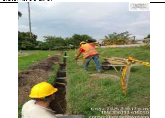
Fotografía 35. Continúan con la excavación para instalación de ductos eléctricos en la PTAP.
