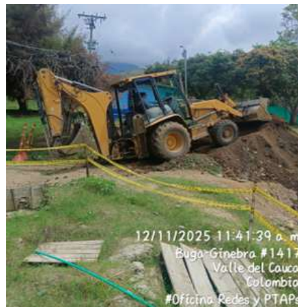
Foto 14. Relleno y nivelación del costado lateral tanque – PTAP Ginebra
