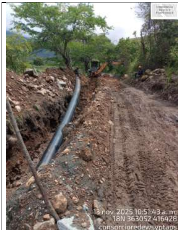
Fotografía 56. Instalación de tubería de 14" PEAD en Sector la Magdalena.
