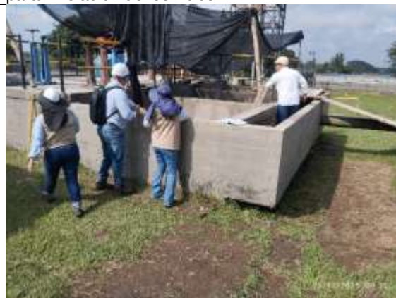
Fotografía 33. Revisión filtros batería B para determinar instalación de flautas y tuberías del sistema de aire.
