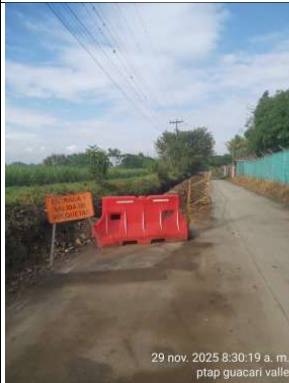
Fotografía 75. Señalización en la excavación manual de la llegada a la PTAP Guacarí.
