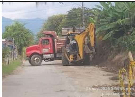
Fotografía 83. Retiro de material sobrante de excavación en tramo de vía pavimentada.
