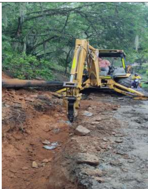
Fotografía 80. Demolición de roca que han aflorado en la excavación y las cuales impiden con la instalación de la tubería.
