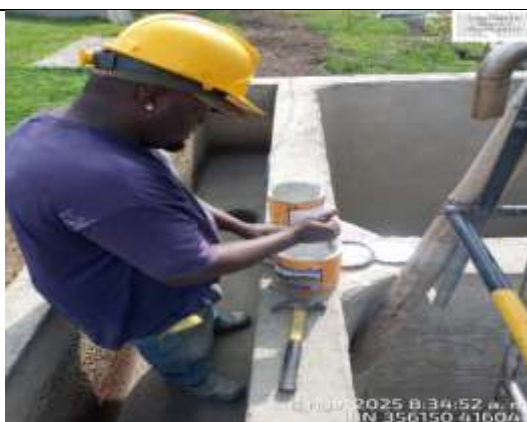
Fotografía 42. Aplicación de Sikadur 32 Primer para poder realizar puente de adherencia.
