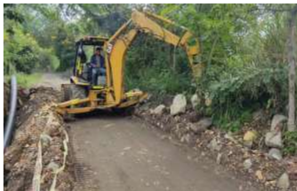
Fotografía 84. Demolición de rocas sobretamaño que has salido de la excavación en llegada al puente la Magdalena.
