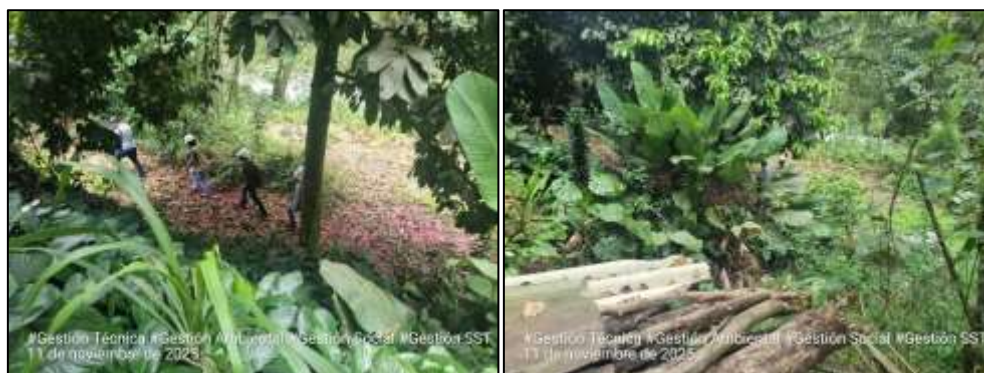
Ilustración 22. Recorrido en el lote de la futura bocatoma para replantear el área de intervención.
