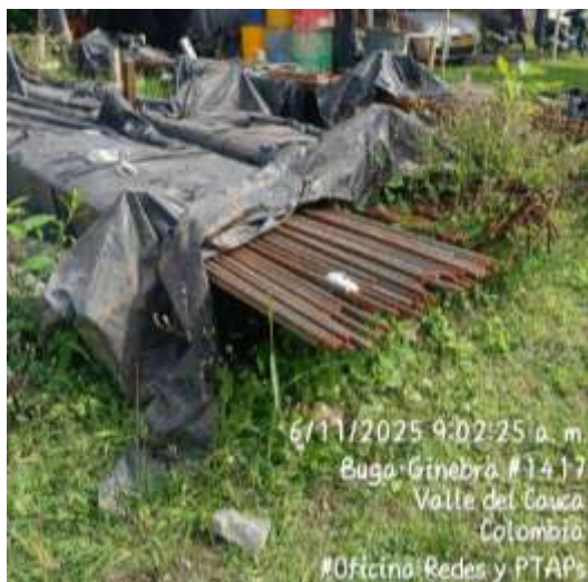
Foto 11. Acopio de acero- PTAP Ginebra
