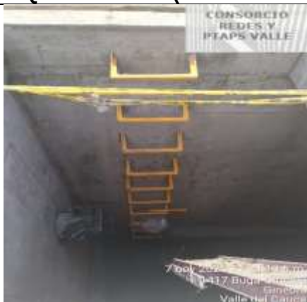
Fotografía 9. Inician con la instalación de peldaños para acceso del tanque.
