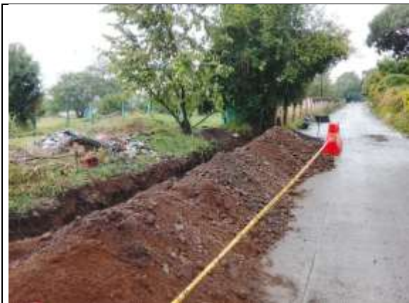
Fotografía 81. Continúan con la excavación manual hacia la llegada de la PTAP Guacarí – Tramo de vía pavimentada.
