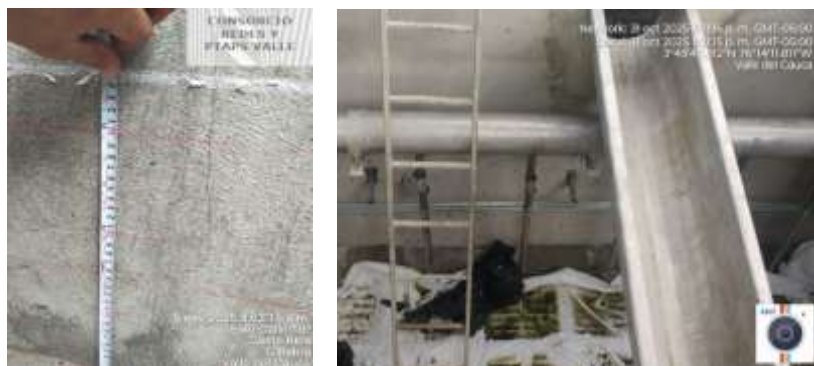
Ilustración 1. Chequeo de cotas y medidas para instalación de canaleta, Multiplex y tubería de alimentación de aire del filtro No.2, suministro de material de soporte y Filtralite.
