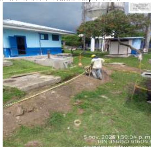
Fotografía 40. Excavación para instalación de ductos eléctricos.
