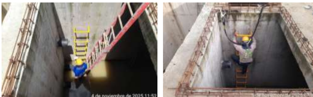
Ilustración 4. Marcación de puntos para perforación e instalación de peldaños.
