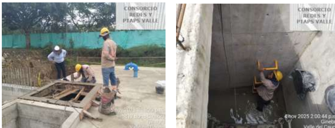
Ilustración 9. Actividad de perforación de muros para instalación de peldaños en el tanque de Ginebra y fundición de bordillo de ventanas de acceso del tanque.
