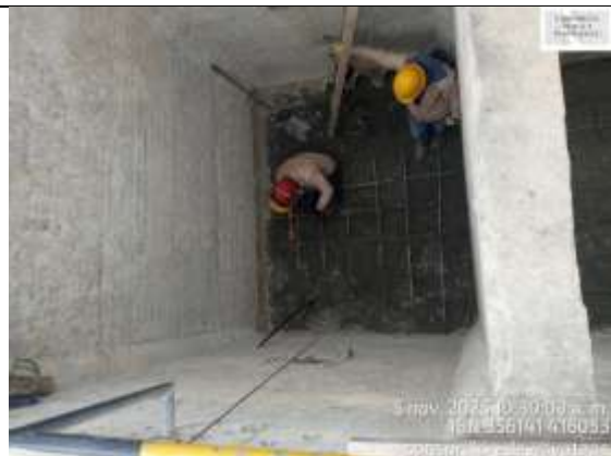
Fotografía 31. Se realiza la demolición de la losa para nivelación de los filtros.
