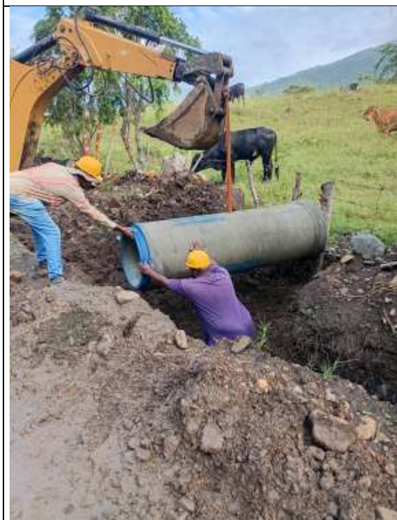
Fotografía 79. Instalación de tubería en concreto en pases de las alcantarillas transversales de la vía.
