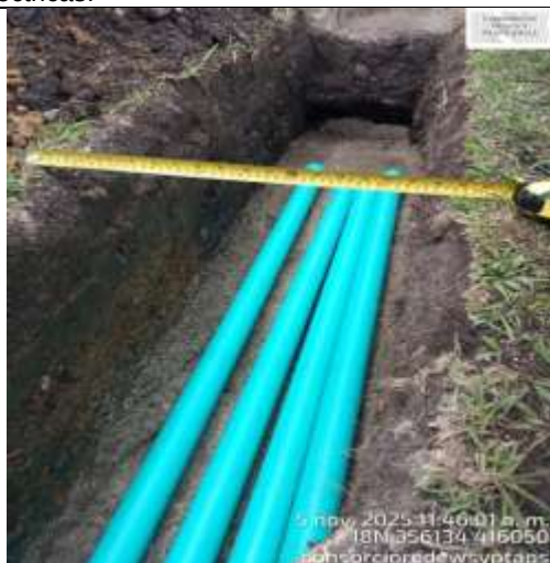
Fotografía 39. Continúan con la instalación de los ductos eléctricos en la Planta.
