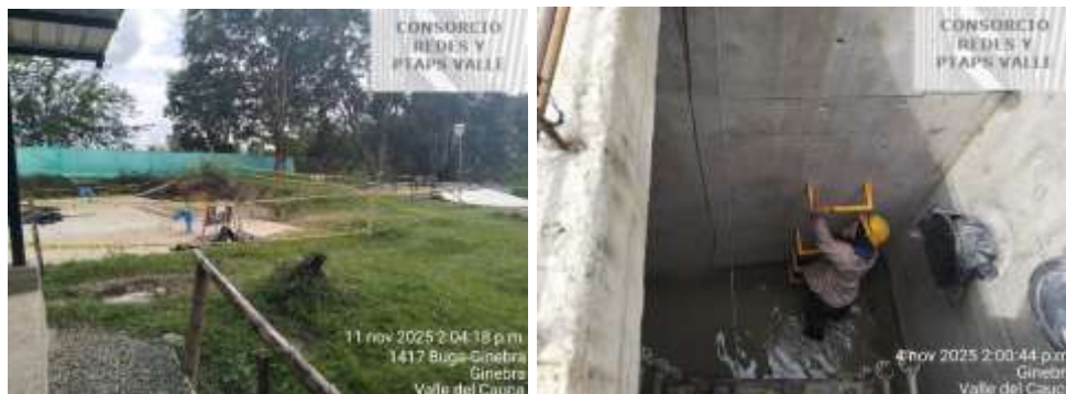
Ilustración 2. Seguimiento y control de niveles para evaluar asentamientos en todos los vértices del tanque y marcación de puntos para perforaciones para peldaños.
