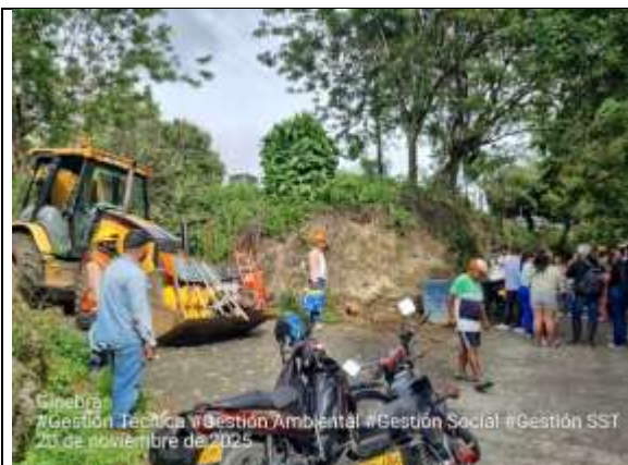
Fotografía 53. Protesta de comunidad para evitar realizar actividades sobre el pavimento rígido.
