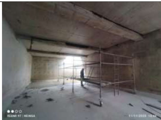
Fotografía 7. Inician preparación de superficies para aplicación pintura interna del tanque.
