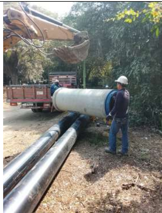
Fotografía 53. Transporte de tubos en PEAP y en concreto para instalarlos en los pases.
