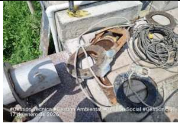
Fotografía 20. Desmonte de válvulas de 6" y 8" del filtro No.3 y demolición para instalación de pasamuros.
