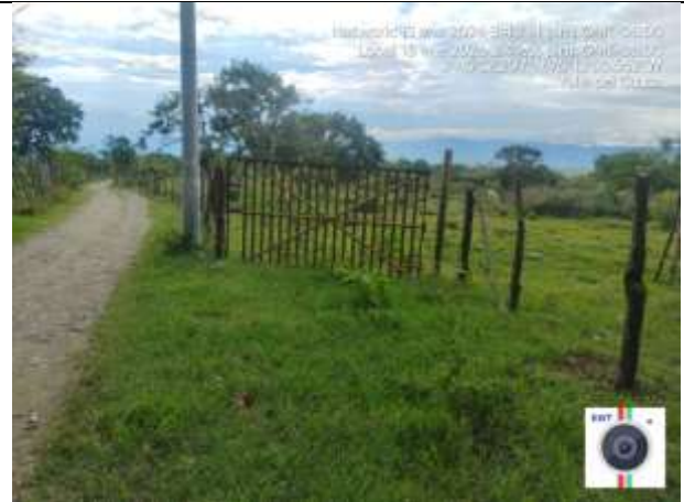
Fotografía 42. Instalación de Cerramiento definitivo entre la PTAP Ginebra y la finca Indigo – Callejo planta.
