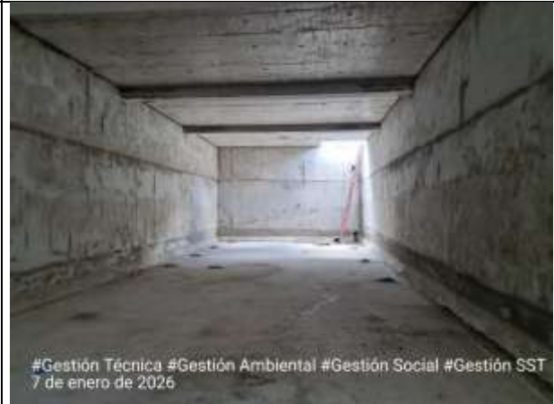
Fotografía 12. Finalizan con la actividad de emporado, subcontratista de impermeabilización inicia actividades.
