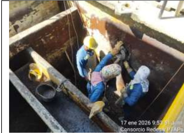
Fotografía 19. Nivelación de pasamuros Filtro N°3 PTAP Ginebra.
