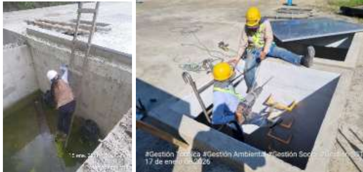
Ilustración 2. Acompañamiento en la instalación de peldaños en compartimientos y recámaras de entrada y salida del tanque.
