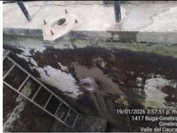
Fotografía 21. Instalación de Pasamuro y fundición de grouting de nivelación.
