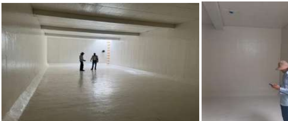
Ilustración 10. Entrega a Acuavalle de los dos compartimientos del tanque de Ginebra impermeabilizados.
