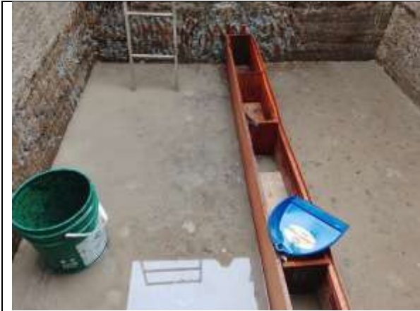
Fotografía 25. Encofrado de canal de fondo del falso fondo del filtro No.3 y aplicación de Sikadur 32.
