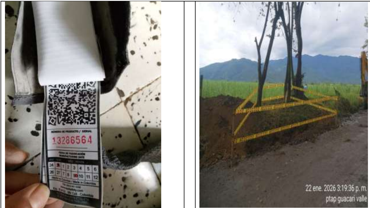
Fotografía. Señalización, cerramientos en frentes de obra y control de tráfico, inspecciones de equipos de altura y actividades en cada frente
