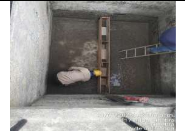
Fotografía 24. Encofrado de canal de fondo del falso fondo del filtro No.3.
