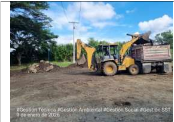
Fotografía 9. Durante el cargue, se selecciona el material a utilizar en el lleno para garantizar una compactación adecuada del material.
