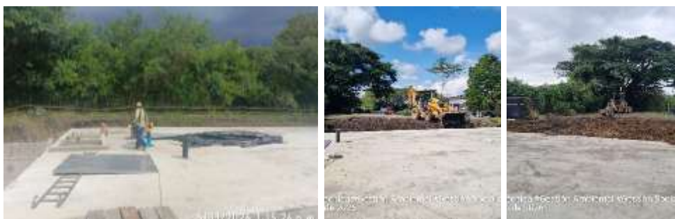
Ilustración 4. Chequeo de niveles y cantidades para el relleno perimetral del tanque.
