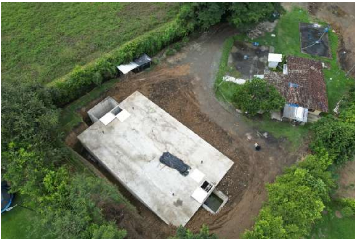
Ilustración 7. Toma de fotos aéreas en todos los frentes de obra que se realizan actividades de obra – Tanque de la Albania.
