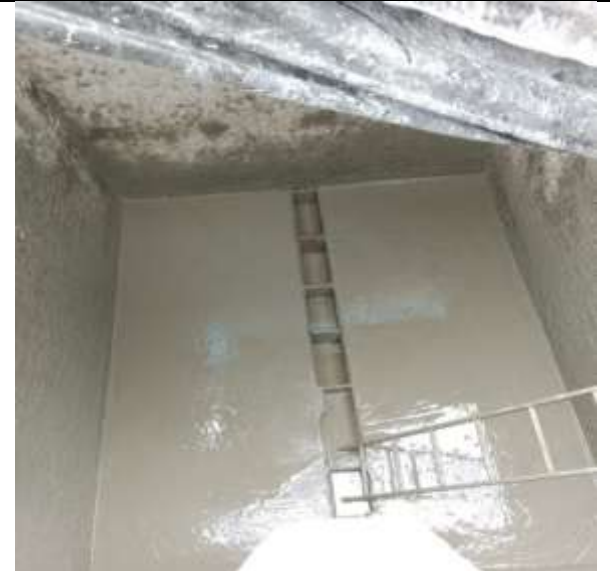
Fotografía 28. Fundición de la losa de fondo del tanque del filtro No.3.
