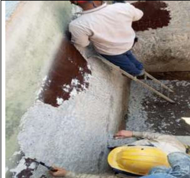
Fotografía 27. Escarificación de muros del tanque del Filtro No.3.
