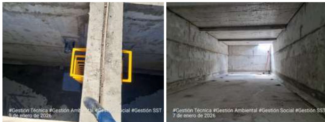
Ilustración 11. Instalación de peldaños en, tratamiento de fisuras, preparación de superficies y relleno perimetral.
