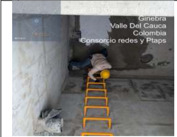
Fotografía 11. Suministros e instalación de peldaños en el tanque para su instalación.
