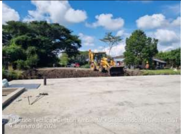
Fotografía 16. Continúan con la actividad de extender y compacta el material en todo el perímetro del tanque.
