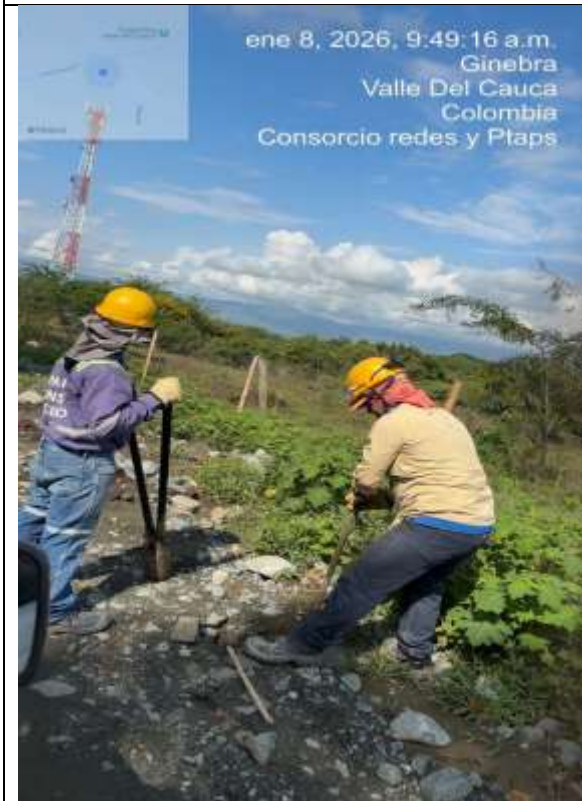
Fotografía 43. Instalación de postes en madera para reposición del cerramiento desmontado.
