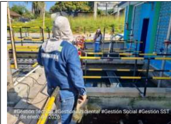
Fotografía 17. Chequeo de medidas y cotas con la topografía.
