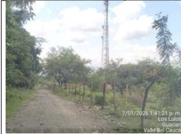
Fotografía 41. Suministro de materiales para traslado de cerramiento – Cerramiento definitivo.
