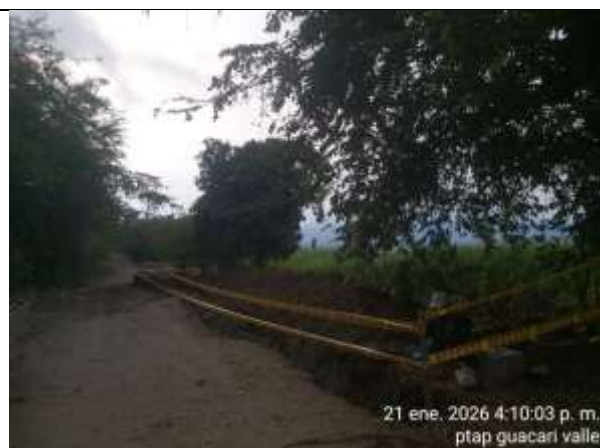
Fotografía 52. Se reinicia con la actividad de instalación de tubería en pases de alcantarillas transversales.
