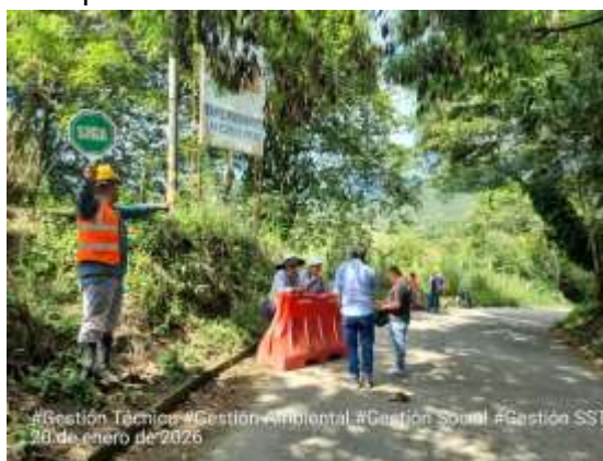
Ilustración 16. Suspensión temporal de actividades en el tramo 2 (El Alto – Puente Rojo) por inconformidad de la comunidad aledaña.
