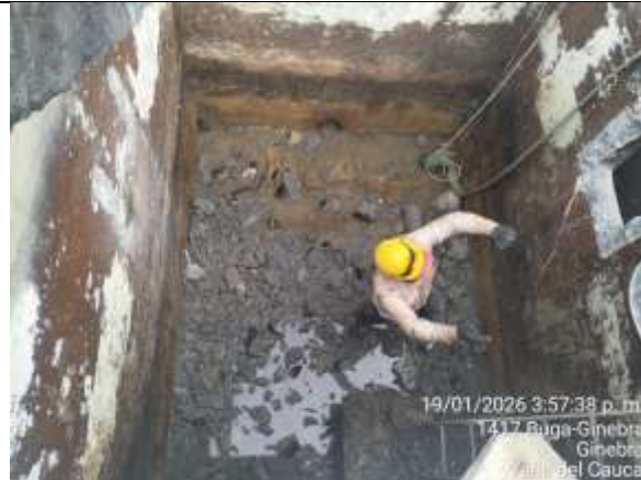
Fotografía 23. Demolición de falsos fondos del tanque del filtro No.3.
