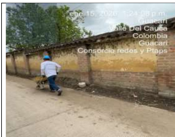
Fotografía 51. Retiro de material sobrante de excavación en muro existente.
