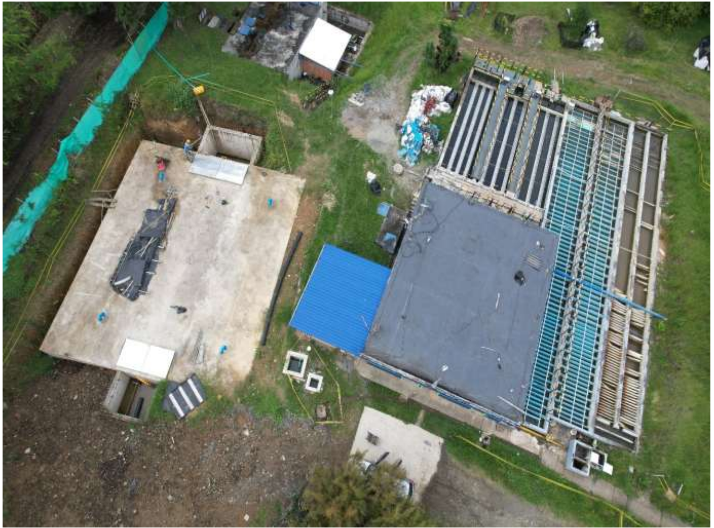
Ilustración 5. Toma de fotos aéreas en todos los frentes de obra que se realizan actividades de obra – PTAP Ginebra.
