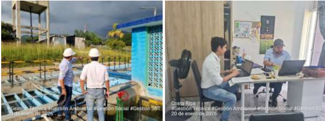
Ilustración 25. Visita del asesor de Seguros Mundial para recorrido de frentes de obra y seguimiento al avance del proyecto.
