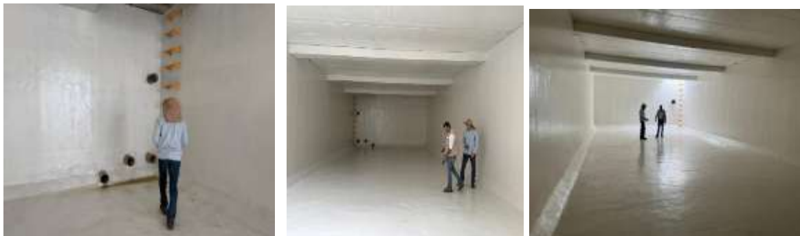
Ilustración 30. Entrega parcial al operador de la planta posterior a la revisión y detallado de la pintura epóxica.
