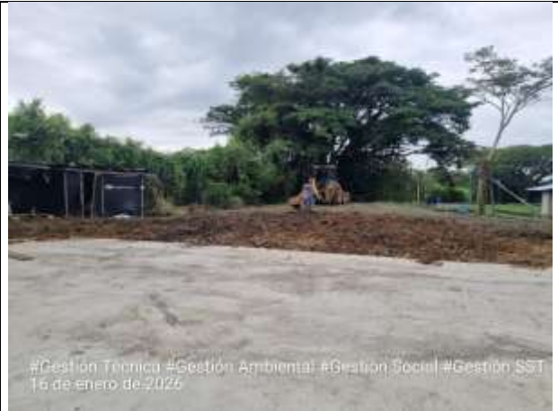
Fotografía 14. Se extiende y compacta el material en todo el perímetro del tanque.
