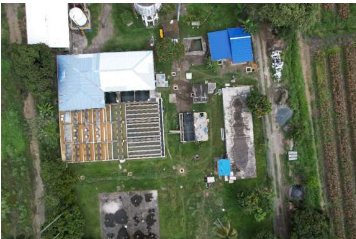
Ilustración 6. Toma de fotos aéreas en todos los frentes de obra que se realizan actividades de obra – PTAP Guacarí.
