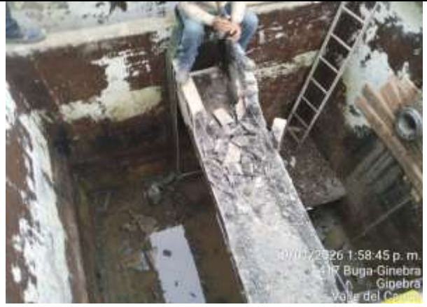
Fotografía 22. Demolición de canaleta en concreto del tanque del filtro No.3.
