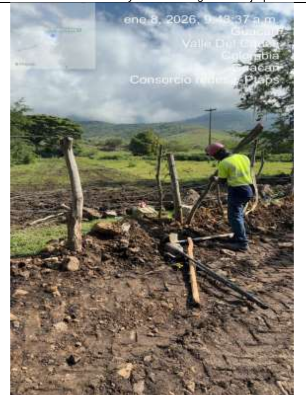
Fotografía 44. Se instala los postes de madera similares a los existentes.
