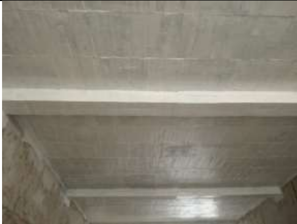
Fotografía 15. Se inicia con la impermeabilización del tanque.
