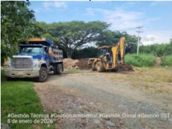
Fotografía 7. Cargue de material para Trasiego de material en tanque Albania – Relleno de material seleccionado.
