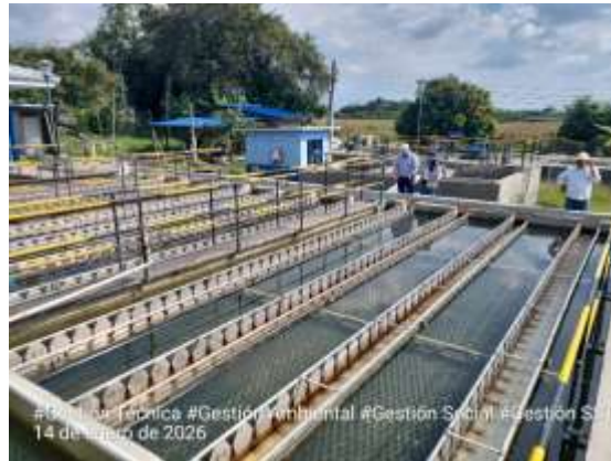
Ilustración 23. Visita técnica del ingeniero de metalmecánica de Coningeniería para revisión de actividades pendientes en las PTAP de Ginebra y Guacarí.
