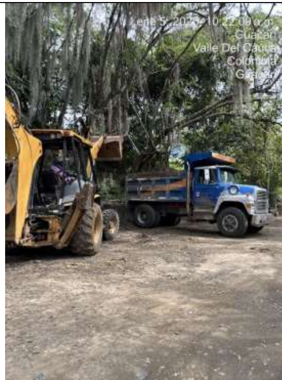
Fotografía 54. Cargue de material sobrante de excavación sobre el tramo 3 – Sector la Magdalena.
