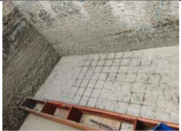
Fotografía 26. Fundición de la losa de fondo del tanque del filtro No.3- Instalación de refuerzo.
