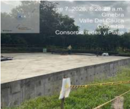
Fotografía 8. Se verifica las áreas perimetrales del tanque para realizar la actividad de relleno.
