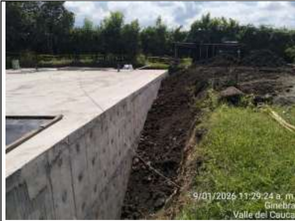
Fotografía 13. Relleno perimetral del tanque con material seleccionado.
