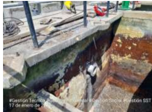
Ilustración 1. Cheque y acompañamiento técnico en la instalación de pasamuros y válvulas del tanque del filtro No. 3.
