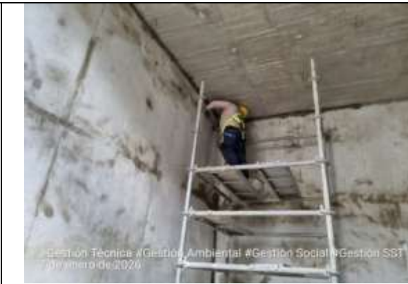
Fotografía 10. Se ha realizado el emporado del tanque en los dos compartimientos.
