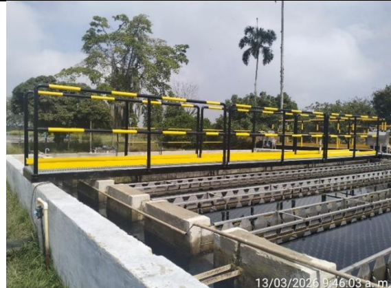
Fotografía 28. Finalizan con la Instalación de pasarelas en sedimentadores.
