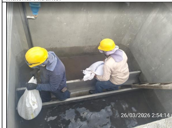
Fotografía 37. Instalación segunda parte Filtralite.
