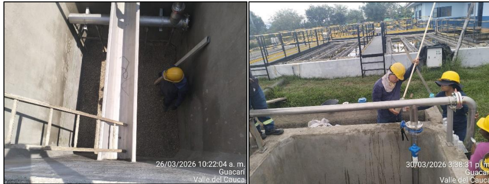
Ilustración 1. Acompañamiento en la instalación de gravas y Filtralite en Batería B de la PTAP Ginebra.
