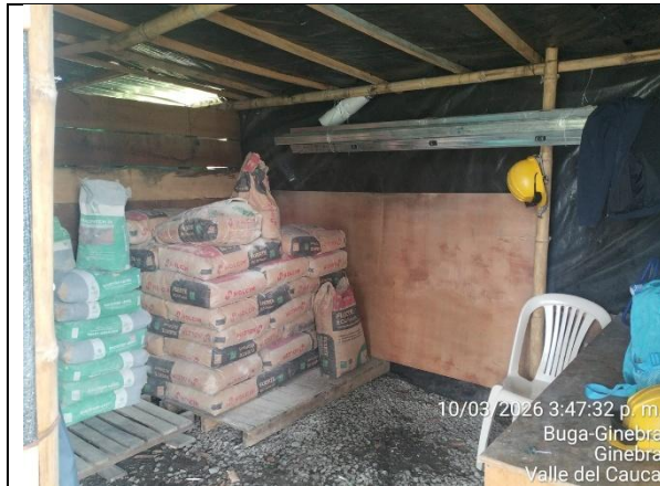
Fotografía 19. Suministro de materiales para optimización de las plantas.
