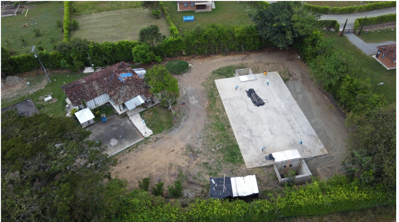
Ilustración 7. Toma de fotos aéreas en todos los frentes de obra que se realizan actividades de obra – Tanque de la Albania.
