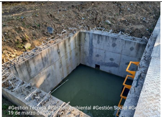
Fotografía 12. Se realiza la limpieza en las cámaras de entrada y salida del tanque.
