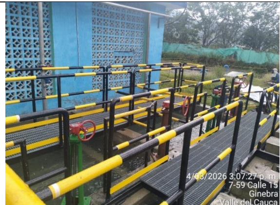
Fotografía 18. Fundición de concreto Grouting para nivelación de canaleta del filtro No.3.
