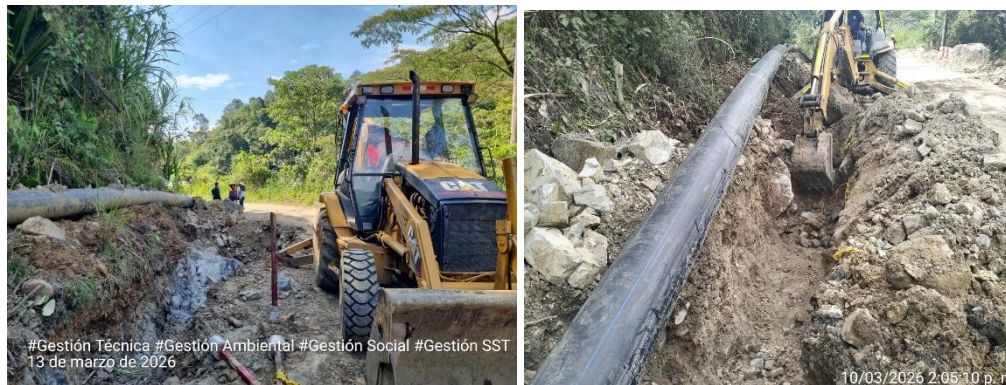
Ilustración 10. Excavación y retiro de material sobrante de excavación sobre el tramo 1 – Sector Regaderos.
