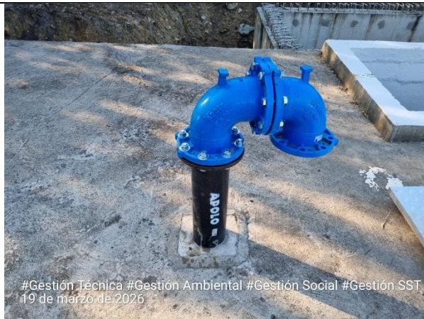
Fotografía 9. Se instalan los codos en los respiraderos del tanque de la Albania.
