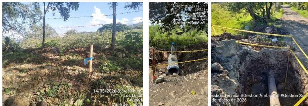
Ilustración 3. Acompañamiento de la comisión de topografía en la construcción de pases y cajas Ventosas, Purgas y Cámaras de Quiebre del Tramo No.3.
