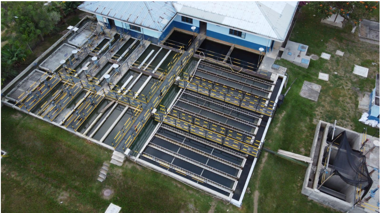
Ilustración 6. Toma de fotos aéreas en todos los frentes de obra que se realizan actividades de obra – PTAP Guacarí.
