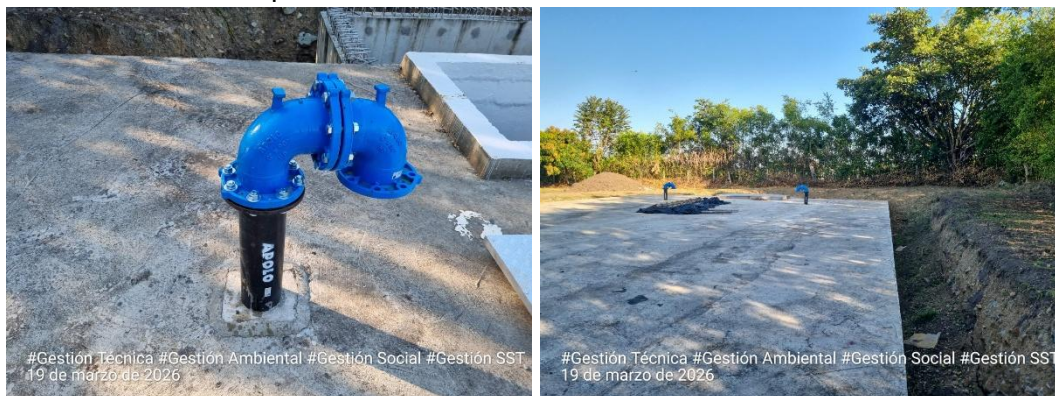
Ilustración 12. Instalación de respiraderos del tanque y relleno perimetral del tanque.
