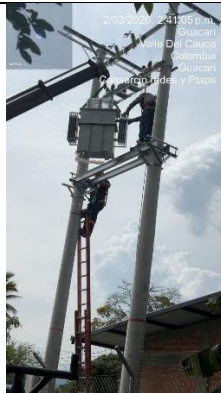
Fotografía 29. Revestimiento de postes y acometida eléctrica en PTAP Guacarí.
