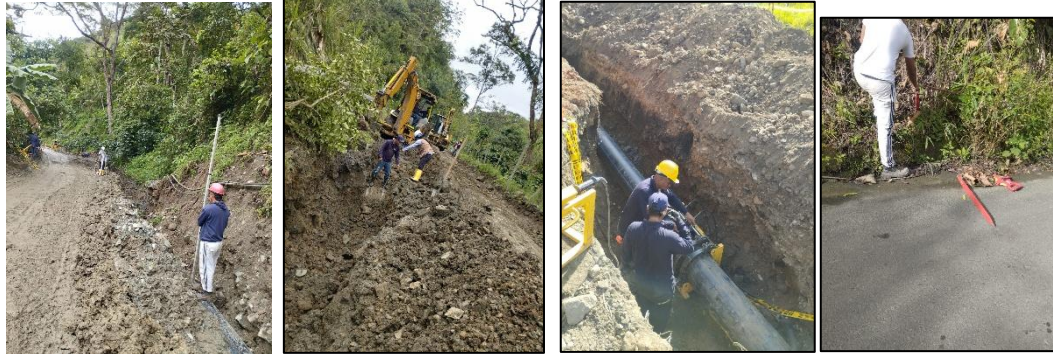
Ilustración 2. Acompañamiento a la instalación de tubería PEAD de 18" y levantamiento topográfico para la ubicación y optimización de cámaras de quiebre en el Tramo 1.
