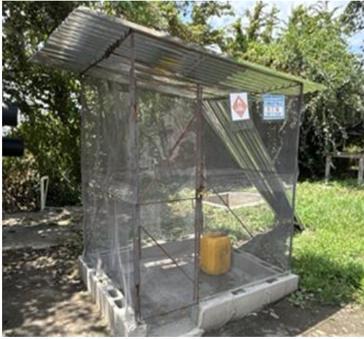
Foto 5. Almacenamiento de combustible – PTAP Guacarí
