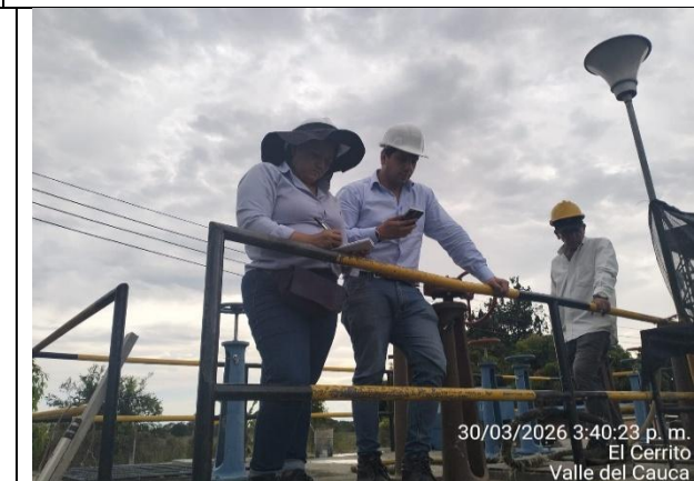
Fotografía 38. Supervisión continua de la instalación de materiales y chequeo de niveles con comisión de topografía.
