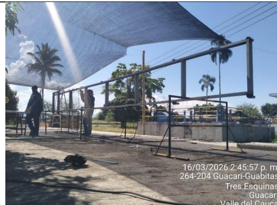
Fotografía 24. Fabricación de estructuras para pasarelas en PTAP Guacarí.
