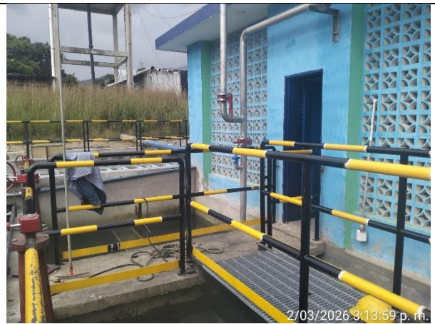
Fotografía 16. Instalación de estructura de pasarela, pasamanos y pasillo de filtros No.2 y No.3.
