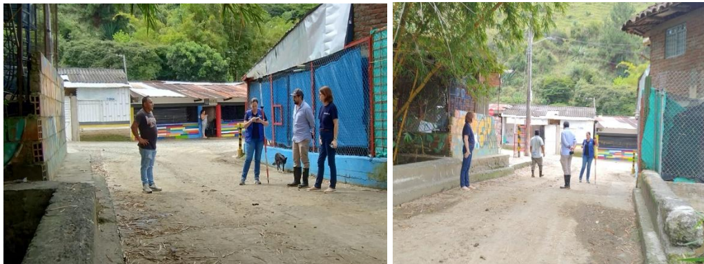
Ilustración 21. Recorrido técnico y levantamiento topográfico en Puente Rojo y Puente La Magdalena para gestión de servidumbres del proyecto.
