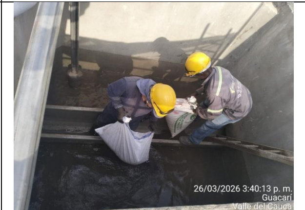
Fotografía 34. Instalación primera parte Filtralite.
