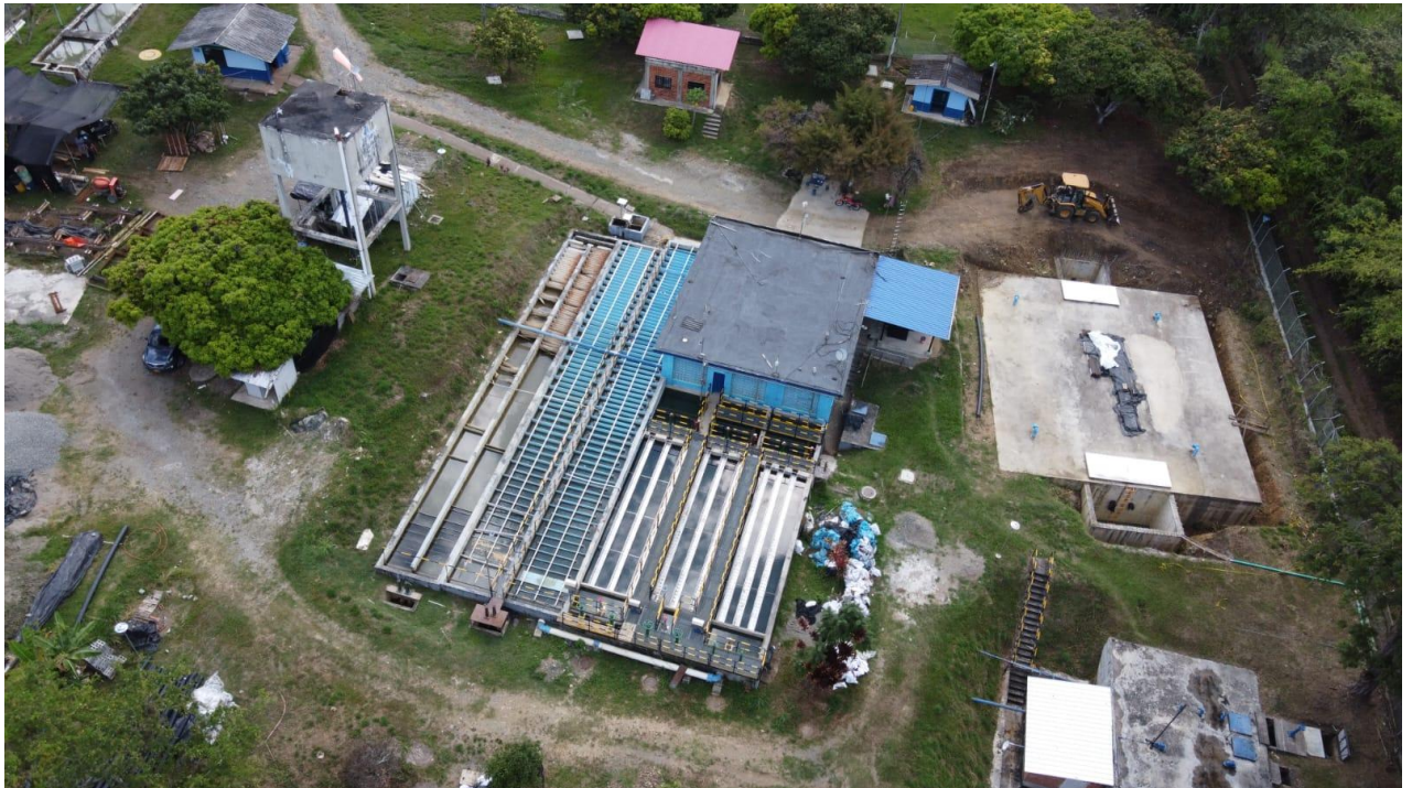
Ilustración 5. Toma de fotos aéreas en todos los frentes de obra que se realizan actividades de obra – PTAP Ginebra.
