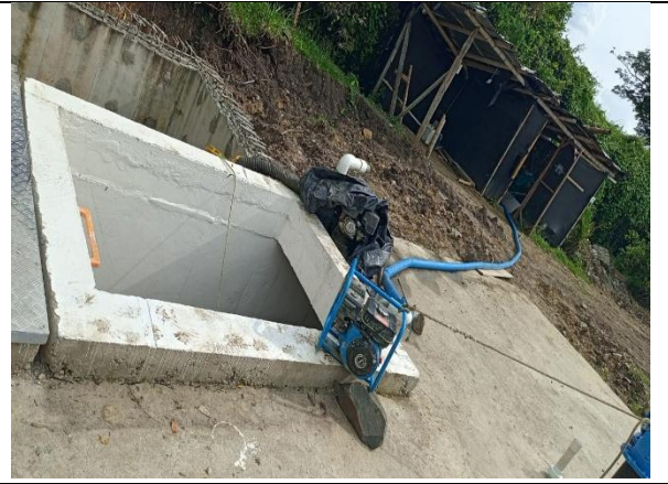
Fotografía 8. Se inicia con la actividad de retiro de agua del tanque de la Albania.
