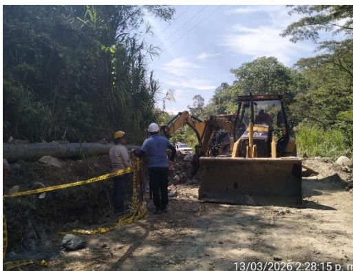
Ilustración 22. Recorrido técnico en el sector Regaderos para evaluar mejoras en la instalación de tubería y el sistema de conducción.
