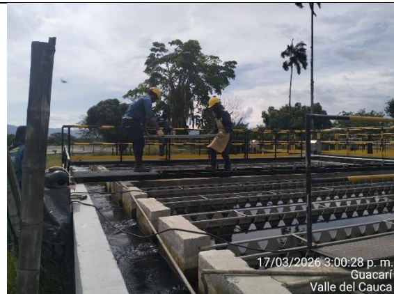
Fotografía 23. Instalación de Pasamanos y pasarelas en sedimentadores.
