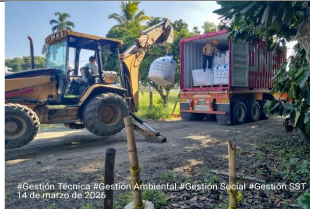
Fotografía 26. Descargue y acopio de big bag de Filtralite.
