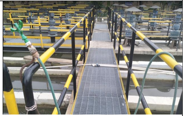
Fotografía 30. Adecuación de detalles para entrega de pasarelas en los floculadores.
