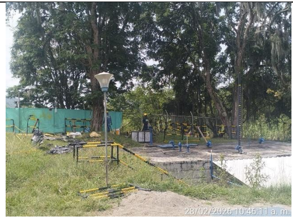
Fotografía 20. Fabricación de estructura y pasamanos para la Planta de tratamiento.
