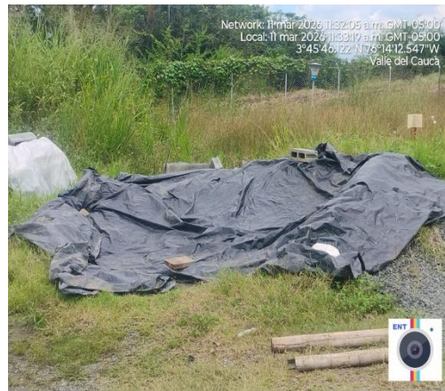
Foto 8. Cubrimiento de material pétreo- PTAP GINEBRA
