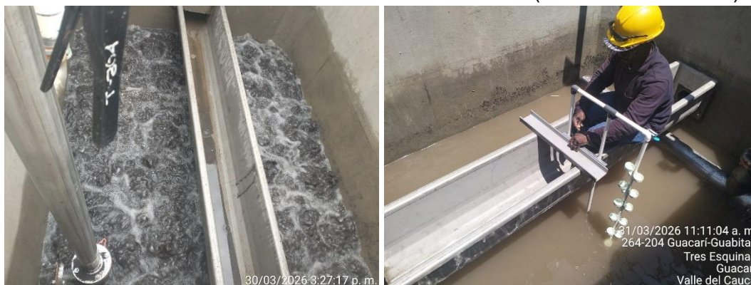
Ilustración 11. Suministro de Grava, Filtralite y Pruebas de calidad y funcionamiento en Filtro N.4 de la Batería B.
