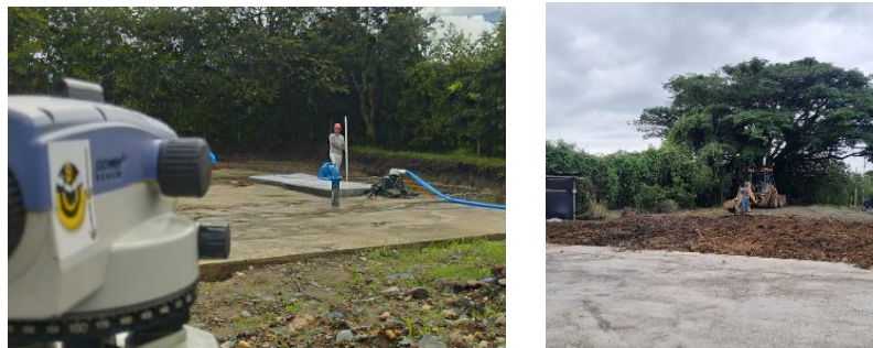
Ilustración 4. Chequeo de niveles y cantidades para el relleno perimetral del tanque.
