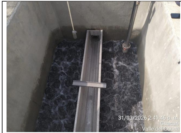
Fotografía 31. Prueba de alimentación de aire en los Falsos fondos.
