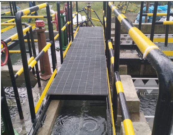
Fotografía 15. Canal de salida de sedimentadores, desmonte de pasarela existente e instalación de pasillos nuevos con pasamanos.
