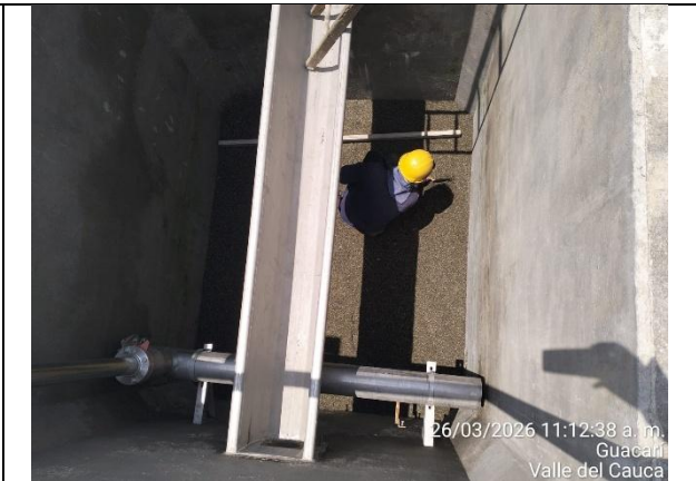
Fotografía 32. Instalación grava de soporte de Filtralite.
