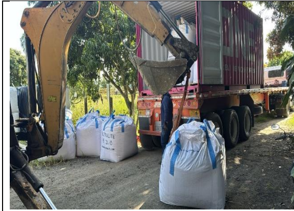
Fotografía 25. Suministro de Filtralite faltante del tamizado del primer lote.
