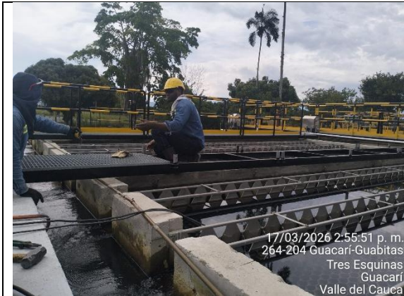
Fotografía 21. Instalación de estructura metálica para pasillos y pasamanos.
