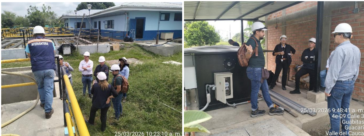
Ilustración 18. Puesta en marcha y pruebas de los sopladores en la PTAP de Guacarí para la batería B de filtros.
