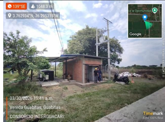
Fotografía 27. Reinician con la instalación de acometidas eléctricas y conexiones en la Planta.
