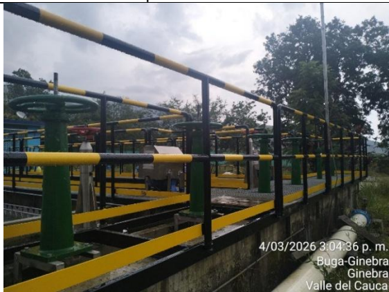
Fotografía 17. Instalación de pasamanos y estructura de pasarela en canal de entrada de sedimentador No.1.
