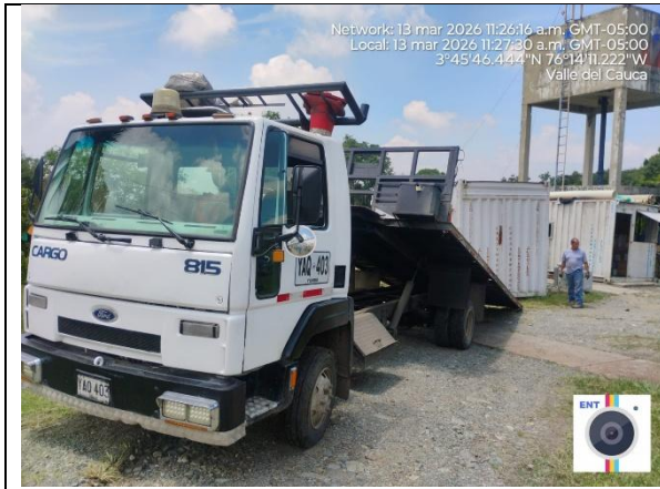
Fotografía 13. Retiro de Contenedor de oficina de la PTAP de Ginebra, la nueva oficina de obra se ubicará en la PTAP de Guacarí.
