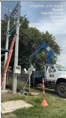
Fotografía 29. Revestimiento de postes y acometida eléctrica en PTAP Guacarí.
