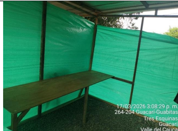
Fotografía 22. Adecuación de área administrativa en PTAP Guacarí.
