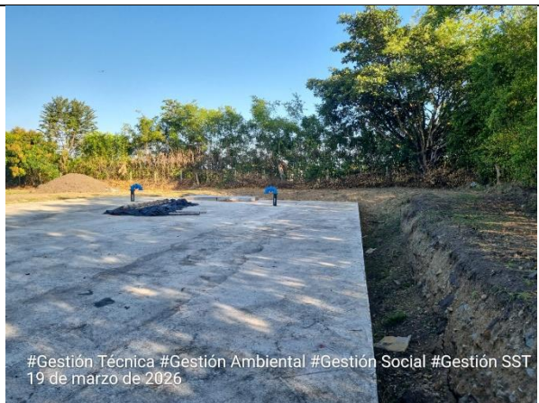
Fotografía 11. Se reinicia con la actividad de lleno lateral del tanque con material seleccionado.
