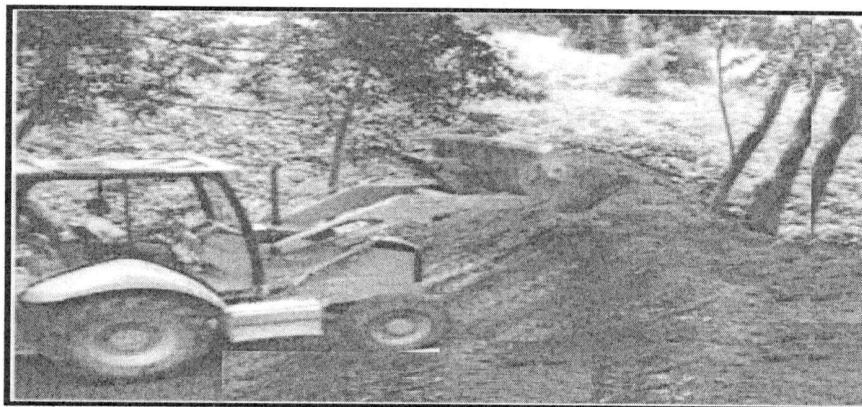
Figura 3. Conformación dique para la represa
