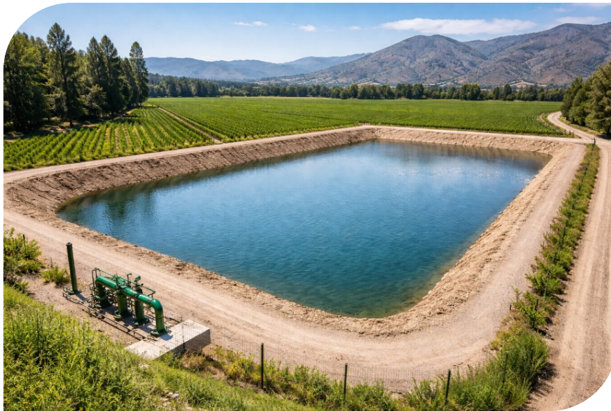
Foto No. 2: Imagen reservorio excavado para almacenamiento de agua
