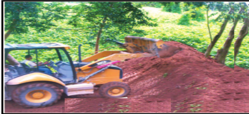
Figura 3. Conformación dique para la represa
