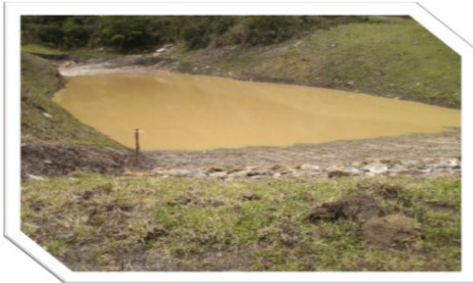
Foto No. 1: Ilustración de reservorio excavado para almacenamiento de agua construido por la Corporación en el municipio de Mutiscua. Norte de Santander
