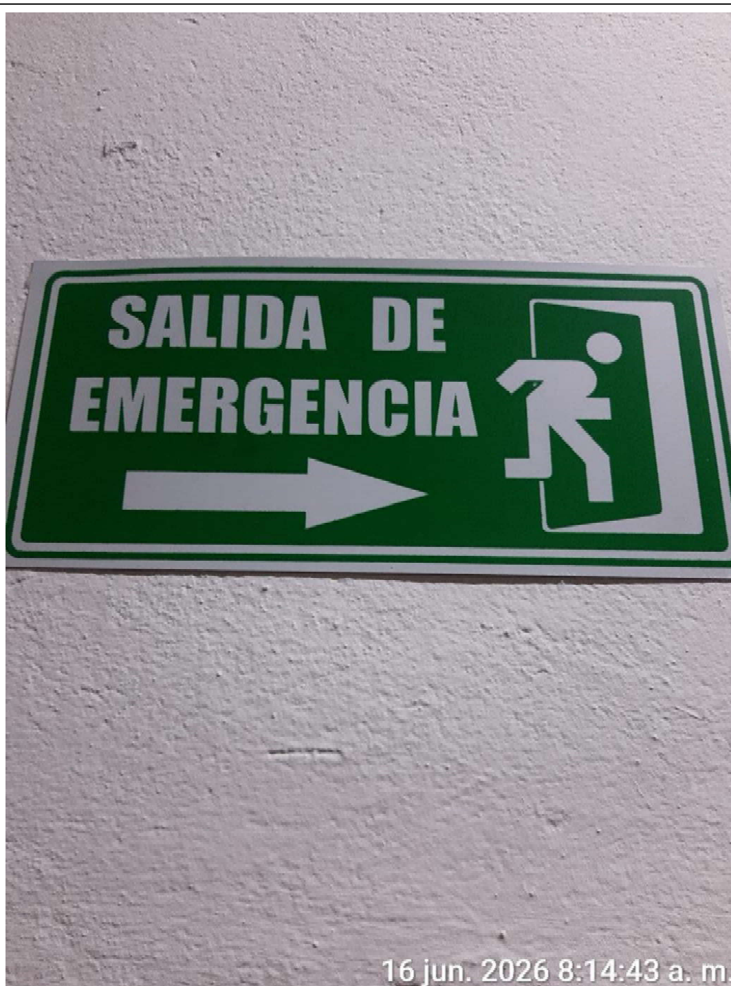
Foto 23. Verificación de los sistemas de seguridad (señalización), en cumplimiento de la obligación 15 del contrato.
