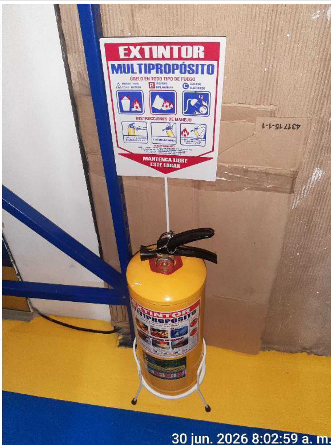
Foto 14. Verificación de los sistemas de seguridad (extintor), en cumplimiento de la obligación 15 del contrato.
