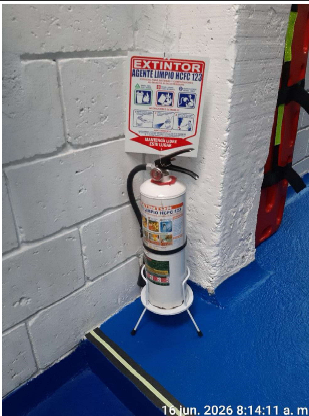
Foto 20. Verificación de los sistemas de seguridad (extintor) en cumplimiento de la obligación 15 del contrato.
