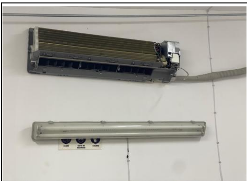
MANTENIMIENTO DE AIRE ACONDICIONADO
