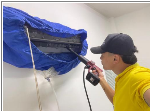
MANTENIMIENTO DE AIRE ACONDICIONADO
