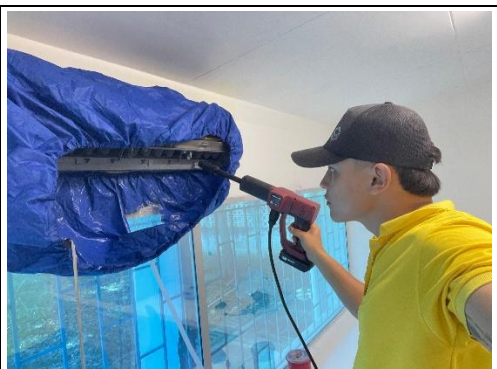
MANTENIMIENTO DE AIRE ACONDICIONADO
