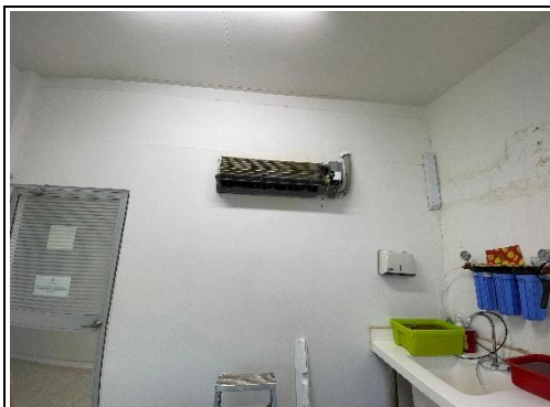
MANTENIMIENTO DE AIRE ACONDICIONADO
