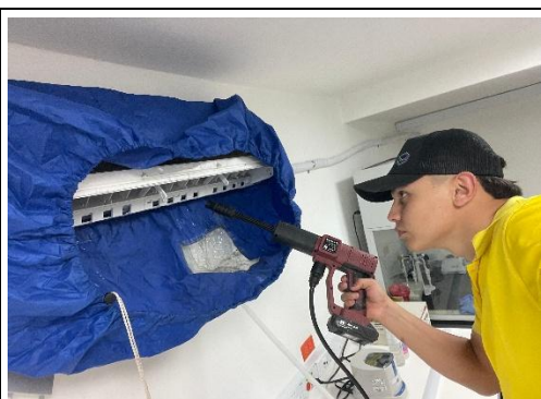
MANTENIMIENTO DE AIRE ACONDICIONADO
