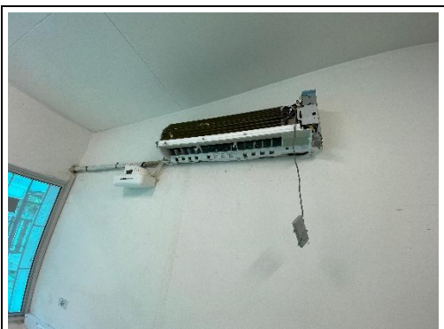
MANTENIMIENTO DE AIRE ACONDICIONADO
