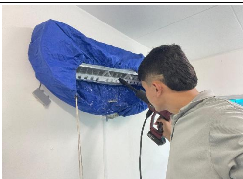
MANTENIMIENTO DE AIRE ACONDICIONADO
