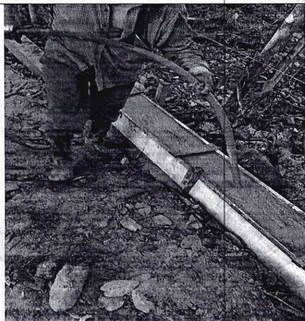
concreto de 3000psi vigas de cimentación 20x20cm
