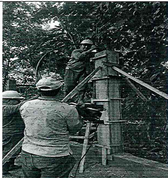
Concreto de 3000psi columnas 20x20cm
