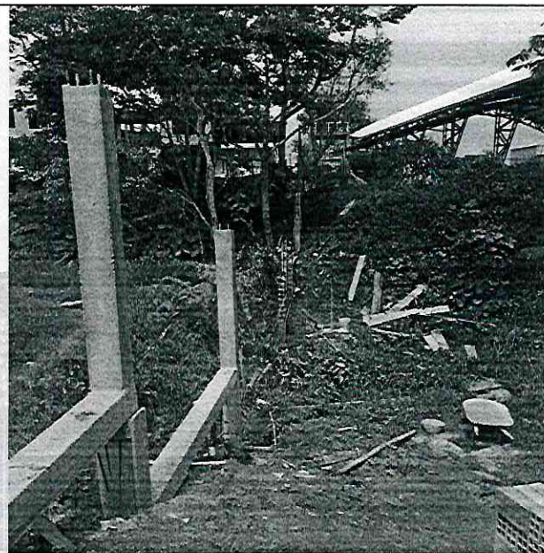
Concreto de 3000psi columnas 20x20cm
