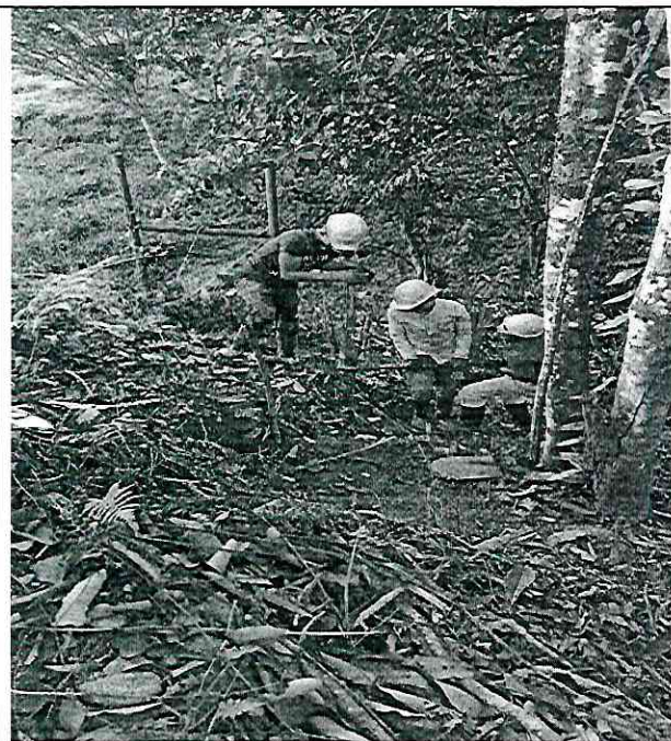
Descapote y retiro de material vegetal.
