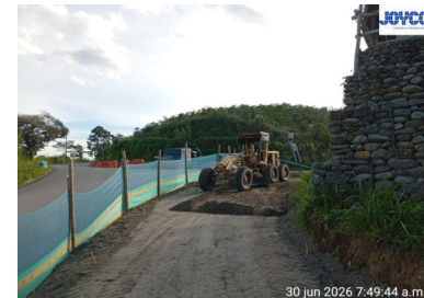
Instalación de subbase sector Glorieta de Cartagena.
