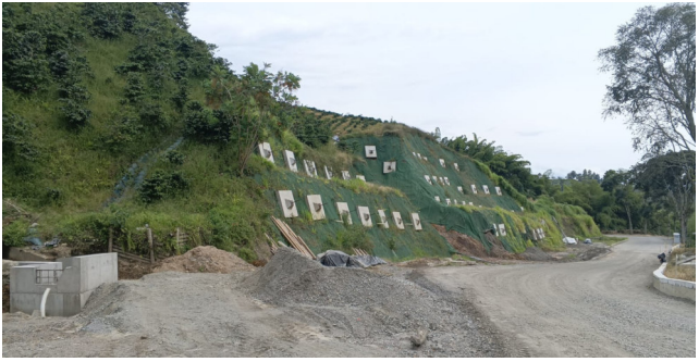
Zona de anclajes en K1+900 al K2+2058-Tramo mejoramiento y rehabilitación de vía.
