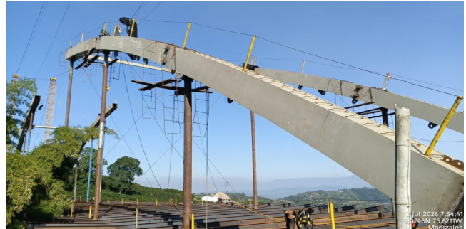
Revisión de las condiciones para el acceso a las áreas de trabajo
