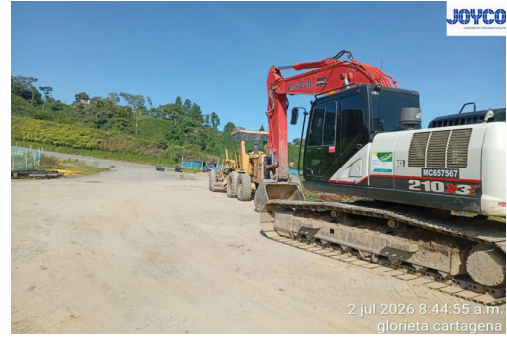
Revision y seguimiento equipos de obra
