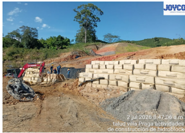
Actividad construcción de Hidrobloks (Talud de Villa Praga).
