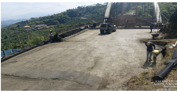
Condiciones de orden y aseo del estribo sur del puente de 100 metros
