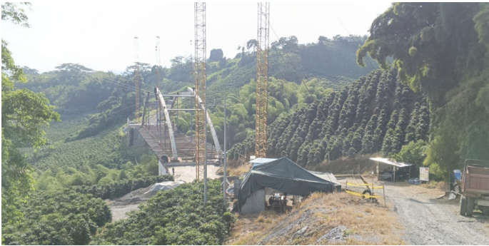
Estribo norte y sur puente de 100 metros.
