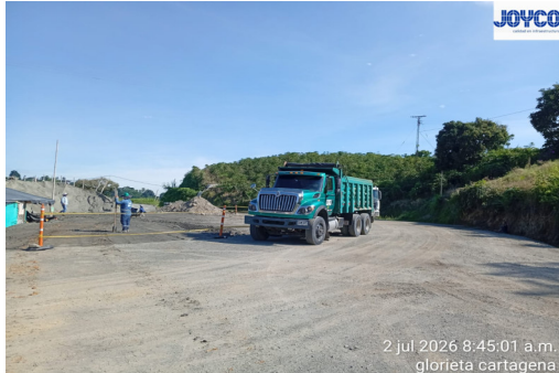
Revision y seguimiento equipos de obra
