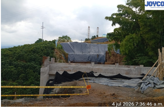
Estribo sur puente de 100 metros.
