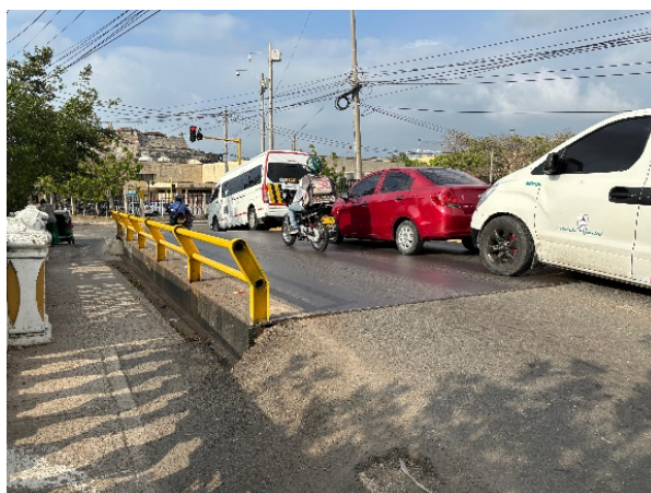
Figura 2.1. Estructura provisional existente del puente
