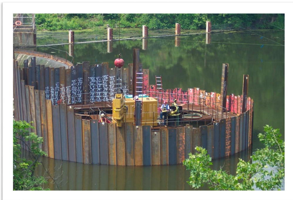
Figura 1. Construcción de ataguías.
