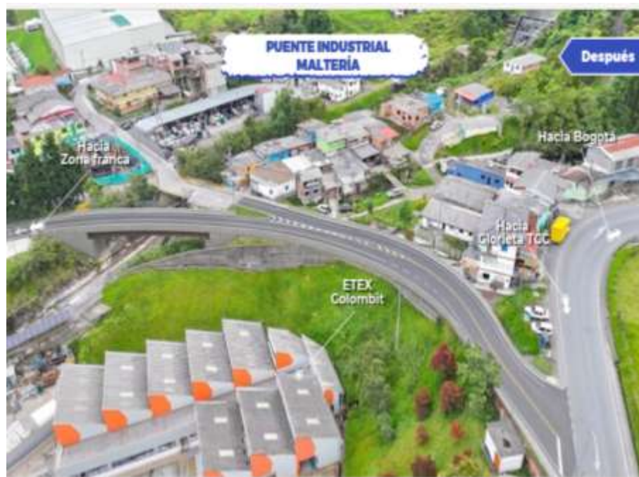
Render Descriptivo de la construcción de la obra.
