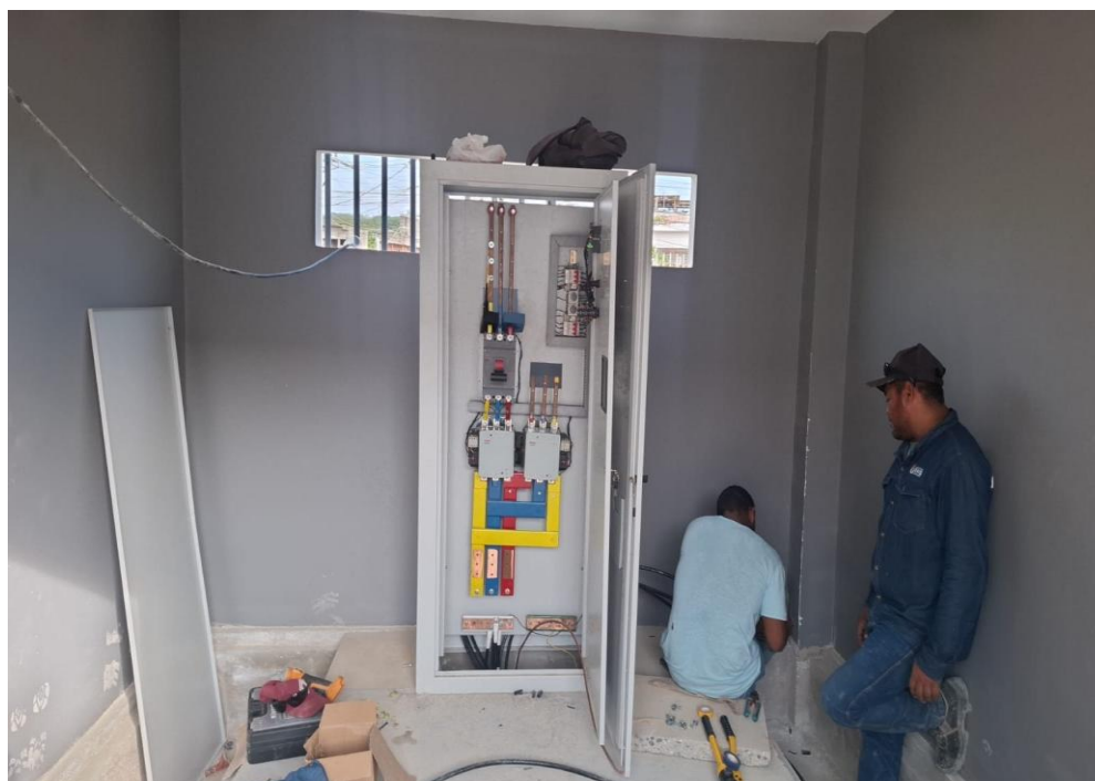
Ilustración 35. Instalación tableros eléctricos
