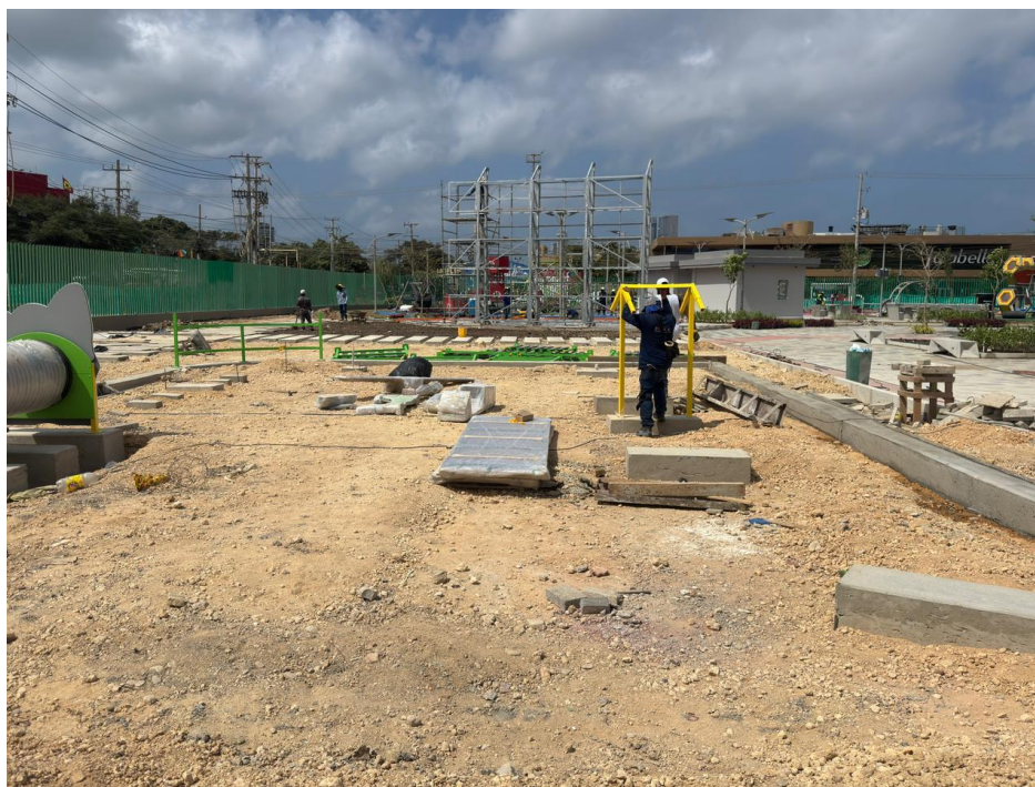
Ilustración 25. Relleno y compactación material seleccionado zona recuperada
