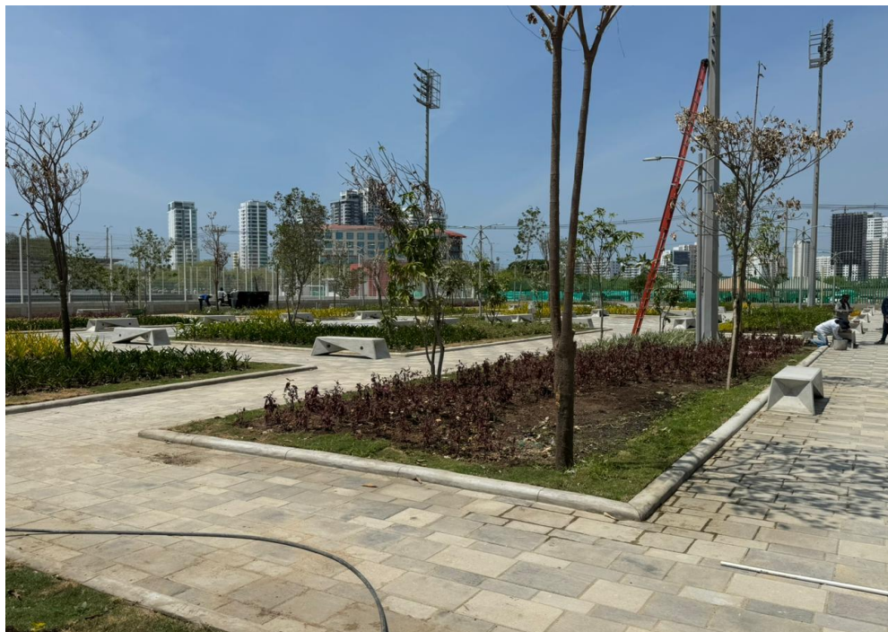
Ilustración 37. Losetas, bancas y paisajismo
