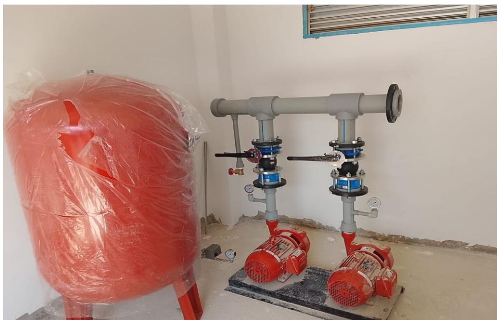
Ilustración 27. Instalación sistema de bombeo agua potable
