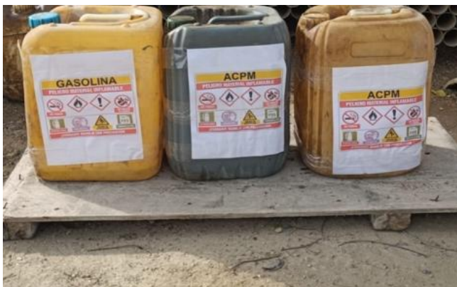
Ilustración 49. Almacenamiento sustancias peligrosas.
