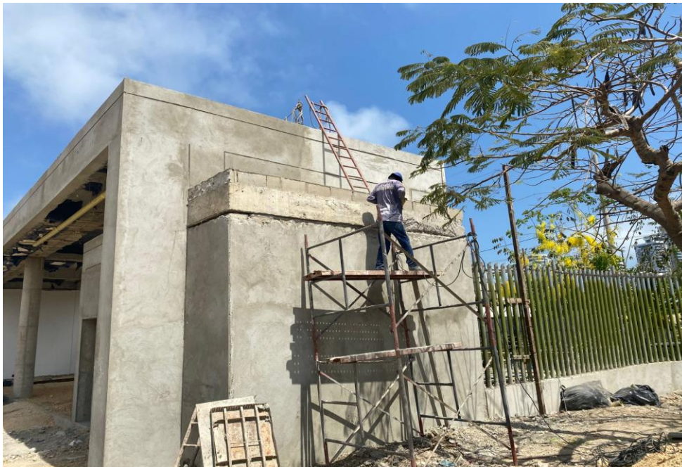
Ilustración 13. Pañete acceso principal
