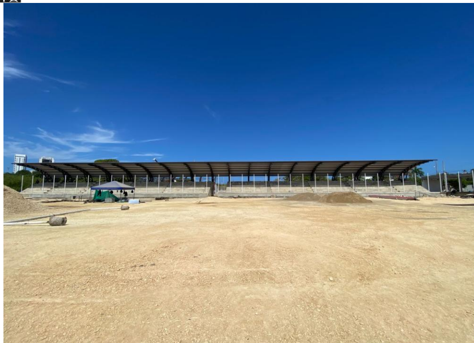
Ilustración 18. Instalación cerchas metálicas para cubierta graderías de futbol
