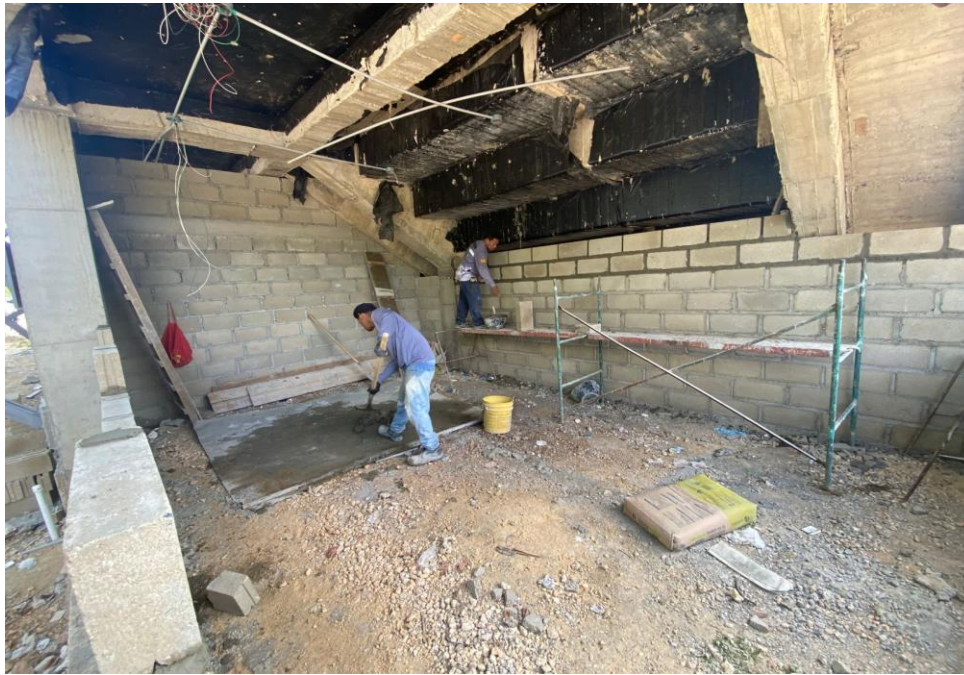
Ilustración 12. Levante en block No 4 enfermería graderías futbol
