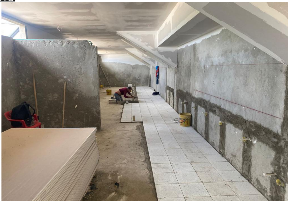
Ilustración 22. Instalación de pisos, enchape y cielo raso bodegas futbol 11
