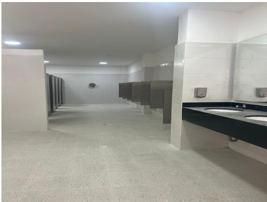
Ilustración 28. Instalación de pisos, enchape, cielo raso, pintura baños y aparatos sanitarios camerinos cancha futbol 9
