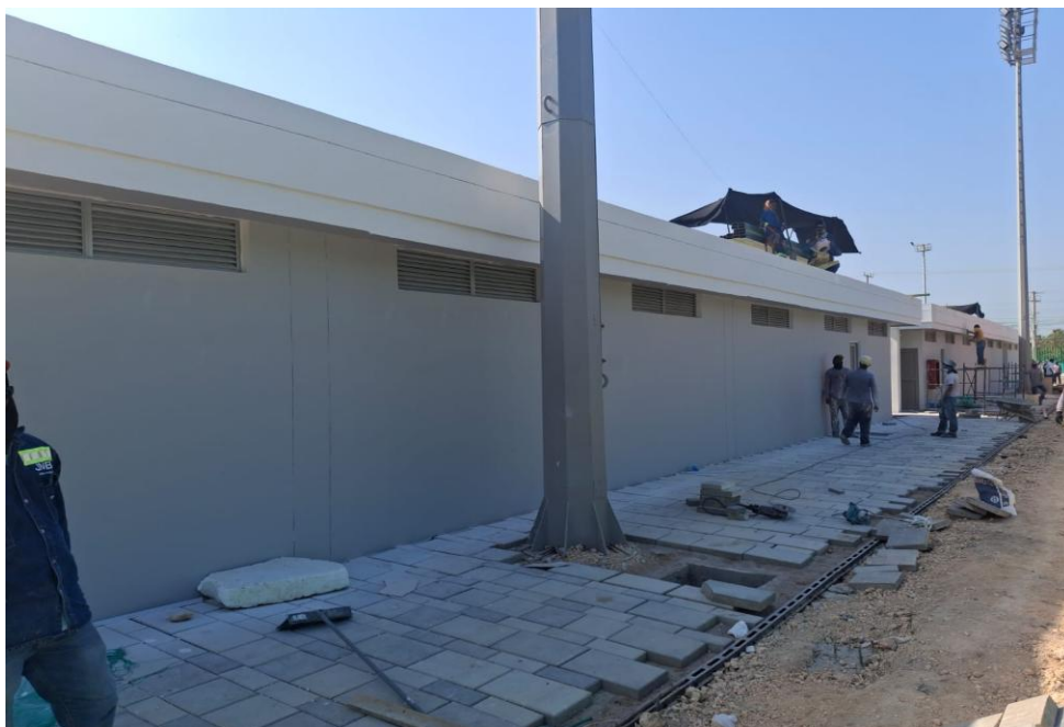
Ilustración 33. Pintura exterior baños y camerinos
