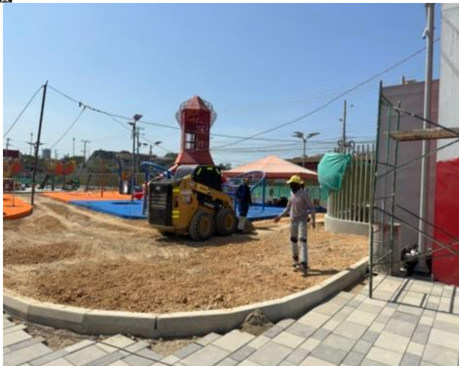
Ilustración 24. Relleno y compactación material seleccionado zonas juego de niños
