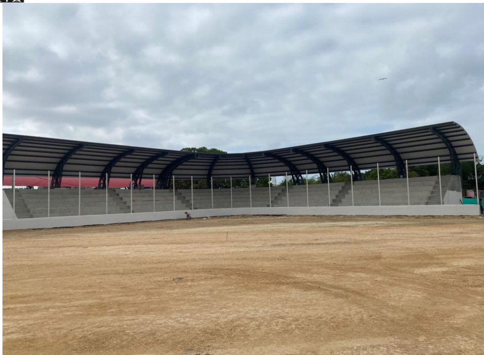
Ilustración 16. Instalación cubierta graderías de softbol
