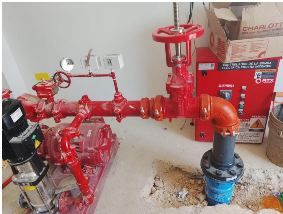
Ilustración 26. Instalación sistema de bombeo contraincendios
