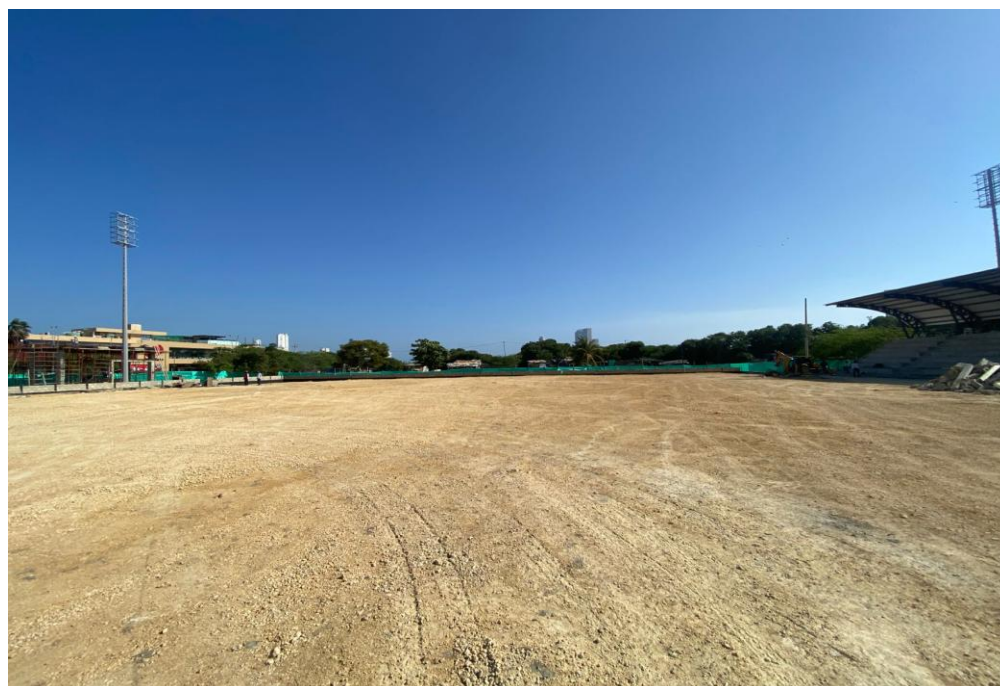
Ilustración 11. Relleno y compactación material seleccionado cancha de futbol
