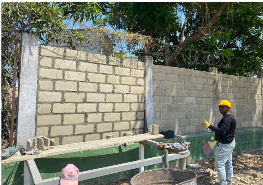
Ilustración 14. Levante en block No 4 muro cerramiento Estación de policía
