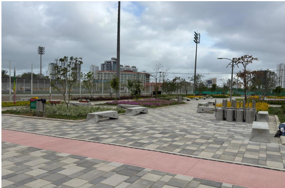
Ilustración 36. Instalación losetas zona central, bancas y paisajismo
