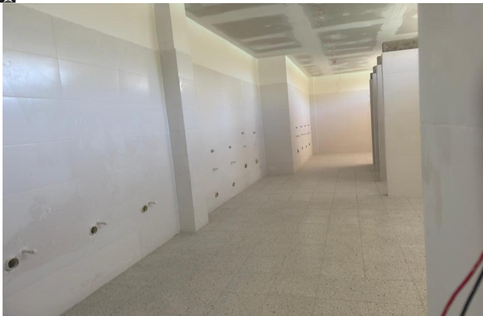
Ilustración 30. Instalación de pisos, enchape, cielo raso, y pintura baño hombres cancha futbol 9
