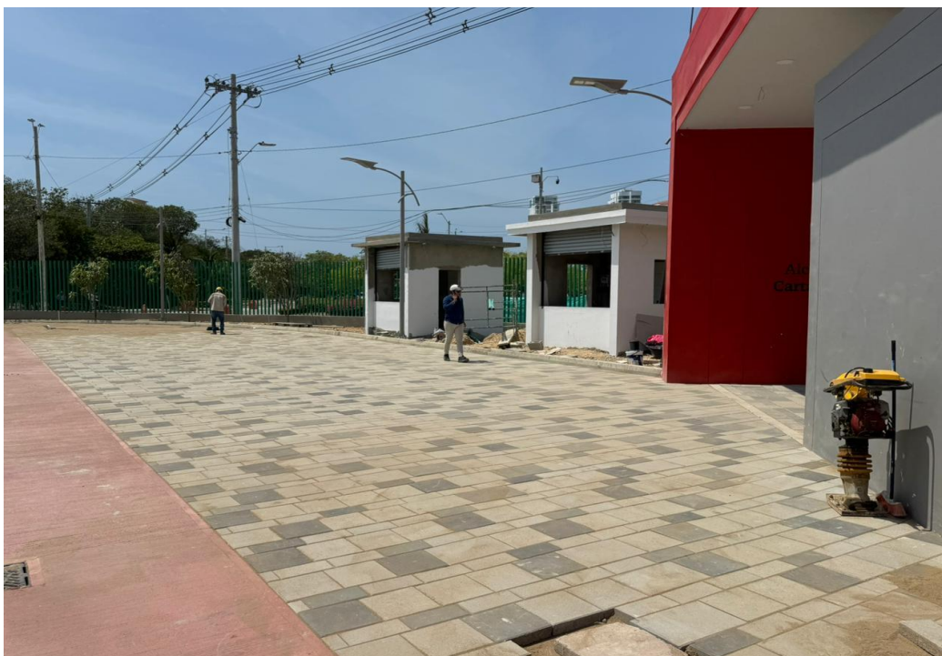
Ilustración 38. Instalación losetas y cafeterías zona de acceso parqueadero
