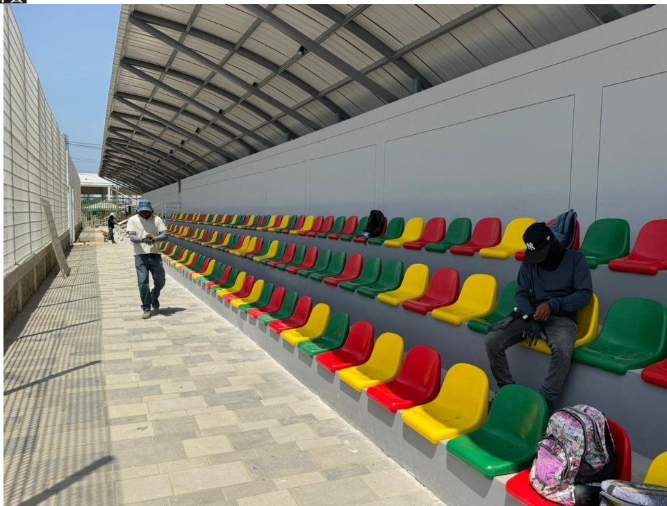
Ilustración 32. Instalación de sillas, estuco, pintura graderías
