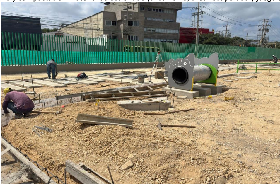
Ilustración 23. Relleno y compactación material seleccionado zona de mascotas área recuperada
