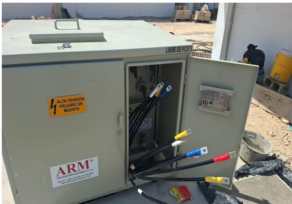
Ilustración 34. Instalación transformador eléctrico
