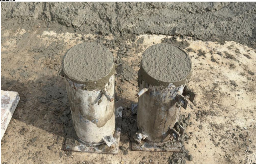
Ilustración 43. Toma de muestras concreto 4000 psi para mástiles ligas mayores
