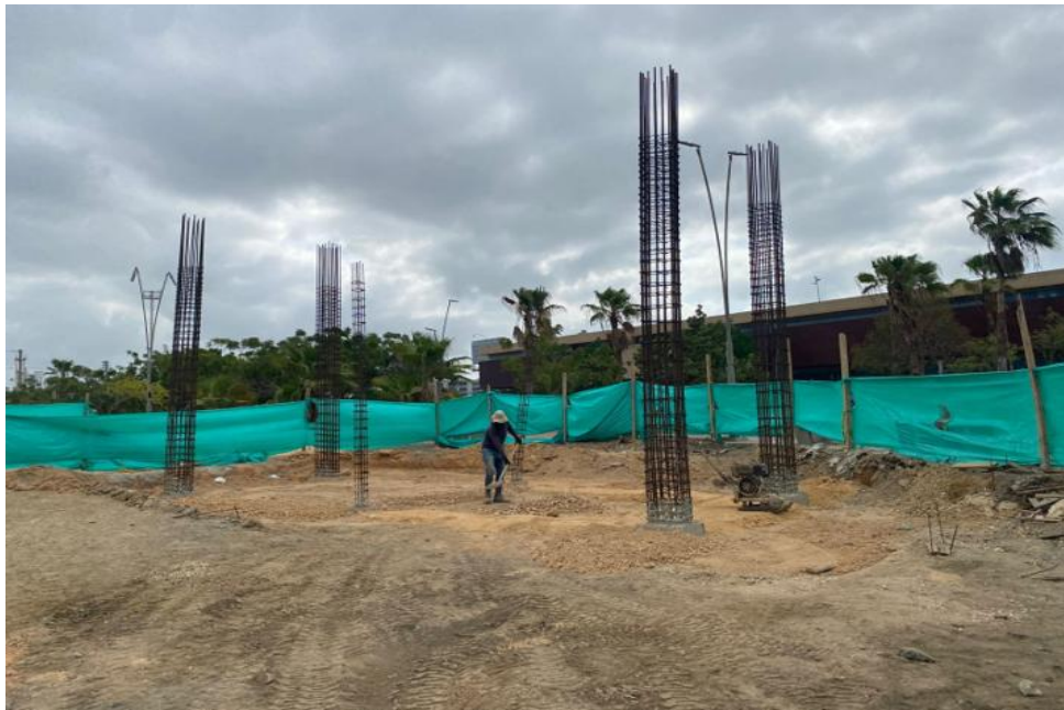
Ilustración 12. Relleno y compactación material seleccionado acceso Mall Plaza
