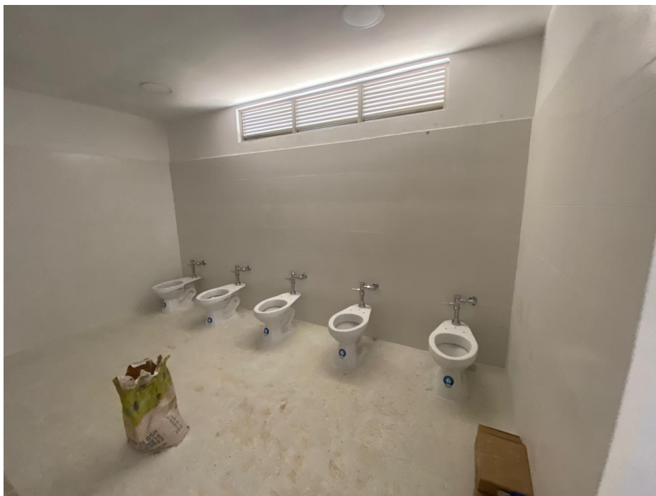
Ilustración 22. Instalaciones aparatos sanitario baños graderías de softbol
