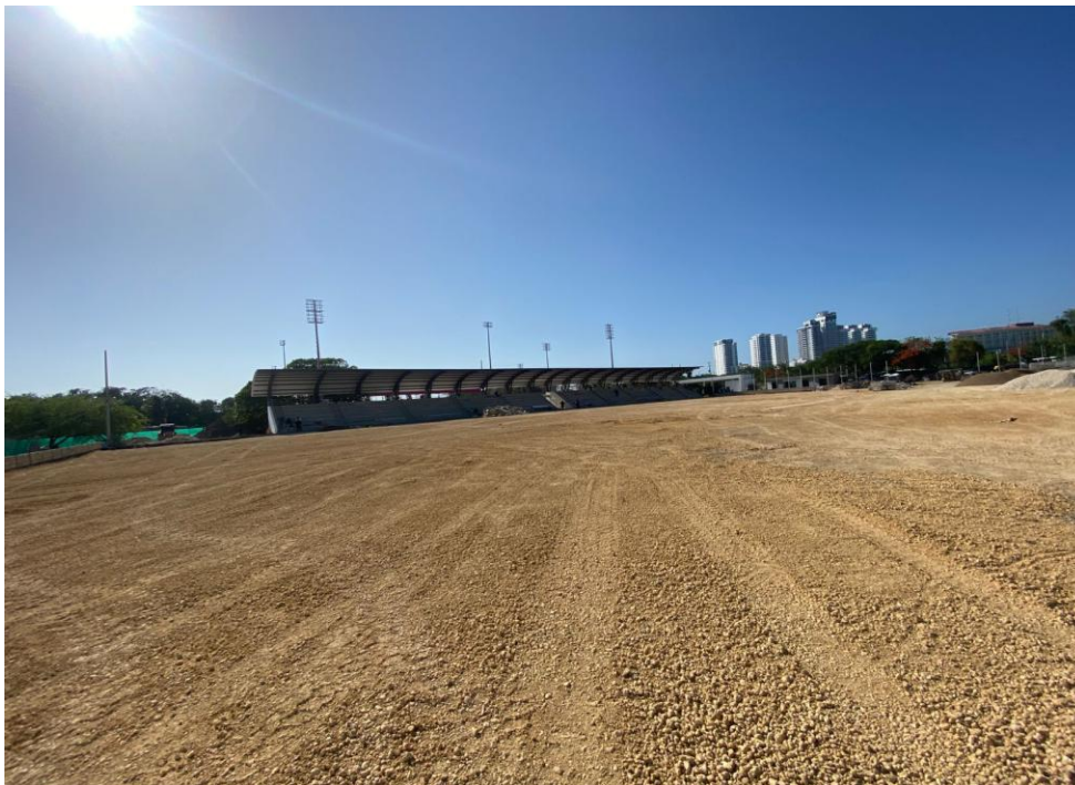
Ilustración 13. Relleno y compactación material seleccionado cancha de futbol
