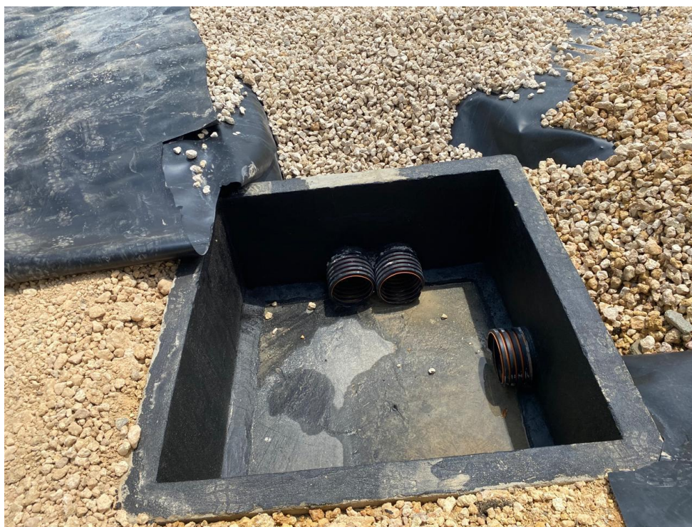
Ilustración 19. Drenaje cancha de softbol
