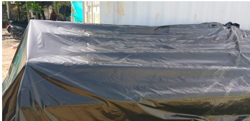
Ilustración 60. Carpado de materiales
