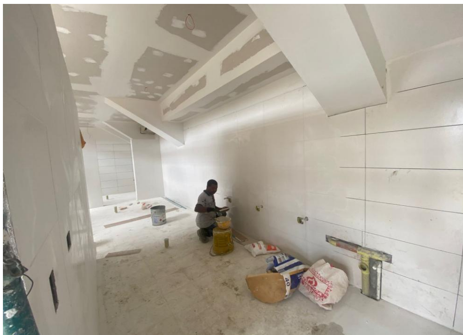
Ilustración 25. Instalación de pisos, enchape y cielo raso baños y camerinos cancha de futbol
