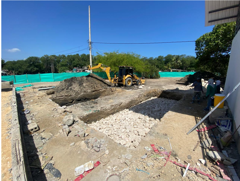
Ilustración 10. Excavación zapatas faltante graderías de futbol
