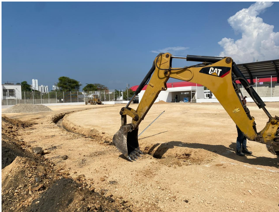
Ilustración 11. Excavación para instalación de tuberías de drenaje cancha de softbol
