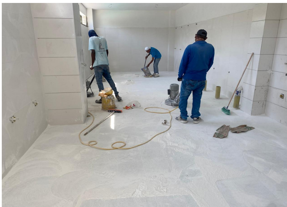
Ilustración 27. Instalación y pulida de pisos, instalación de enchape y cielo raso baños graderías futbol 11
