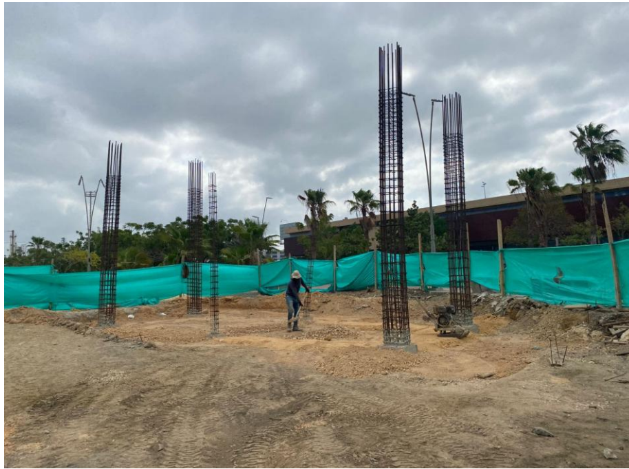
Ilustración 14. Instalación acero refuerzo 60.000 psi columnas acceso Mall Plaza
