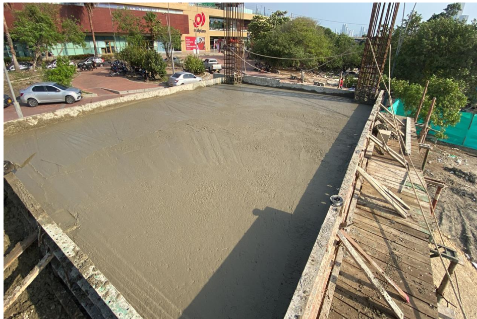
Ilustración 17. Fundida concreto de 4.000 psi placa de cubierta acceso Mall Plaza
