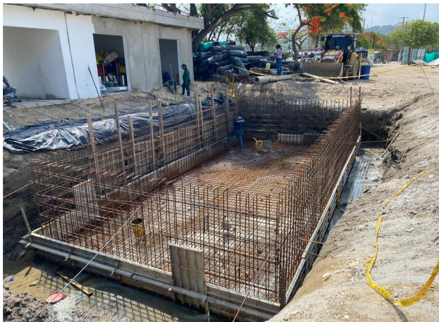
Ilustración 15. Instalación acero refuerzo 60.000 psi tanque de agua potable
