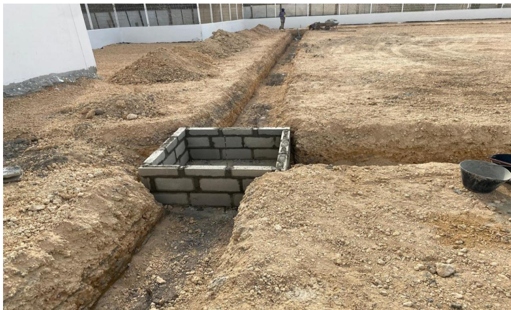
Ilustración 18. Drenaje cancha de softbol
