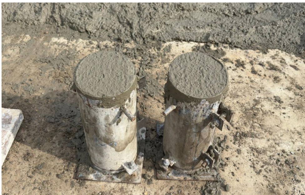
Ilustración 47. Toma de muestras concreto 4000 psi para mástiles ligas mayores
