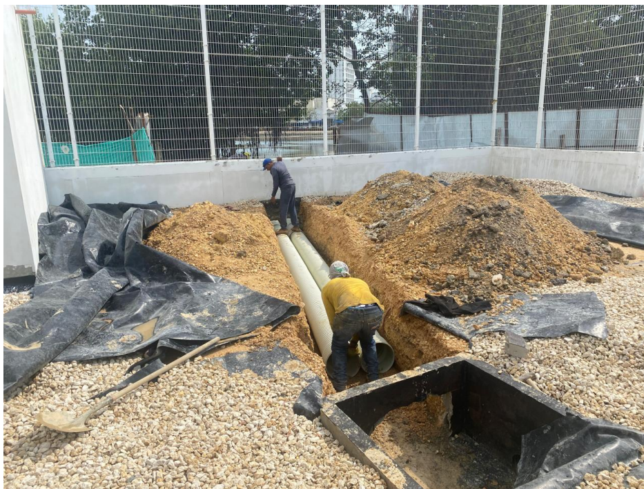
Ilustración 20. Instalación tubería y geomembrana drenaje cancha de futbol
