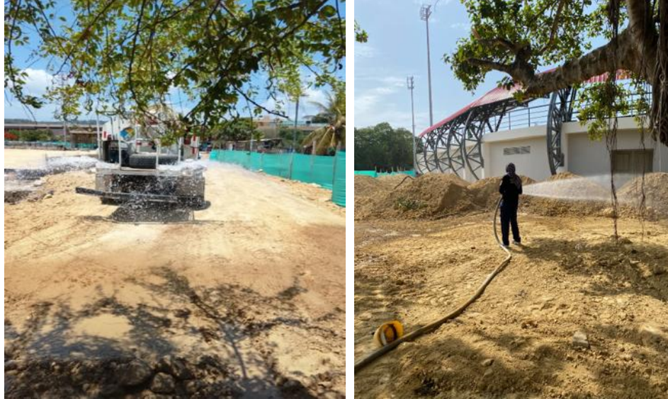
Ilustración 61. Riego de agua contra el polvo
