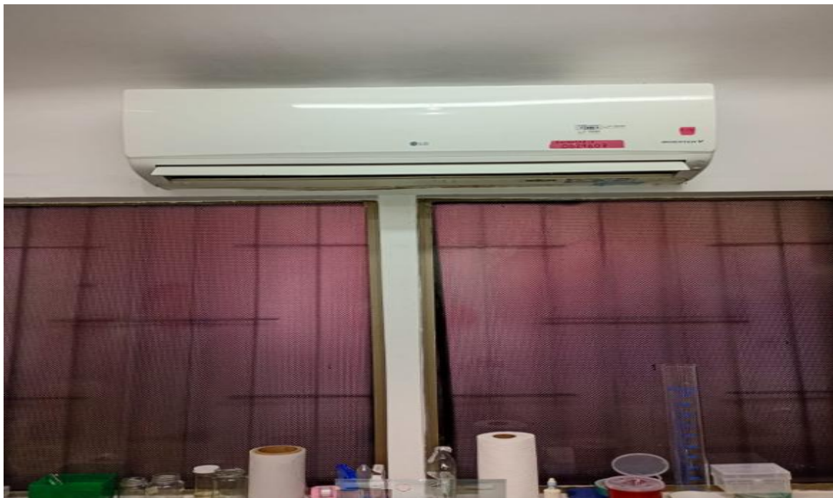
Imagen No. 3 Laboratorio de Diagnóstico Veterinario (Zona de Preparación de Medios), punto de referencia para desinstalar el aire antiguo e instalar aire nuevo en el mismo espacio.
