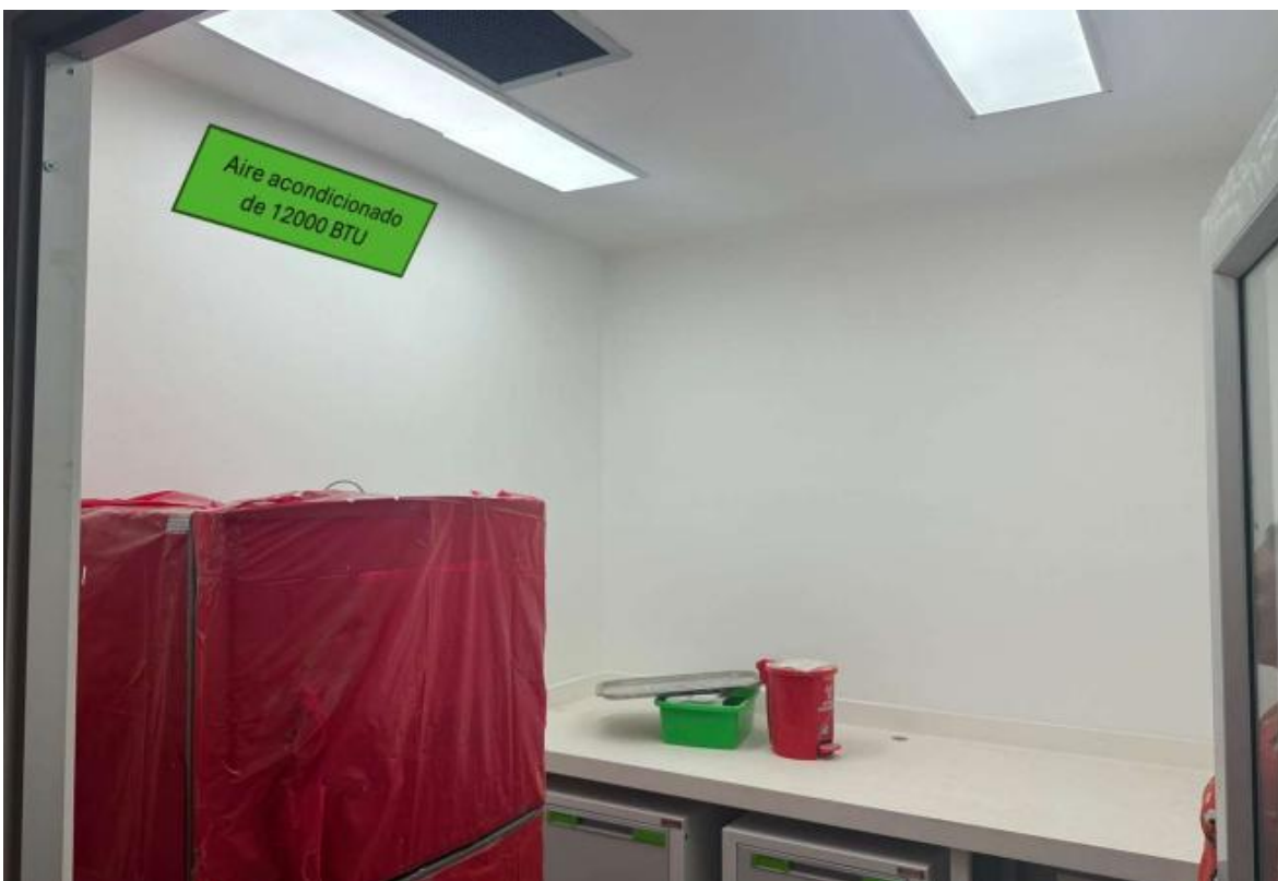
Imagen No. 6 Laboratorio Fitosanitario (Área de Lavado), punto de referencia para instalar el nuevo aire.
