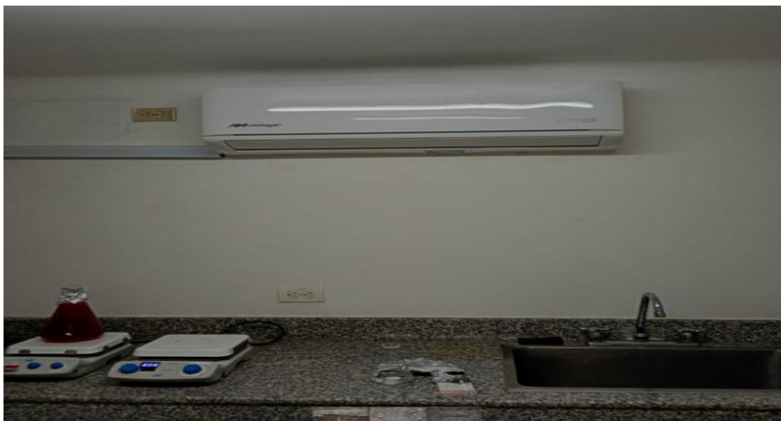
Imagen No. 4 Laboratorio de Diagnóstico Veterinario (Zona Área de Oficina 1), punto de referencia para desinstalar el aire antiguo e instalar el nuevo aire, en el centro de la oficina como se señala en la foto.
