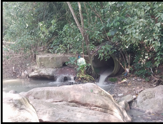
Fotos 1 y 2. Descargas de aguas residuales sin tratamiento previo a fuentes hídricas
