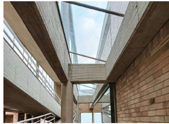
VISTA INFERIOR MARQUESINA PARALELA A RAMPA DE ACCESO
