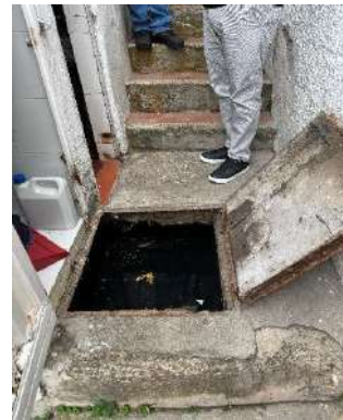
ACCESO AL CUARTO DE ASEO
