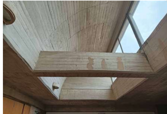
VISTA INTERIOR DE CUPÚLA
