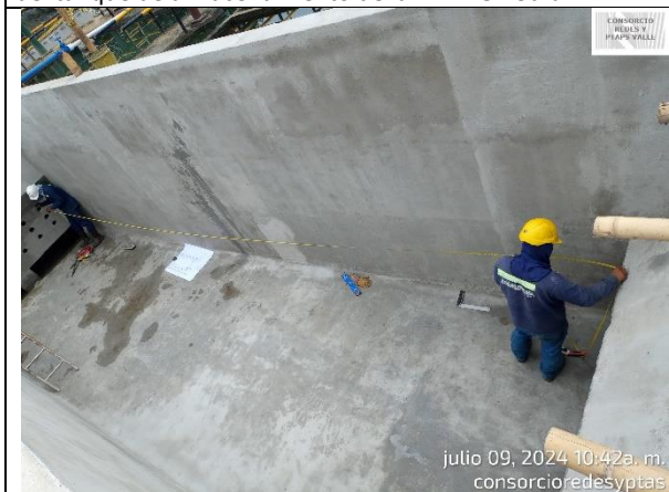
Fotografía 29. Verificación de ortogonalidad y perpendicularidad en el Sedimentador No. 3 de la PTAP Ginebra.
