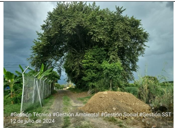
Fotografía 24. Suministro de material pétreo para las actividades realizadas en la PTAP Guacarí.
