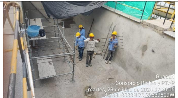
Fotografía 64. Instalación de acero de refuerzo de la pantalla No.1 del sedimentador No.1 de la PTAP Guacarí.
