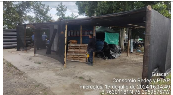
Fotografía 50. Construcción de campamento para acopio de materiales y herramientas en la PTAP Guacarí.
