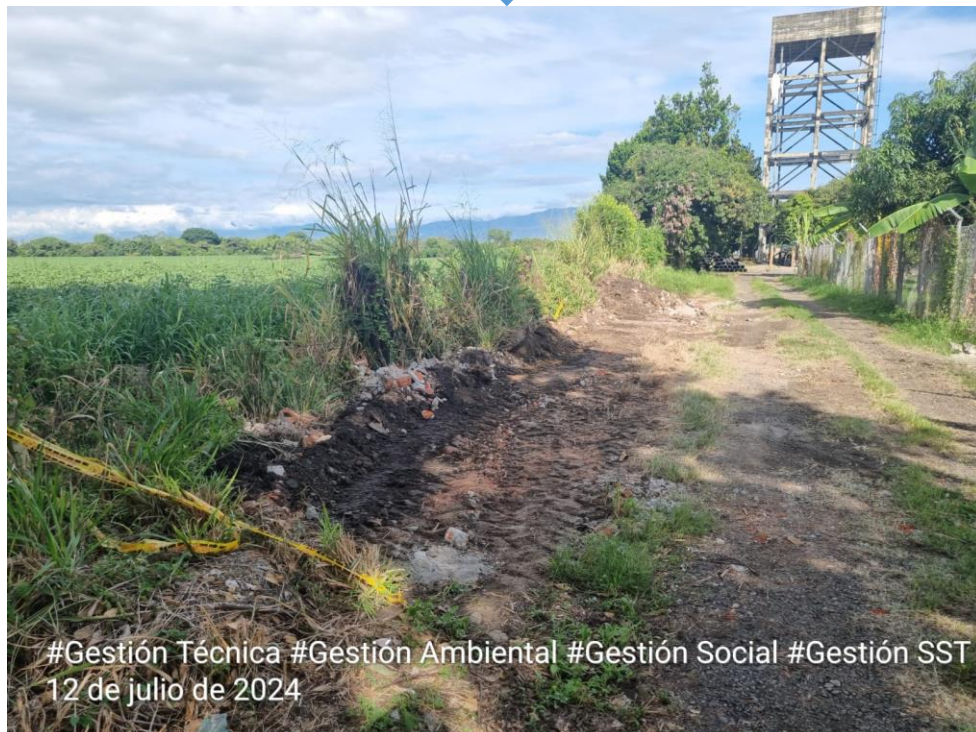
Ilustración 21 Manejo de Acopio de RCD en PTAP Guacaré
