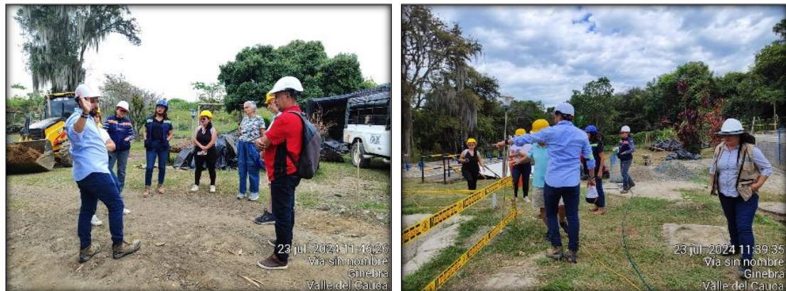
Ilustración 7. Recorrido de obra con el comité de veeduría en la PTAP Ginebra.
