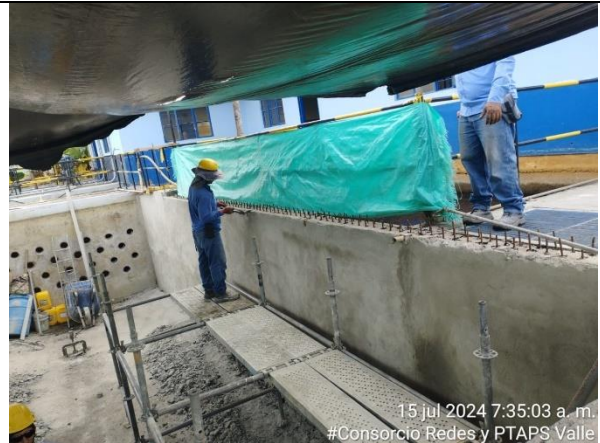
Fotografía 44. Instalación de acero de refuerzo anclados en muro de sedimentador No. 1 para realice en la PTAP Guacarí.
