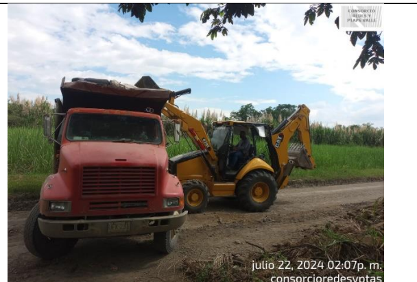
Fotografía 68. Cargue de material sobrante de las excavaciones
