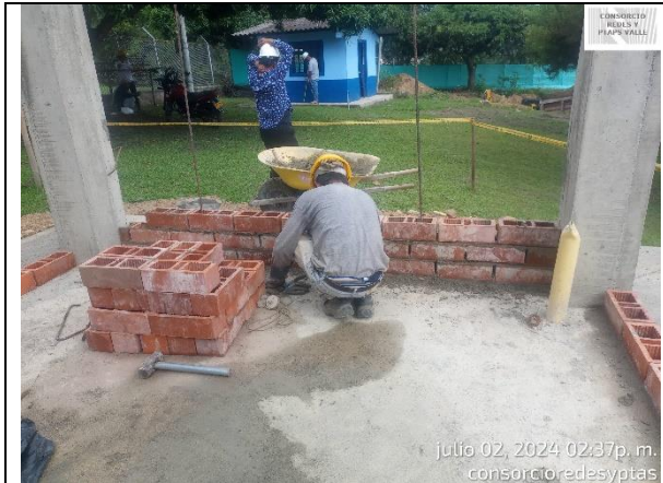
Fotografía 1 Instalación de bloque.
