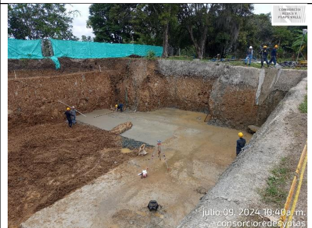
Fotografía 30. Fundición del solado de limpieza del tanque de almacenamiento de la PTAP Ginebra.
