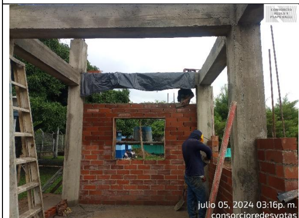
Fotografía 5. Instalación de bloque cerámico para la construcción de muros en Caseta eléctrica Ginebra.
