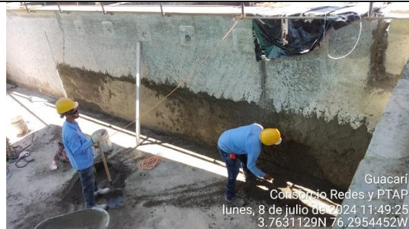
Fotografía 21. Repello con aditivos impermeabilizantes en el sedimentador No. 1 de la PTAP Guacarí.
