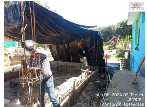
Fotografía 26. Construcción de la caseta de sopladores, se encofra la viga de cimentación.
