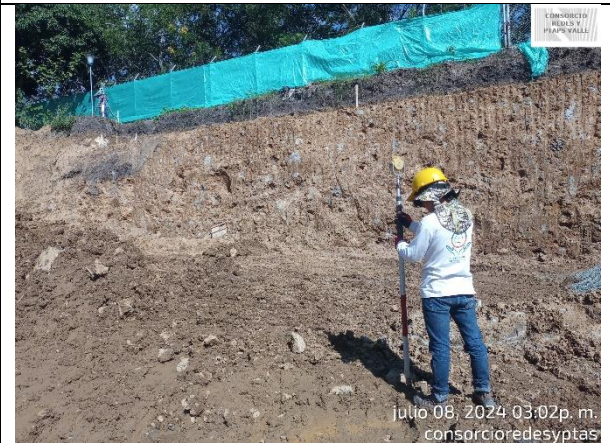
Fotografía 28. Chequeo de niveles para solado de limpieza.
