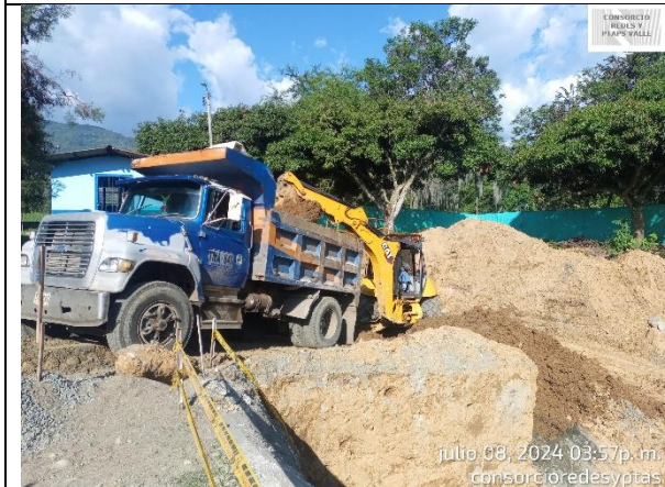
Fotografía 27. Retiro de material sobrante de la excavación del tanque de almacenamiento de la PTAP Ginebra.
