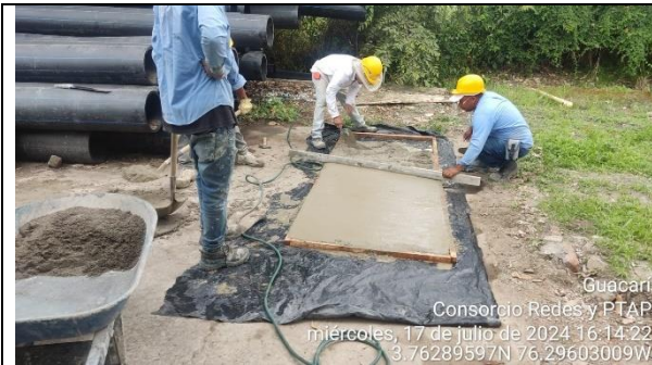
Fotografía 49. Construcción de paneles para utilizar garantizar los recubrimientos de los refuerzos en las estructuras fundidas.
