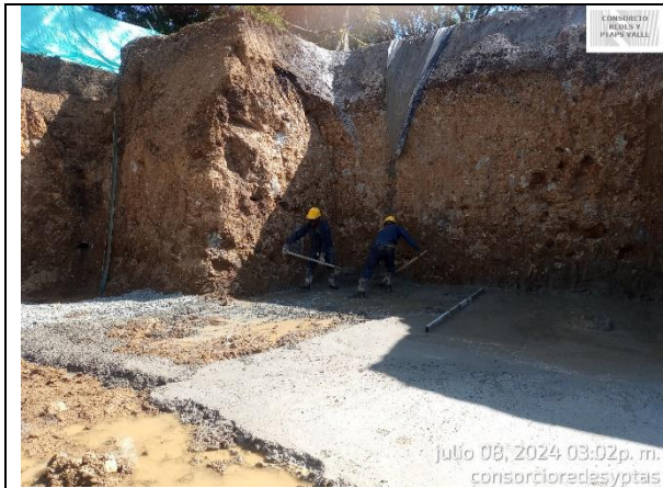
Fotografía 25. Fundición del solado de limpieza del tanque de almacenamiento de la PTAP Ginebra.
