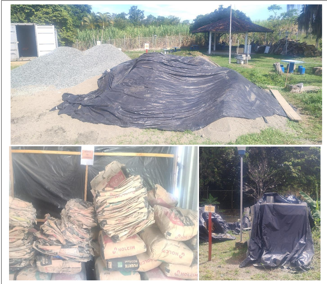
Ilustración 25 Acopio de Material Pétreo y de Construcción PTAP Ginebra
