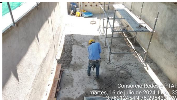
Fotografía 47. Actividad de escarificación de la losa inferior del sedimentador No.1 de la PTAP Guacarí.
