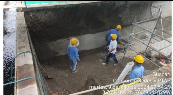
Fotografía 22. Repello con aditivos impermeabilizantes en el sedimentador No. 1 de la PTAP Guacarí.
