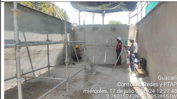
Fotografía 51. Escarificación de la losa inferior del sedimentador No. 1 de la PTAP Guacarí.
