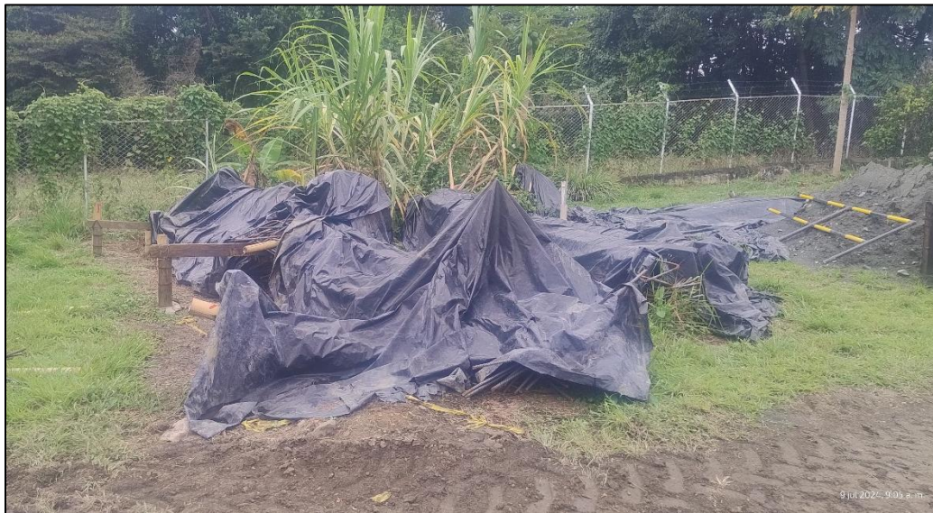
Ilustración 24 Acopio de Material Acero PTAP Ginebra
