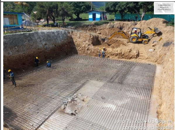
Fotografía 45. Instalación de acero de refuerzo para construcción del tanque de almacenamiento de la PTAP Ginebra.
