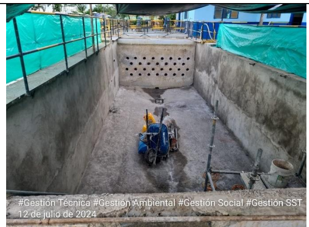
Fotografía 20. Actividad de Escarificación de la losa inferior del sedimentador No. 1 de la PTAP Guacarí.
