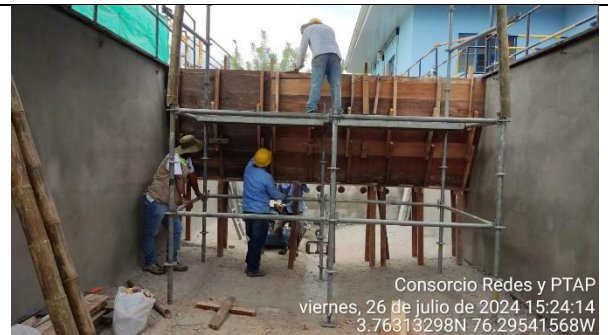
Fotografía 66. Encofrado y apuntalamiento de la pantalla No.1 del sedimentador No.1 de la PTAP Guacarí.
