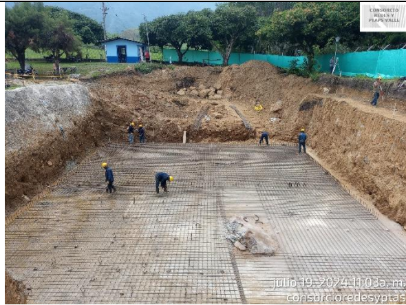
Fotografía 43. Instalación de acero de refuerzo losa tanque de almacenamiento de la PTAP Ginebra.
