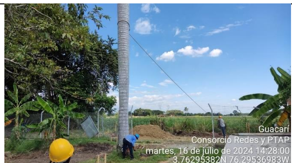
Fotografía 48. Se retira palma seca que se encuentra interfiriendo con las actividades de construcción de la caseta eléctrica.
