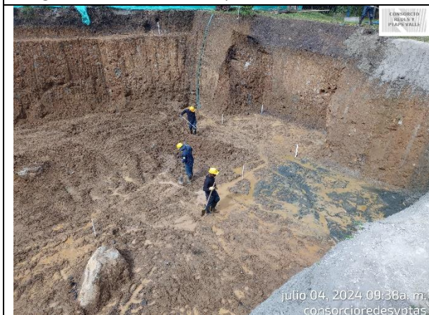
Fotografía 3. Verificación de niveles de excavación
