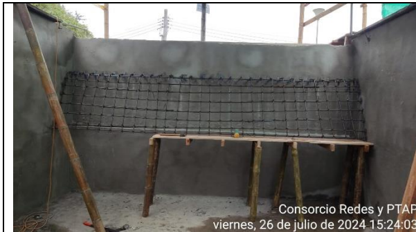
Fotografía 63. Instalación de acero de refuerzo de la panta No. 2 del sedimentador No. 1 de la PTAP Guacarí.
