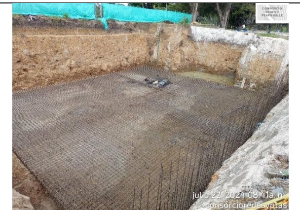
Fotografía 54. Instalación de acero de refuerzo tanque de almacenamiento de la PTAP Ginebra.
