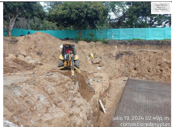
Fotografía 46. Excavación de la caja de entrada del tanque de almacenamiento de la PTAP Ginebra.
