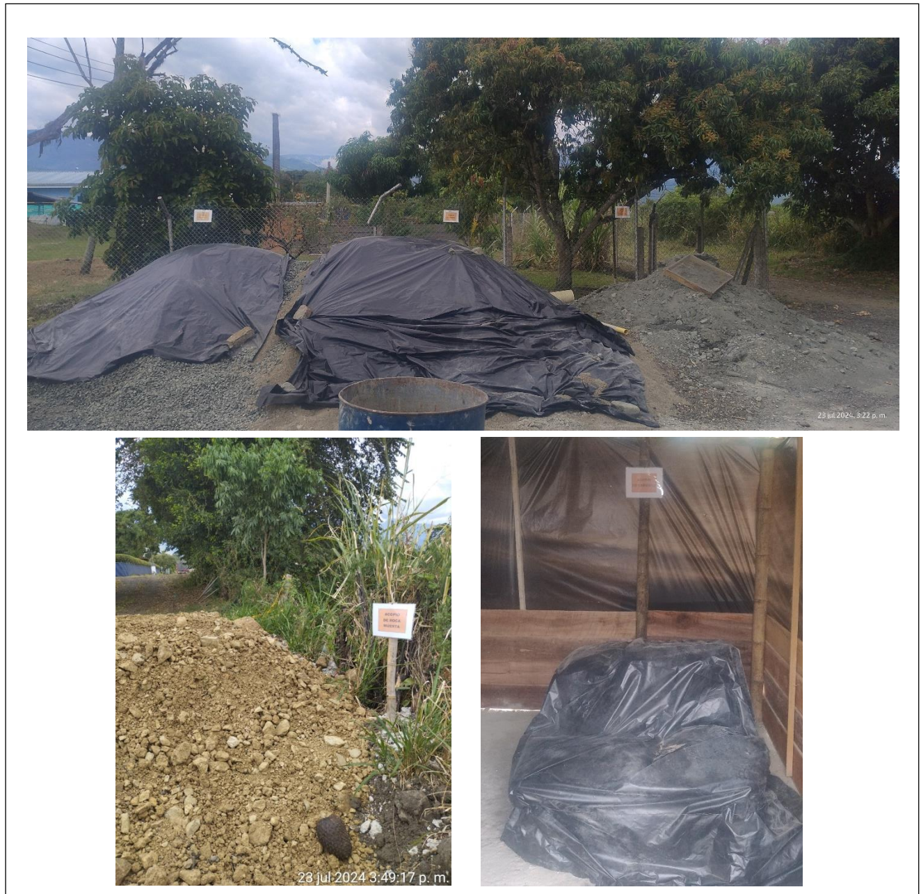
Ilustración 26 Acopio de Material Pétreo y de Construcción PTAP Guacarí
