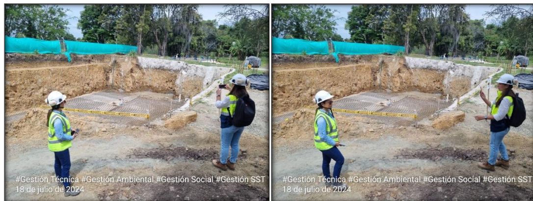
Ilustración 5. Visita Técnica por parte de las Asesoras de Holcim para suministro de hormigón.
