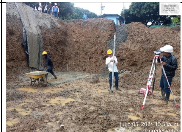
Fotografía 6. Chequeo de niveles para solado de limpieza, por el mal estado de la subrasante del tanque, se requiere remplazo de material por un material filtrante.
