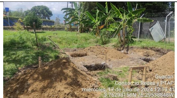
Fotografía 52. Excavación para la zapatas de la caseta eléctrica de la PTAP Guacarí.
