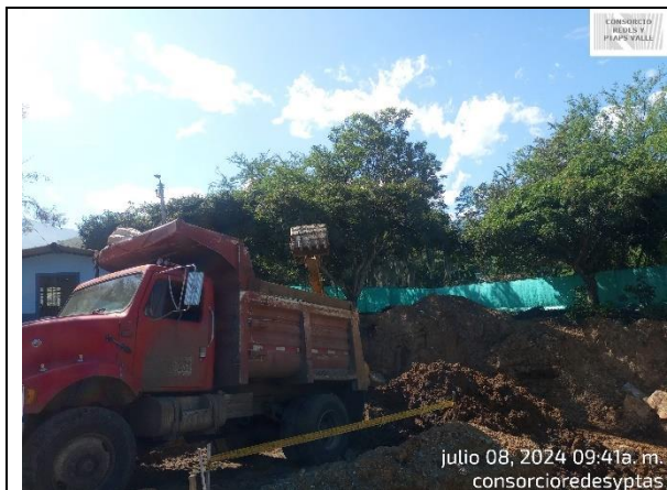
Fotografía 19. Retiro de material sobrante de la excavación del tanque de almacenamiento de la PTAP Ginebra.
