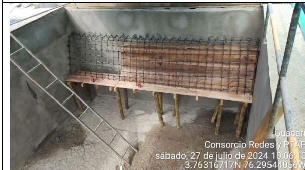
Fotografía 65. Encofrado de la pantalla No.1 del sedimentador No. 1 de la PTAP Guacarí.
