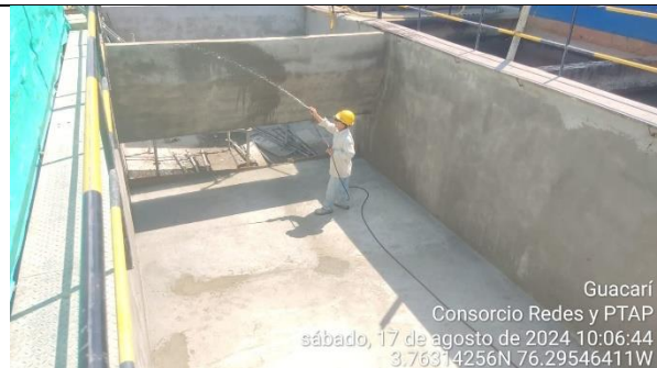
Fotografía 34. Limpieza en la losa de fondo del Tanque de Ginebra.
