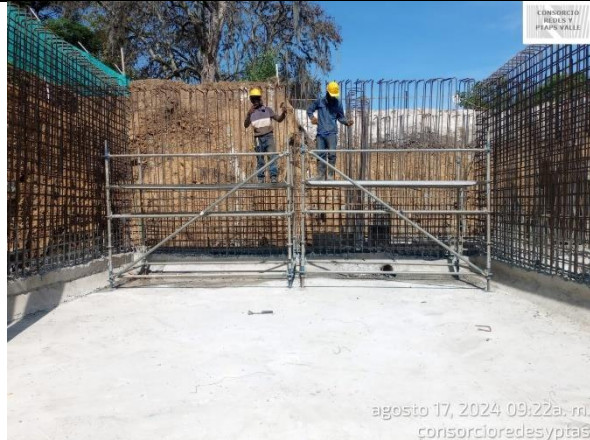
Fotografía 33. Instalación de acero de refuerzo para los muros del tanque de Ginebra.
