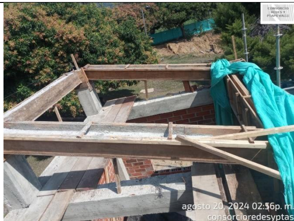
Fotografía 35. Fundición de la cinta y viga canal de la caseta eléctrica de la PTAP Ginebra.
