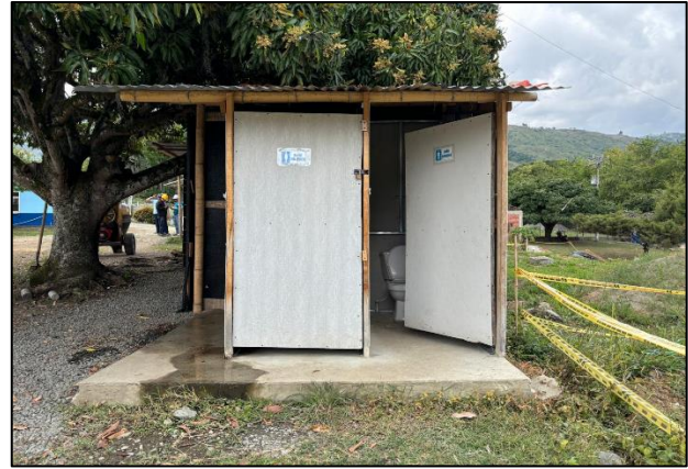
Foto 2. Baños – PTAP Ginebra
