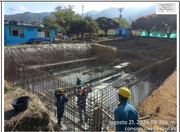
Fotografía 44. Instalación de Andamios para la instalación de acero de refuerzo en muros del tanque Ginebra.
