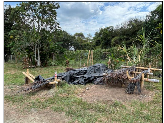
Foto 4. Acopio Materiales de Construcción
