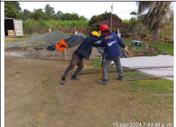
Fotografía 10. Figurado de acero de refuerzo para muros del tanque Ginebra.
