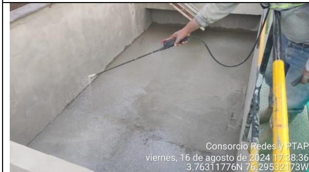
Fotografía 23. Aplicación de Antisol en la losa del sedimentador No.1 de la PTAP Guacarí.
