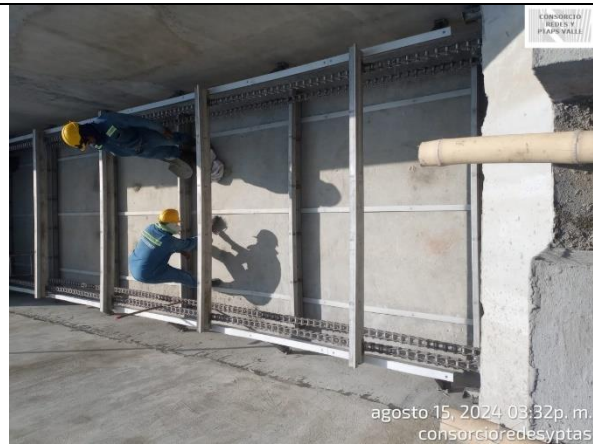
Fotografía 13. Instalación de Cadenas y traviesas para construcción de Barrelos.
