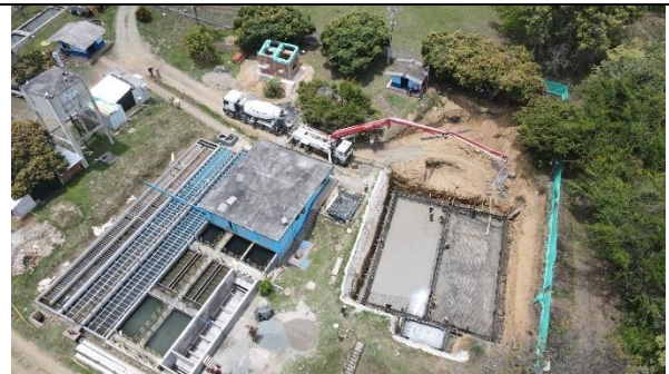
Fotografía 20. Foto Aérea de la fundición de la losa inferior del tanque de almacenamiento de la PTAP Ginebra.
