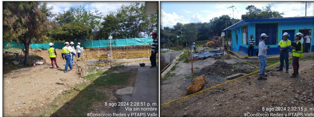
Ilustración 8. Visita Técnica por parte de las Asesoras de Holcim para suministro de hormigón.
