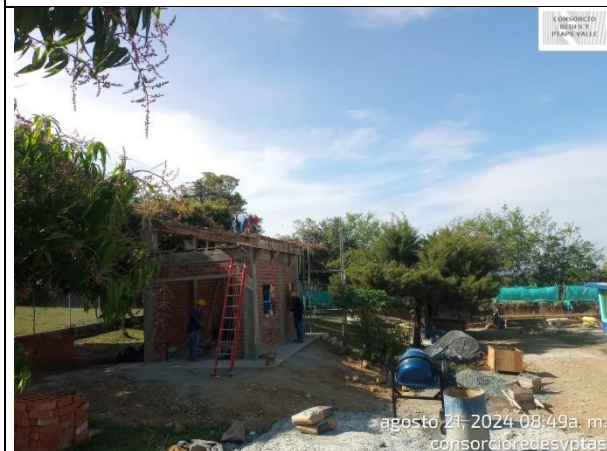
Fotografía 45. Construcción de viga canal y cinta de la caseta eléctrica de la PTAP Ginebra.
