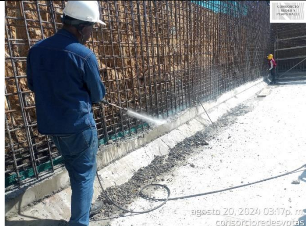
Fotografía 34. Limpieza en la losa de fondo del Tanque de Ginebra.
