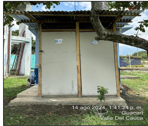
Foto 8. Baños – PTAP Guacarí
