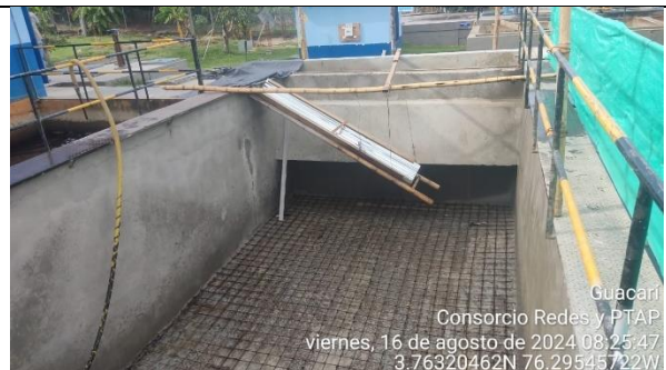
Fotografía 16. Instalación de acero de refuerzo de la losa inferior del sedimentador No.1 de la PTAP Guacarí.
