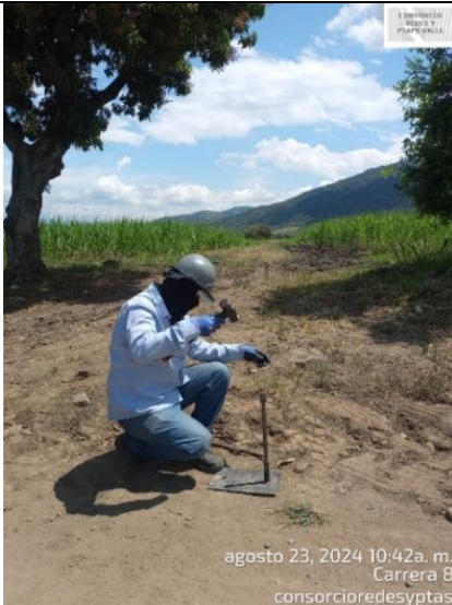
Fotografía 69. Toma de densidades tramo 3, k3+340-k5+240
