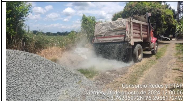
Fotografía 21. Suministro de Triturado de 3/8 para grouting en la losa del sedimentador No.1 del PTAP Guacarí.
