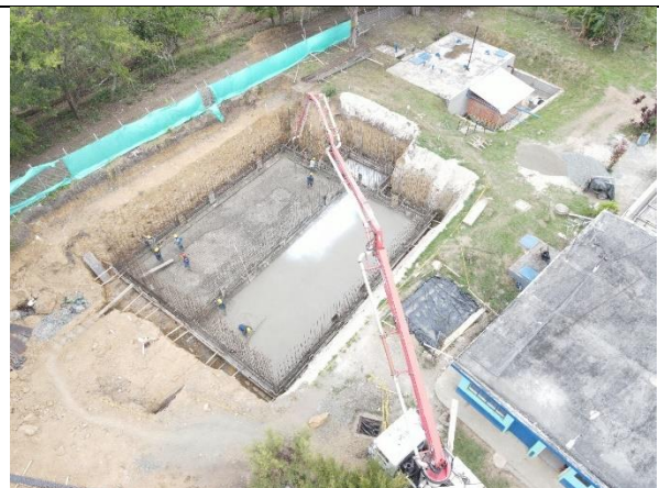
Fotografía 18. Foto Aérea de la fundición de la losa inferior del tanque de almacenamiento de la PTAP Ginebra.
