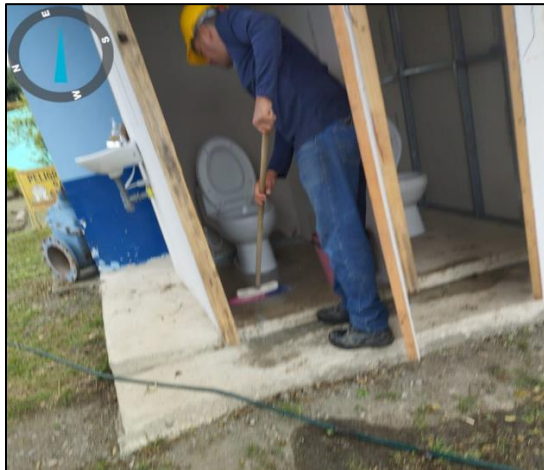
Foto 9. Mantenimiento Baños – PTAP Guacarí
