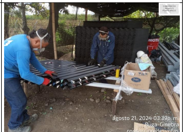
Fotografía 48. Armando los módulos de sedimentación para luego instalarlas en el sedimentador No.3 de la PTAP Ginebra.
