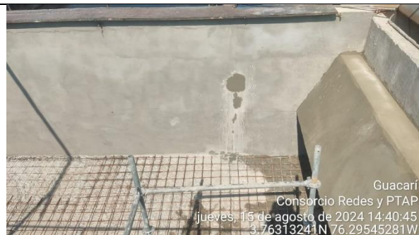
Fotografía 15 Instalación de acero de refuerzo de la losa inferior del sedimentador No.1 de la PTAP Guacarí.
