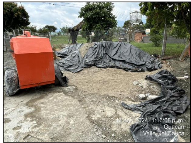
Foto 10. Acopio Materiales de Construcción
