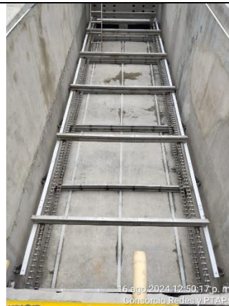
Fotografía 26. Se finaliza con la instalación de la estructura inferior del barrelados en la PTAP Ginebra.
