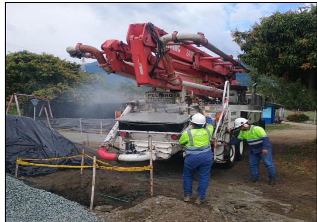
Foto 6. Sitio para lavado de canaletas
