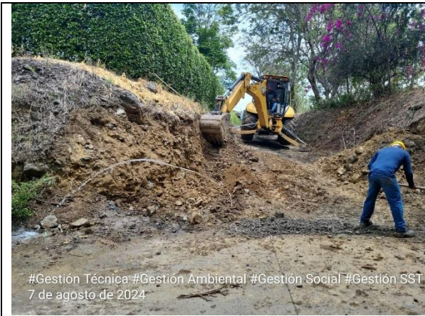
Fotografía 7. Excavación para ampliación de acceso a la planta Ginebra.
