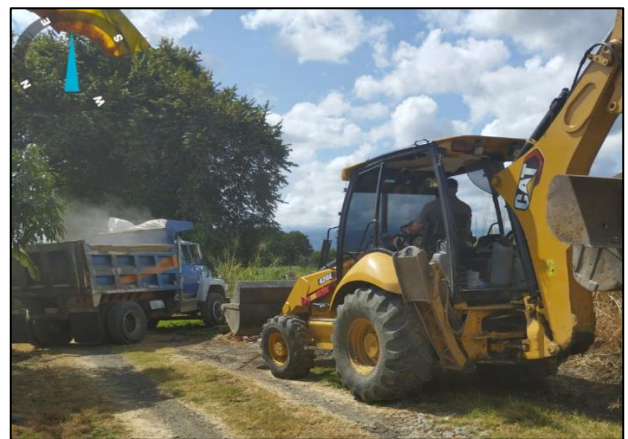
Foto 12. Retiro de material para botadero
