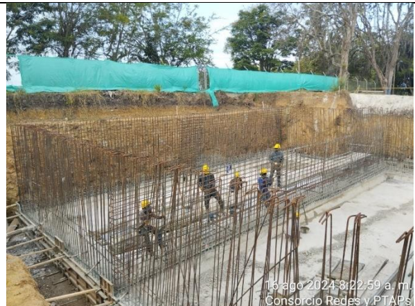
Fotografía 28. Continúan Instalando el acero de refuerzo de los muros del tanque de la PTAP Ginebra.
