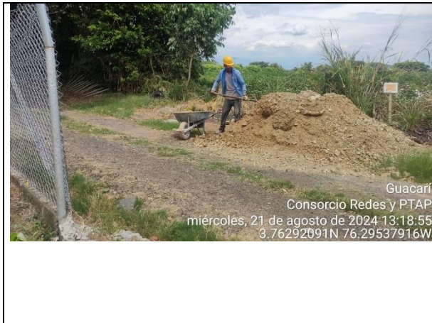
Fotografía 43. Relleno para las cimentaciones de la caseta eléctrica de la PTAP Guacarí.
