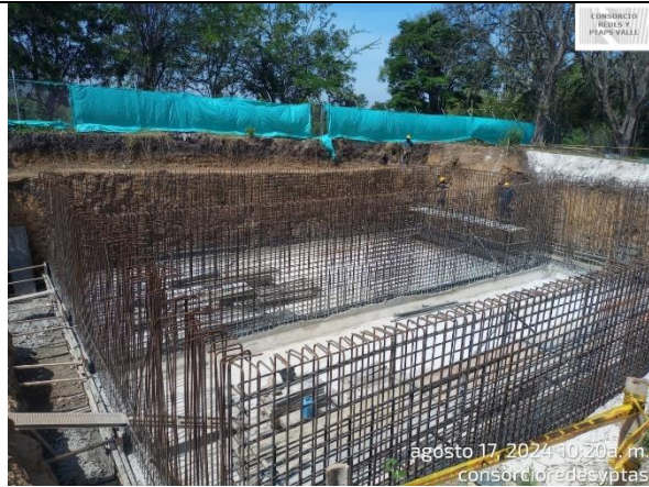
Fotografía 31. Instalación de acero de refuerzo en los muros del tanque de Ginebra.
