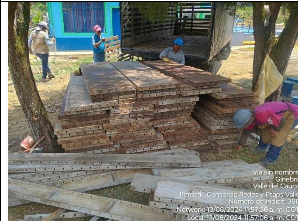
Fotografía 9. Suministro de formaleta metálica para construcción de tanque Ginebra.
