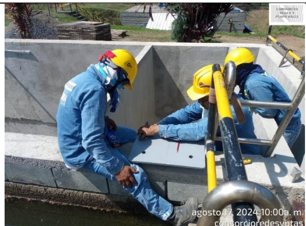
Fotografía 30. Instalación de Plataforma para motor del barrelados del Sedimentador No. 3 de la PTAP Ginebra.
