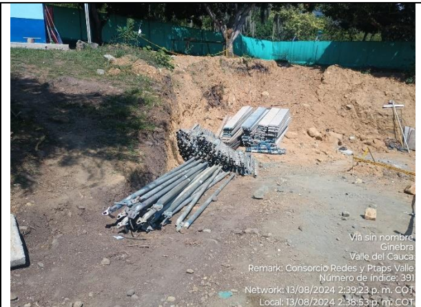
Fotografía 8. Suministro de Andamios para construcción de Tanque Ginebra.
