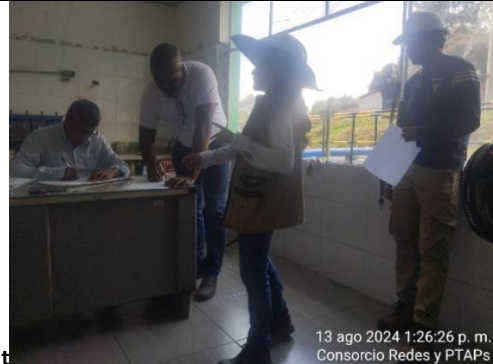
Fotografía 66. Revisión de casetas eléctricas con el ing. Rafael Ocoró de ACUAVALLE
