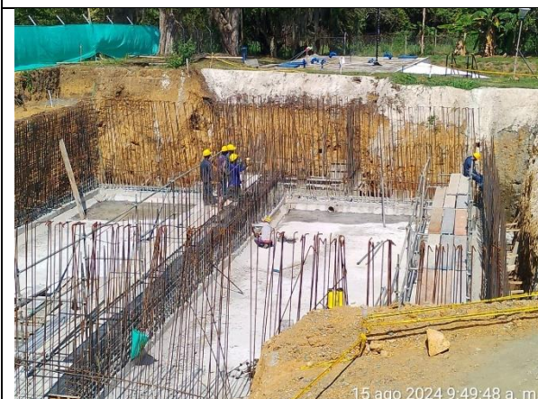
Fotografía 11. Instalación de acero de refuerzo de los muros para construcción de tanque Ginebra.
