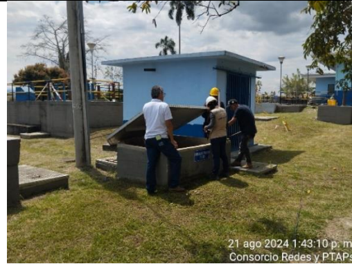
Fotografía 68. Levantamiento cámaras de Filtros
