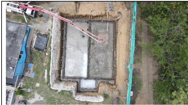
Fotografía 19. Foto Aérea de la fundición de la losa inferior del tanque de almacenamiento de la PTAP Ginebra.
