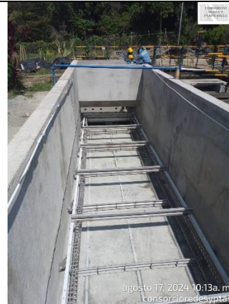
Fotografía 32 Se finaliza con la instalación de la estructura inferior del barrelados en la PTAP Ginebra.
