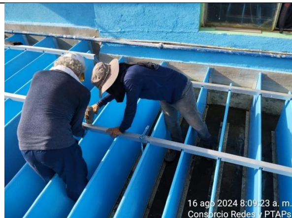
Fotografía 29. Instalación de placas del Floculador en la PTAP Ginebra.
