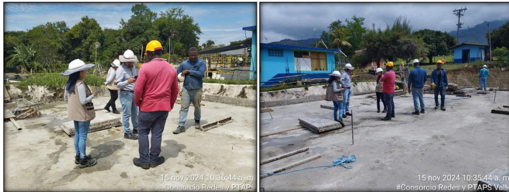
Ilustración 16. Visita técnica con personal subcontratista del Tanque de almacenamiento de agua potable de la PTAP Ginebra.
