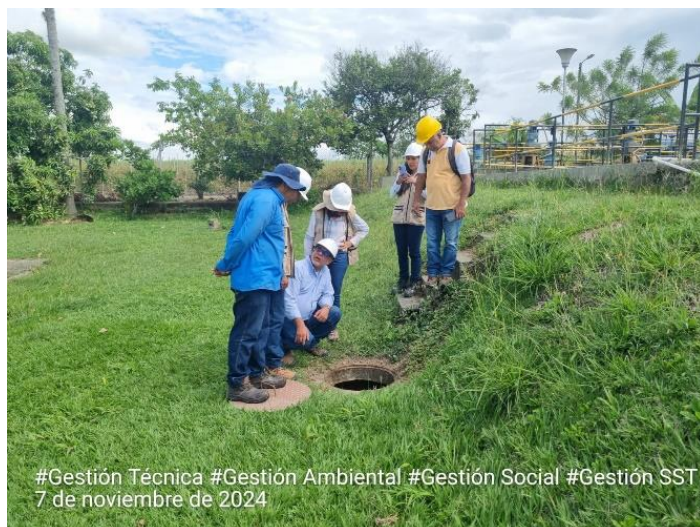
Ilustración 24 Recorrido funcionario Secretaría infraestructura Guacarí
