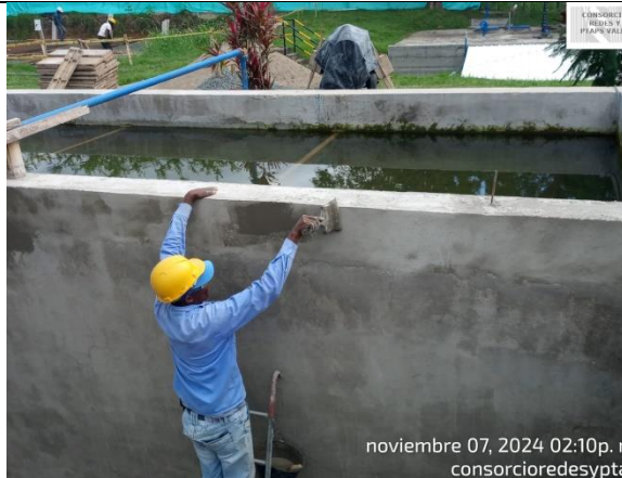
Fotografía 5. Impermeabilización de los repellos con Productos Sika en el Sedimentador No.2 en la PTAP Ginebra
