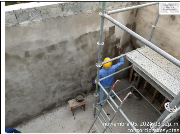
Fotografía 9. aplicación de impermeabilizante en los muros internos del sedimentador No. 2 de la PTAP Ginebra.
