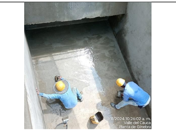
Fotografía 8. Impermeabilización de la losa inferior del sedimentador No. 2 en la PTAP Ginebra.
