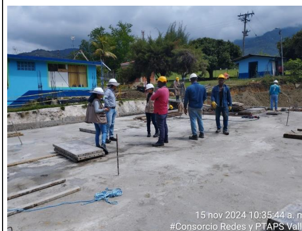
Fotografía 49. Chequeo de acabados en la losa superior del tanque de almacenamiento de la PTAP Ginebra.
