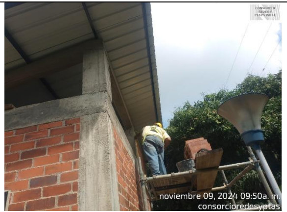
Fotografía 10. Finalizan con la construcción de la caseta eléctrica de la PTAP Ginebra (Obra civil).
