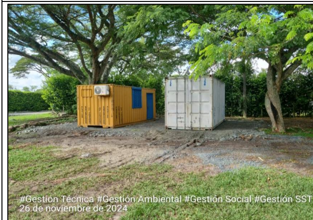
Foto 11. Adecuación de Campamento – Tanque Albania
