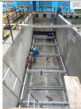
Fotografía 12. Inicia con el ensamblaje del barrelos en el sedimentador de la PTAP Ginebra.
