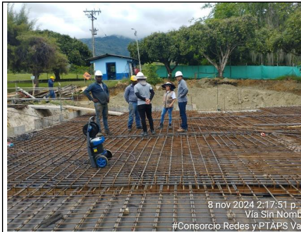
Fotografía 45. Chequeo y liberación de acero de refuerzo con interventoría de losa superior tanque PTAP Ginebra.
