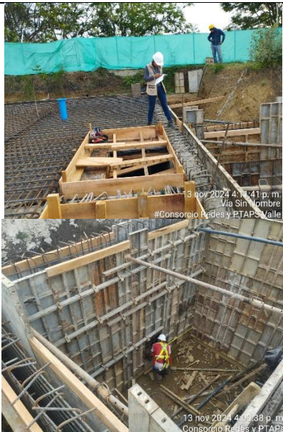
Fotografía 65. Verificación de los niveles y la ubicación de las tuberías de salida de Villa Vanegas y la Floresta
