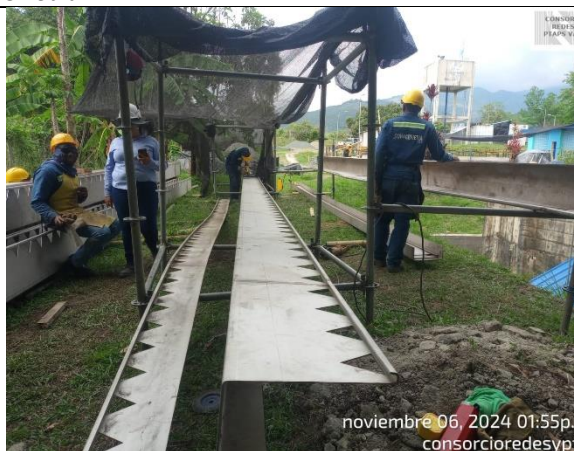
Fotografía 7. Construcción y ensamblaje de canaletas para los sedimentadores en la PTAP Ginebra.
