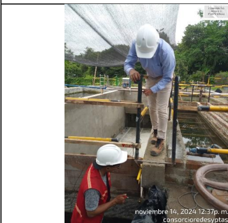
Fotografía 13. Chuequeo de cotas en canales de ingreso y salida del sedimentador No. 2 de la PTAP Ginebra.
