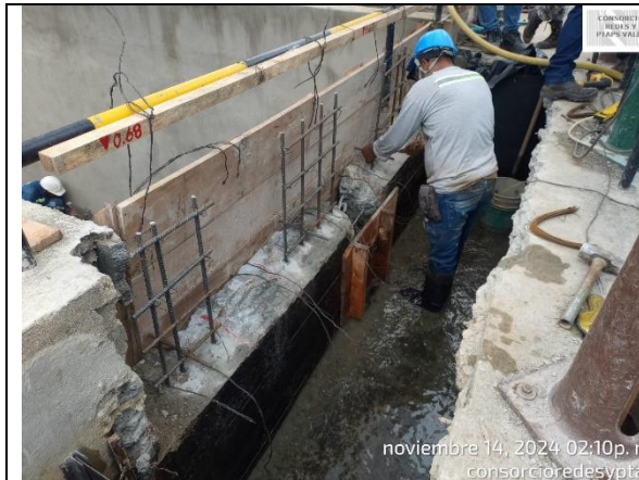
Fotografía 3. Construcción de realce de muro en el sedimentador No. 2 en la PTAP Ginebra.
