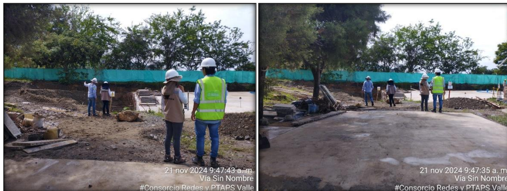
Ilustración 17. Visita técnica en los frentes de obra con asesor de Seguros Mundial.
