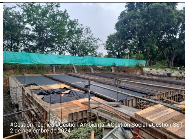
Fotografía 14. Finalizan con la instalación de casetones y obra falsa para la construcción de la losa superior del tanque de almacenamiento.
