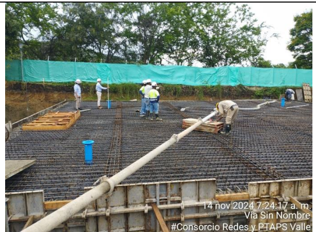
Fotografía 46. Chequeo y liberación de niveles y pasamuros con interventoría losa superior tanque PTAP Ginebra.
