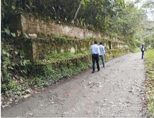
Fotografía 63. Recorrido en el tramo 1 para identificar los puntos críticos del trazado de la tubería para chequear la piezométrica y las presiones
