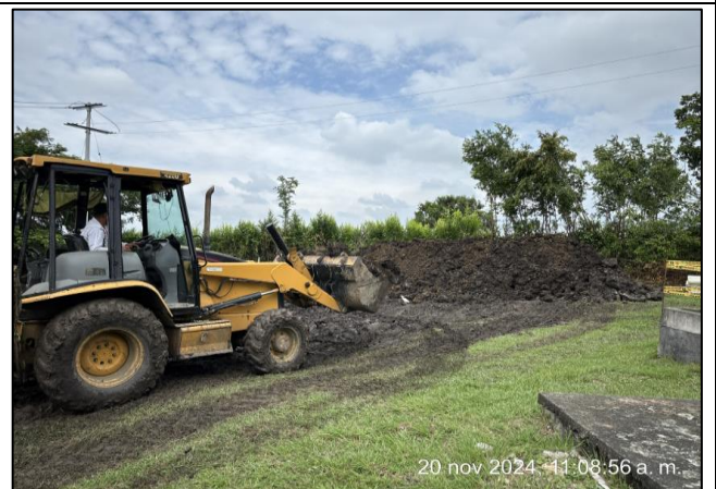
Foto 12. Acopio Material de Excavación – Tanque Albania
