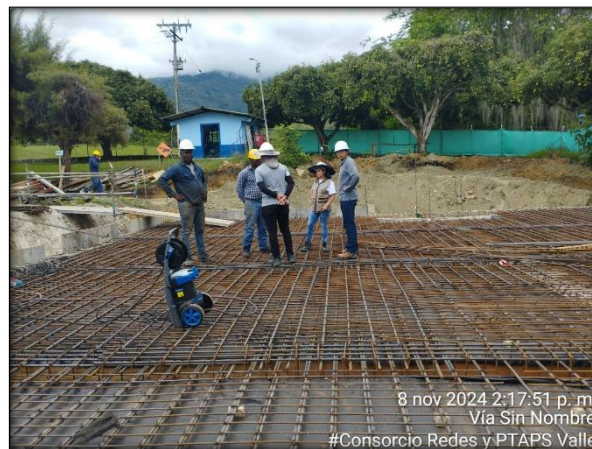
Ilustración 13. Visita técnica en Tanque de almacenamiento de agua potable de la PTAP Ginebra.
