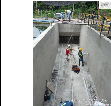
Fotografía 11. Chequeo de Plomos y ortogonalidad de los muros y piso del sedimentador No. 2 de la PTAP Ginebra.
