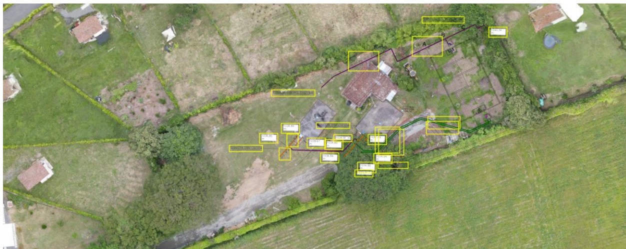
Ilustración 3. Replanteo del tanque de Almacenamiento en el predio de Acuavalle en el sector villa Jhons.
