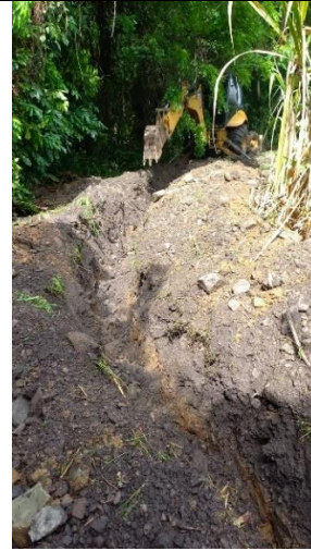
Fotografía 64. Actividades para instalación de tubería de 2" para conexión domiciliar de la hacienda La Victoria
