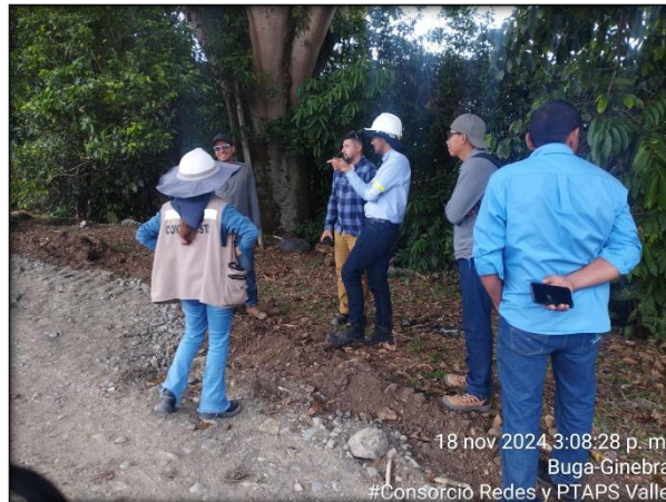
Ilustración 14. Recorrido al nuevo frente de obra de la construcción del tanque de la Albania.
