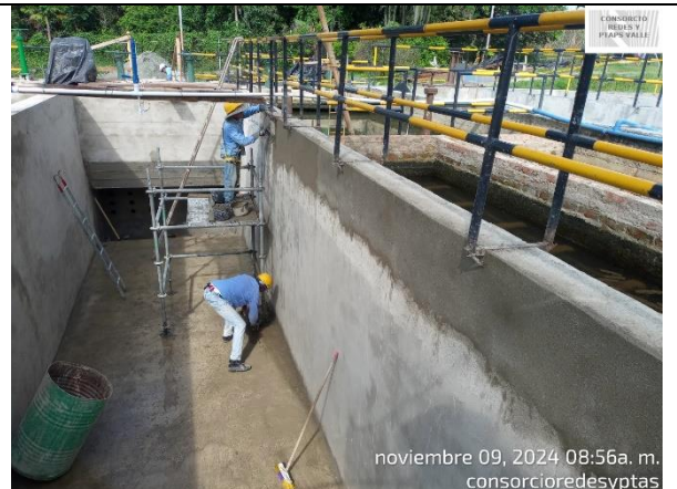
Fotografía 4. Repello del realce del muro del sedimentador No. 2 en la PTAP Ginebra.
