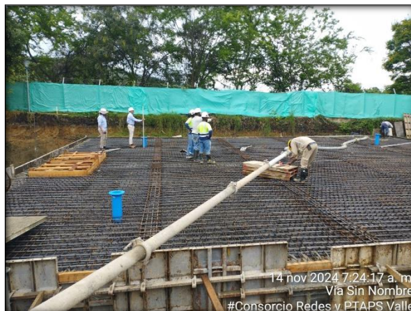
Ilustración 15. Visita técnica por parte de Asesores Holcim en Tanque de almacenamiento de agua potable de la PTAP Ginebra.
