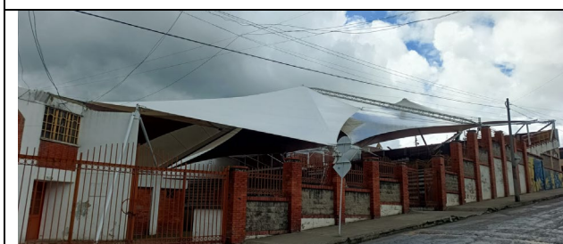
MEMBRANA INSTALADA SECTOR 3
