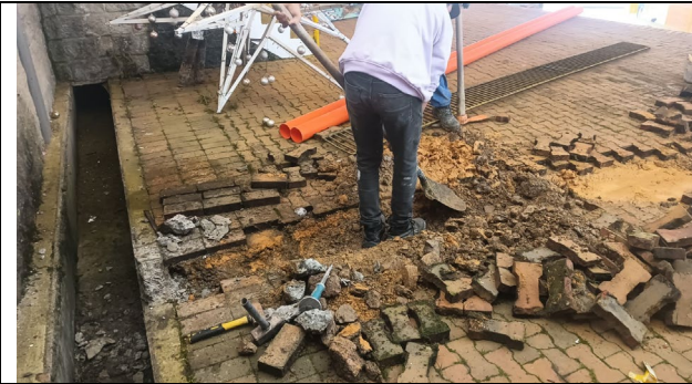
DESMONTE ADOQUIN PARA RED DE AGUAS LLUVIAS
