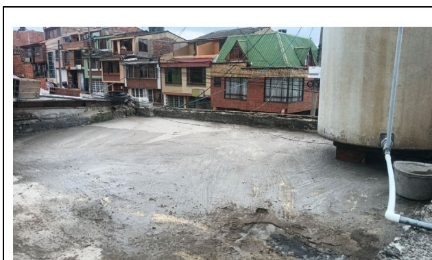
ALISTADO TERRAZA PARA IMPERMEABILIZAR
