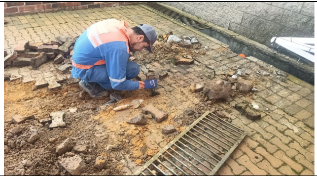
REINSTALACION ADOQUIN RED AGUAS LLUVIAS
