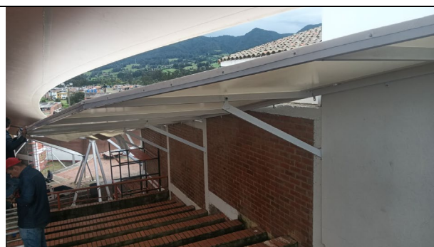
MEMBRANA INSTALADA SECTOR 1
