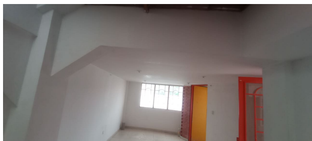
PINTURA AULAS SEGUNDO NIVEL
