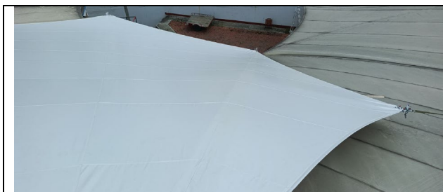
MEMBRANA INSTALADA SECTOR 3
