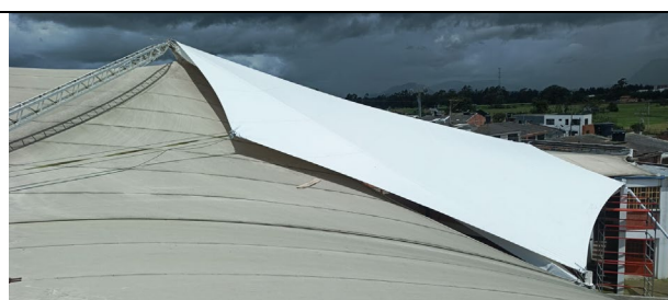
MEMBRANA INSTALADA SECTOR 3
