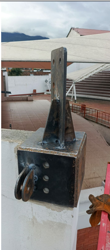
PLATINAS ANCLAJE MEMBRABNA SECTOR 3
