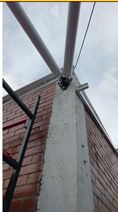
ANCLAJES PARA ESTRUCTURA CUBIERTA
