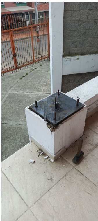
PLATINAS ANCLAJE MEMBRABNA SECTOR 3
