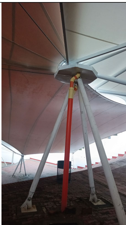
SISTEMA RECOLECCION AGUAS LLUVIAS
