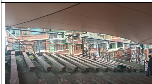
ESTRUCTURA SOPORTE MEMBRANA SECTOR 4
