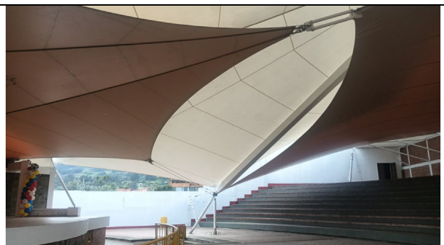
MEMBRANA INSTALADA SECTOR 3
