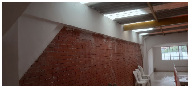
PINTURA PASILLO SEGUNDO NIVEL
