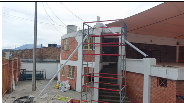
ESTRUCTURA APOYO MEMBRANA SECTOR 3
