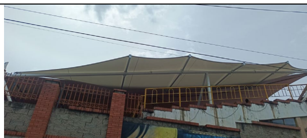
MEMBRANA INSTALADA SECTOR 4
