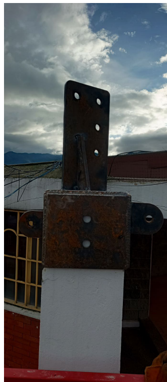
PLATINAS ANCLAJE MEMBRABNA SECTOR 3
