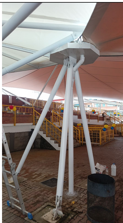
SISTEMA RECOLECCION AGUAS LLUVIAS
