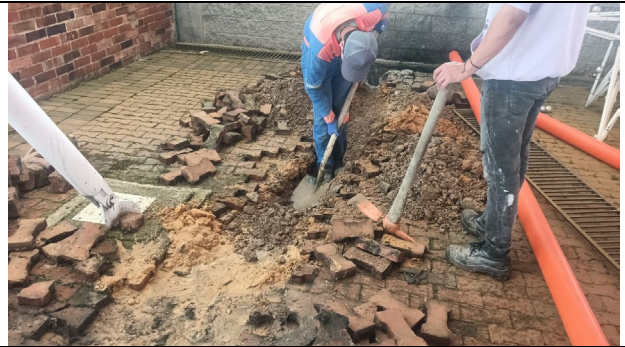
EXCAVACION PARA RED AGUAS LLUVIAS
