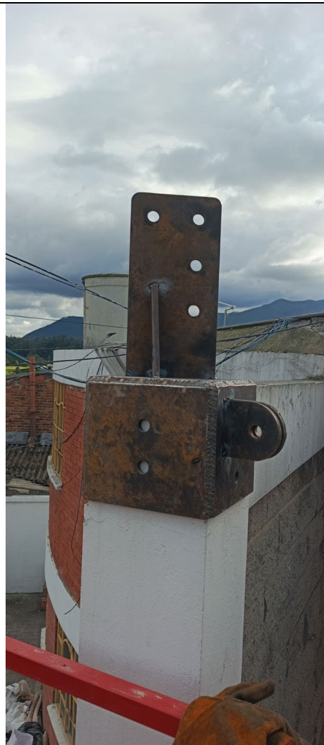
PLATINAS ANCLAJE MEMBRABNA SECTOR 3
