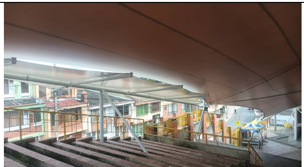
MEMBRANA INSTALADA SECTOR 4
