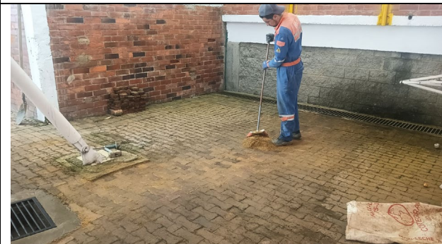
REINSTALACION ADOQUIN RED AGUAS LLUVIAS
