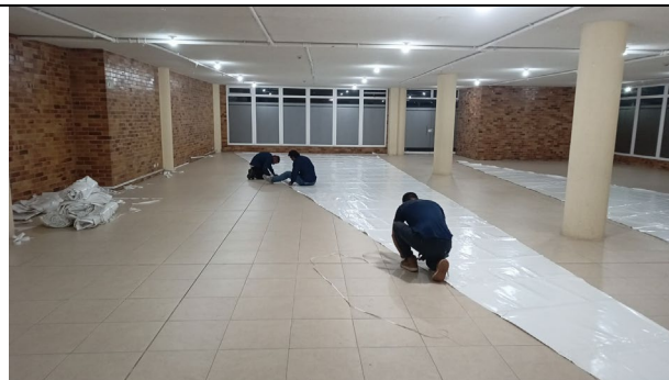
CORTE Y CONFECCION MEMBRANAS
