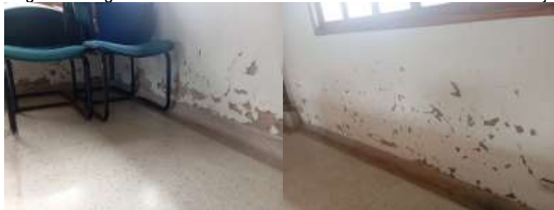
Figura 5. Registro Fotográfico condiciones actuales de las instalaciones del Concejo Municipal
