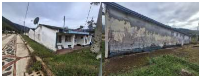
Figura 4. Registro Fotográfico condiciones actuales de las instalaciones antiguas de la ESE
