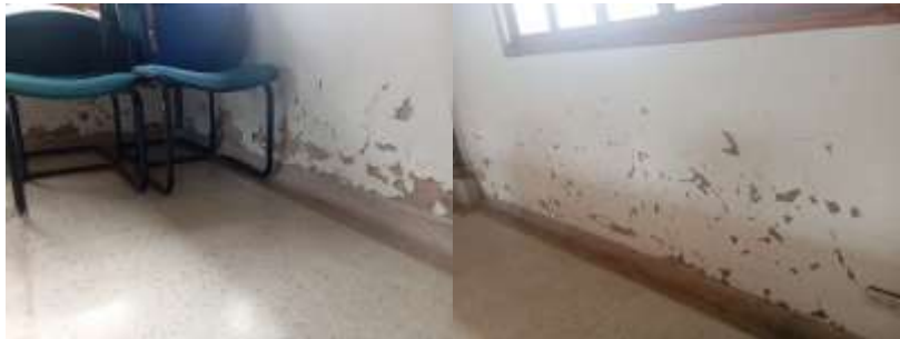
Figura 5. Registro Fotográfico condiciones actuales de las instalaciones del Concejo Municipal
