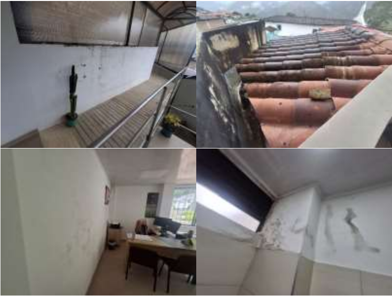
Figura 2. Registro Fotográfico condiciones actuales de las instalaciones del Palacio Municipal.
