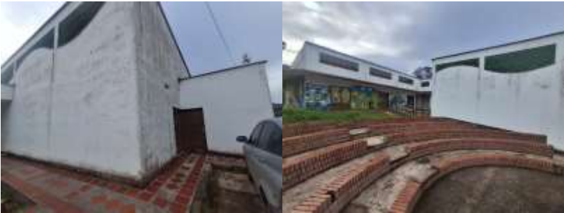
Figura 3. Registro Fotográfico condiciones actuales de la Casa de la Cultura
