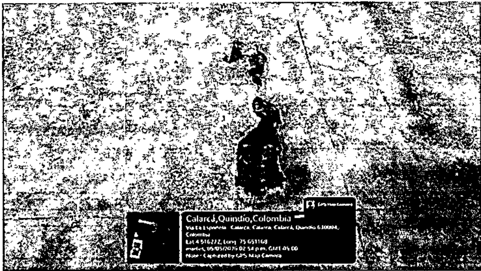
Foto 3. Recubrimiento superficial se encuentra completamente desprendido, dejando expuesto el mortero de nivelación.
