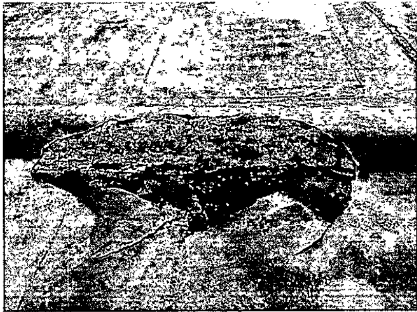
Foto 3. Recubrimiento superficial se encuentra completamente desprendido, dejando expuesto el mortero de nivelación.
