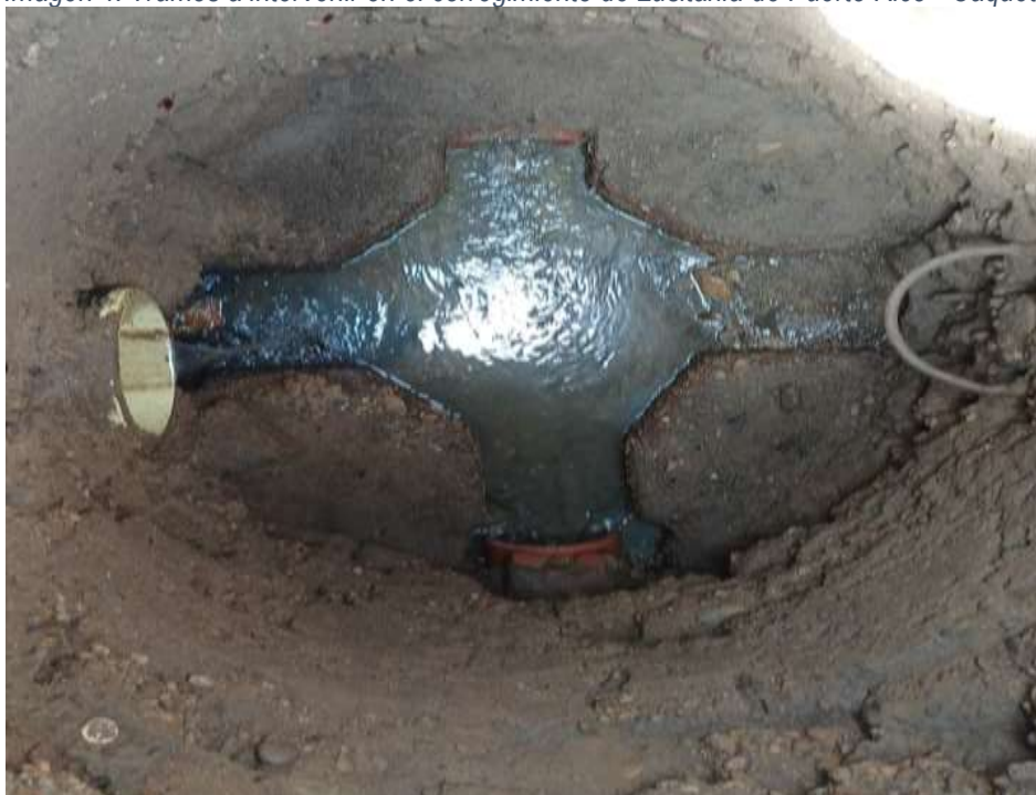
Imagen 4. Tramos a intervenir en el corregimiento de Lusitania de Puerto Rico - Caquetá
