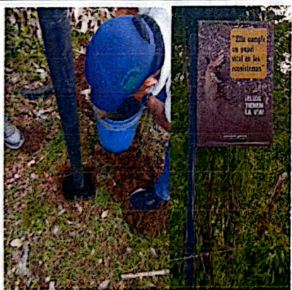
Anexo 6.2. Evidencia fotográfica sobre la instalación de los 6 avisos metálicos tipo bandera (90 cm x 50 cm), con tubo galvanizado de 2.5 metros de las subregiones de CarSucre.
