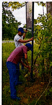
Anexo 6.2. Evidencia fotográfica sobre la instalación de los 6 avisos metálicos tipo bandera (90 cm x 50 cm), con tubo galvanizado de 2.5 metros de las subregiones de CarSucre.
