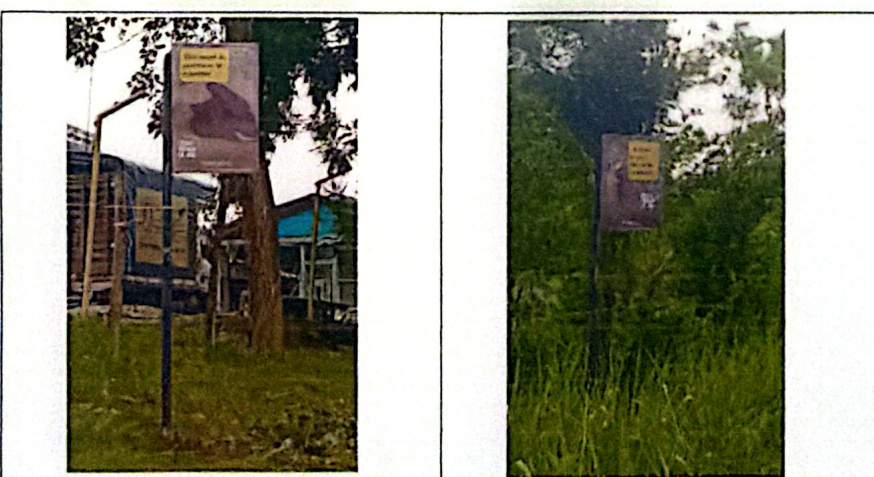
Imagen 6.4. Instalación de (02) vallas "Baja la velocidad, Ellos tienen la vía" en el predio de El Gallinero, en el municipio de Sincelejo, subregión Montes de María.
