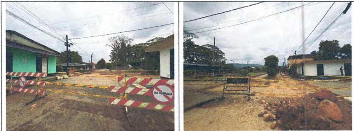
Señalización y aislamientos
