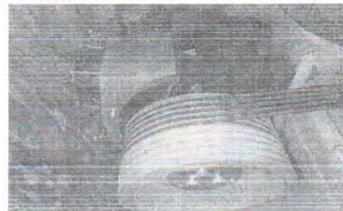
Foto 4. Polea de traccion no tiene guardacables.
