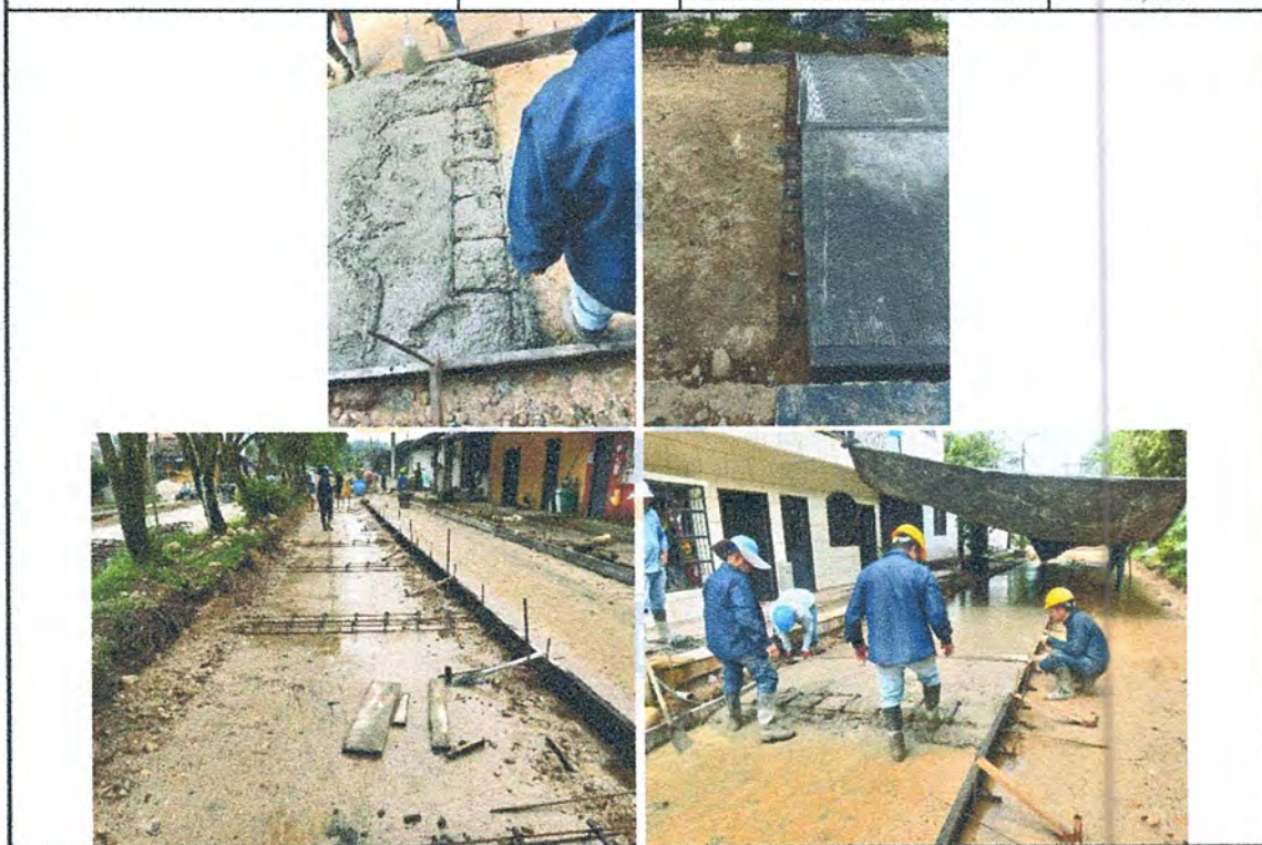
CANASTILLAS EN ACERO DE REFUERZO FY= 37.000 PSI
