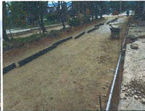
SUMINISTRO, EXTENDIDA Y COMPACTACIÓN DE BASE GRANULAR CLASE B
