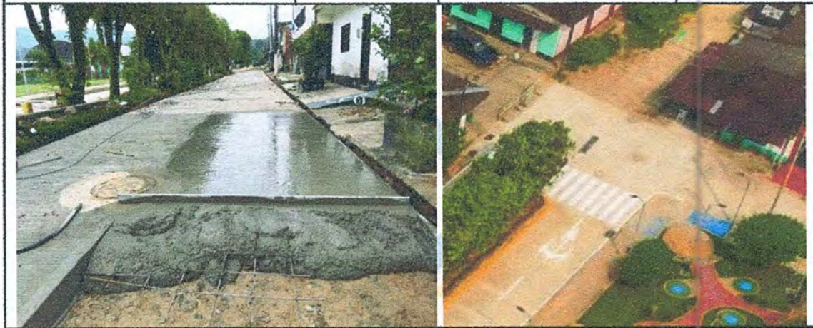
ADECUACIÓN Y ELEVACIÓN DE POZO DE INSPECCIÓN (INCLUYE MARCO Y TAPA)
