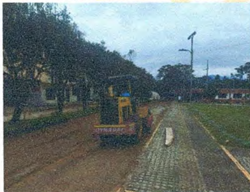
SUMINISTRO, EXTENDIDA Y COMPACTACIÓN DE BASE GRANULAR CLASE B
