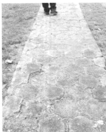
Fotografía 8. Sendero Adoquín en Concreto Fuente: Registro SEDAMA
