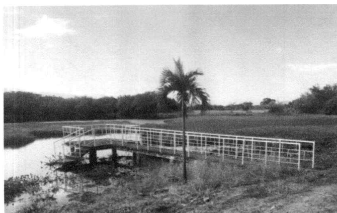
Fotografía 14. Muelle existente Fuente: Registro SEDAMA
