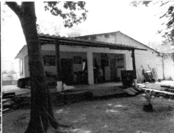
Fotografía 2. Casa existente acceso al parque Fuente: Registro SEDAMA
