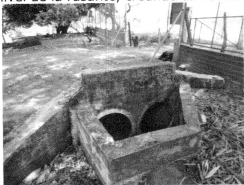
Fotografía 26. Obra de drenaje en la vía de acceso – cabezal de entrada. Fuente: Registro SEDAMA
