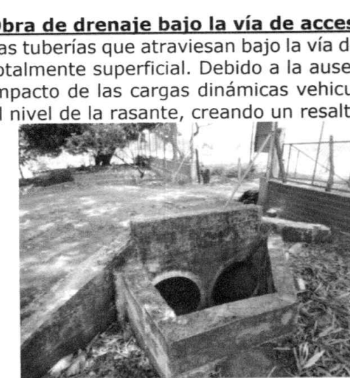
Fotografía 26. Obra de drenaje en la vía de acceso – cabezal de entrada. Fuente: Registro SEDAMA
