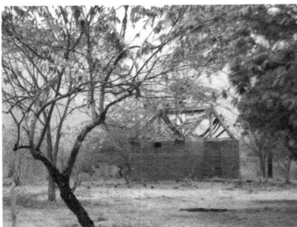
Fotografía 3. Estructura existente Fuente: Registro SEDAMA
