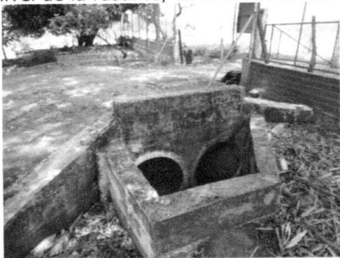
Fotografía 26. Obra de drenaje en la vía de acceso – cabezal de entrada. Fuente: Registro SEDAMA
