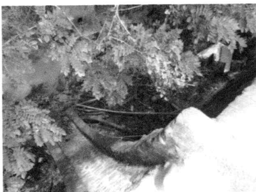
Fotografía 24. Vertedero y estado del cauce aguas abajo del dique – vista desde la cresta Fuente: Registro SEDAMA
