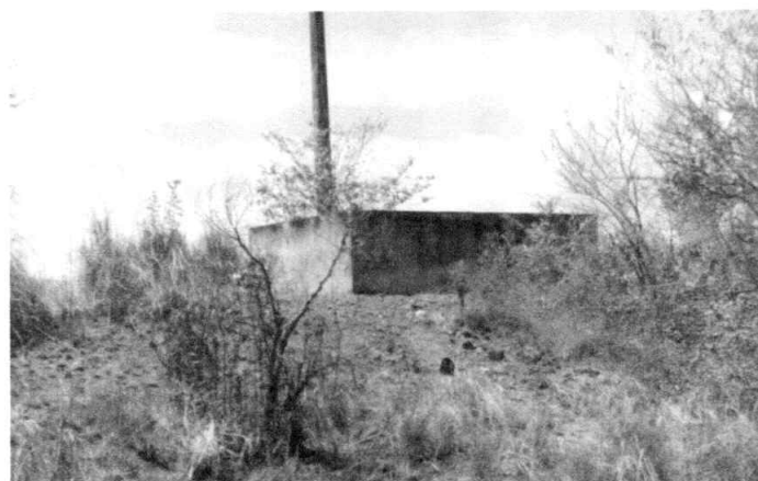
Fotografía 5. Tanque existente cercano a la laguna Ibis Fuente: Registro SEDAMA
