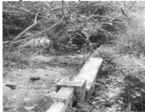
Fotografía 29. Estado actual del cerramiento. Fuente: Registro SEDAMA
