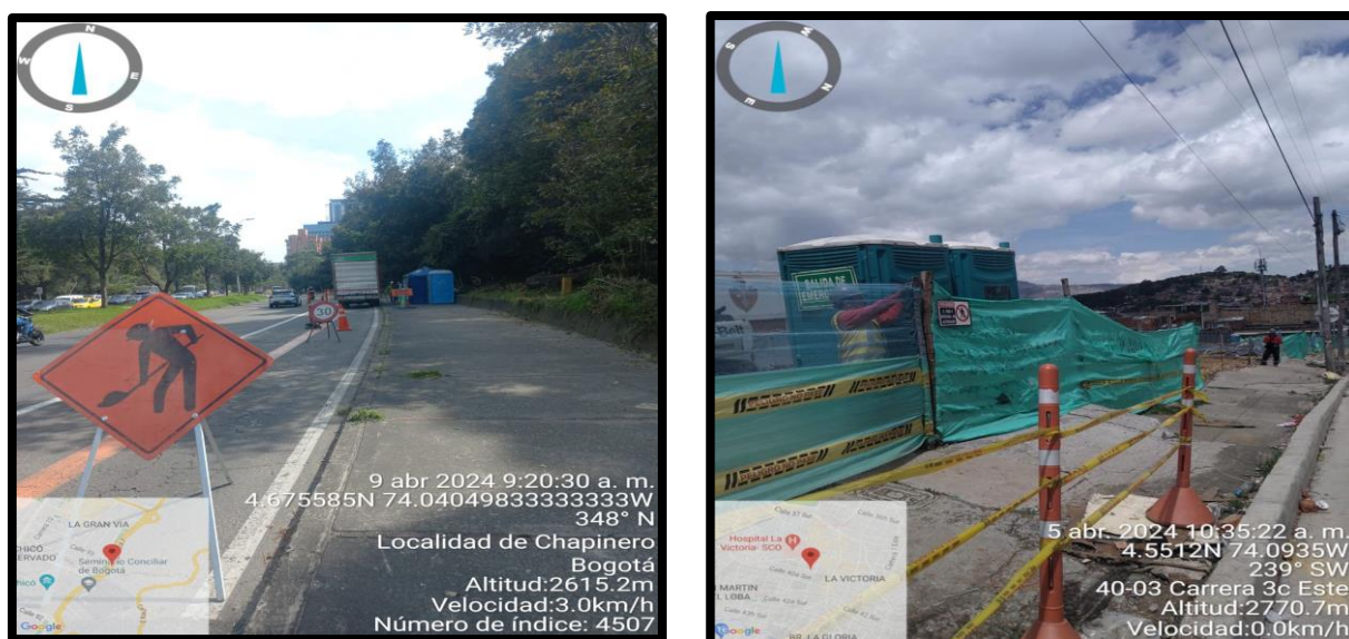
Ilustración 53 y 54 Cerramiento y señalización
