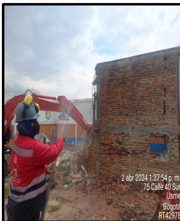
Ilustración 21 Humectación para minimizar impacto por material particulado
