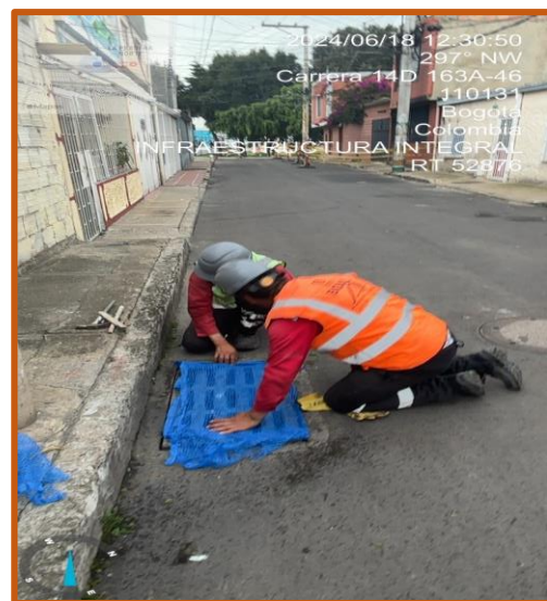
Ilustración 13 y 14 Protección de sumideros RT 52876A
