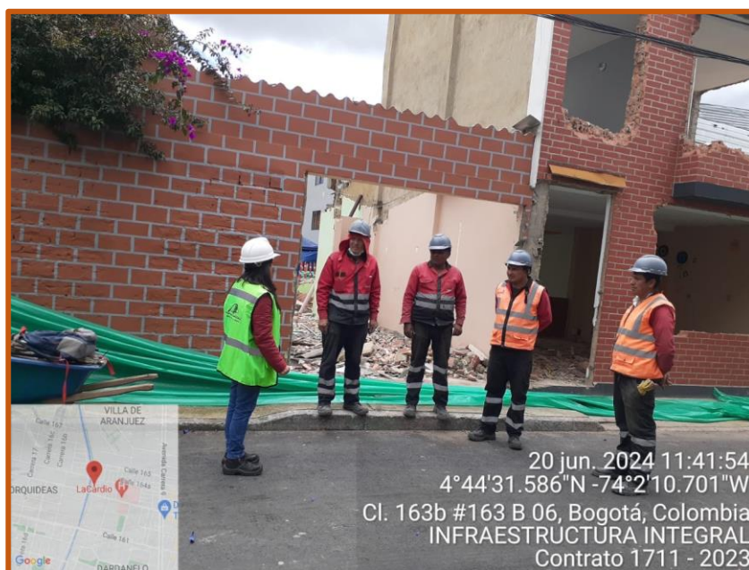
Ilustración 24 – Capacitación FAUNA SILVESTRE en actividades de demolición
