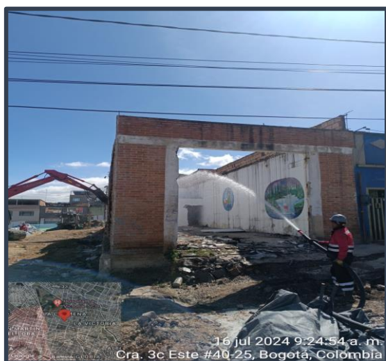
Ilustración 19 y 20 Actividad de Humectación en frentes de trabajo de demolición.
