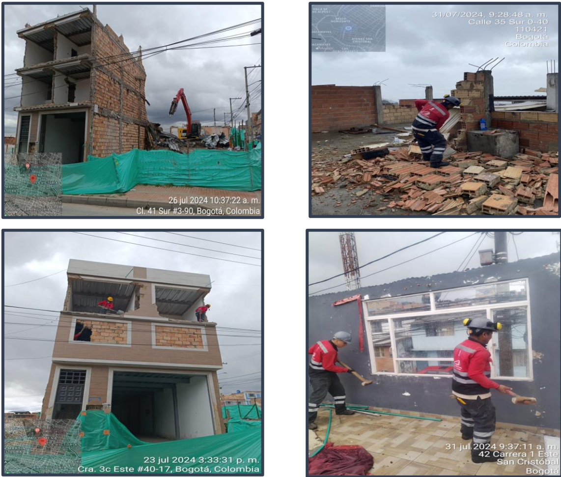
Ilustración 7 - 10 Registro Fotográfico demoliciones JULIO 2024
