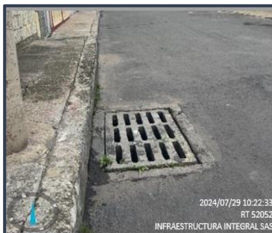
Ilustración 21 y 22 Protección de sumideros RT 52052 – ANTES – DURANTE Y DESPUES
