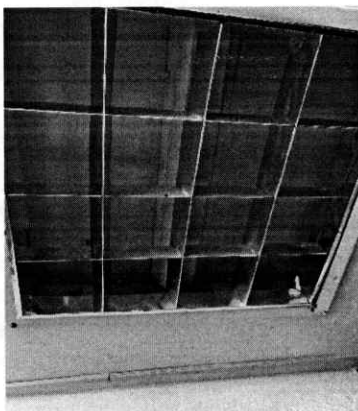
Foto 6, 7 y 8. Luminarias deterioradas en áreas administrativas.
