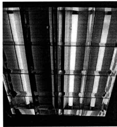
Foto 6, 7 y 8. Luminarias deterioradas en áreas administrativas.
